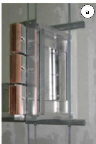
Fot. 8. Uszczelnienia przejść szynoprzewodów: a) szynoprzewody zabezpieczone płytami ogniochronnymi oraz farbą w ścianie; b) i c) szynoprzewody zabezpieczone wełną mineralną oraz farbą w ścianie; d) szynoprzewody zabezpieczone systemem modułowym
