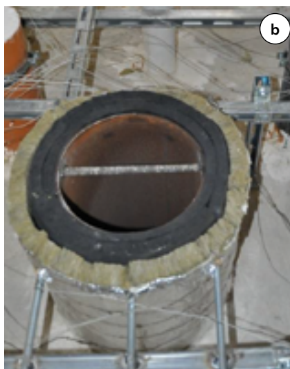
Fot. 6. Uszczelnienia przejść rur metalowych w izolacji palnej: a) rury zabezpieczone kołnierzem w ścianie; b) rury zabezpieczone opaską oraz wełną mineralną w ścianie
