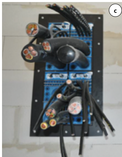
Fot. 3. Uszczelnienia przejść kabli: a)–c) kable zabezpieczone różnymi systemami modułowymi w ścianie; d) kable zabezpieczone workami z materiałem ogniochronnym
