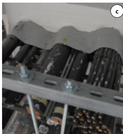
Fot. 1. Uszczelnienia przejść kabli: a) kable zabezpieczone farbą ogniochronną w ścianie; b) kable zabezpieczone farbą ogniochronną w stropie; c) kable zabezpieczone uszczelką pęczniącą w ścianie; d) kable zabezpieczone wełną mineralną i farbą ogniochronną w ścianie
