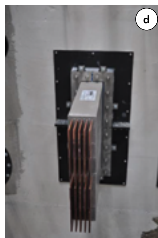
Fot. 8. Uszczelnienia przejść szynoprzewodów: a) szynoprzewody zabezpieczone płytami ogniochronnymi oraz farbą w ścianie; b) i c) szynoprzewody zabezpieczone wełną mineralną oraz farbą w ścianie; d) szynoprzewody zabezpieczone systemem modułowym
