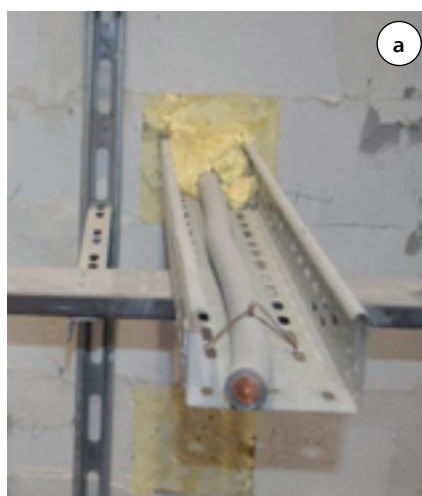
Fot. 2. Uszczelnienia przejść kabli: a) kable zabezpieczone pianą ogniochronną w ścianie; b) kable zabezpieczone pianą oraz dodatkową masą ogniochronną w ścianie
