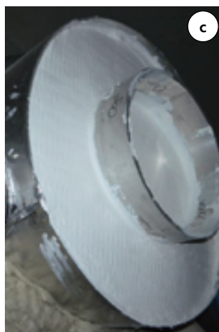
Fot. 8. Uszczelnienia przejść szynoprzewodów: a) szynoprzewody zabezpieczone płytami ogniochronnymi oraz farbą w ścianie; b) i c) szynoprzewody zabezpieczone wełną mineralną oraz farbą w ścianie; d) szynoprzewody zabezpieczone systemem modułowym
