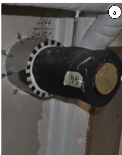
Fot. 6. Uszczelnienia przejść rur metalowych w izolacji palnej: a) rury zabezpieczone kołnierzem w ścianie; b) rury zabezpieczone opaską oraz wełną mineralną w ścianie
