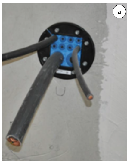
Fot. 2. Uszczelnienia przejść kabli: a) kable zabezpieczone pianą ogniochronną w ścianie; b) kable zabezpieczone pianą oraz dodatkową masą ogniochronną w ścianie
