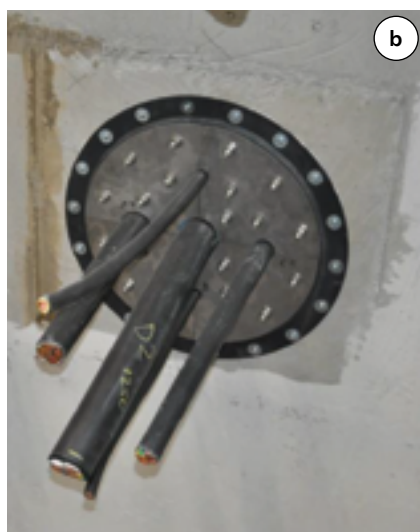
Fot. 2. Uszczelnienia przejść kabli: a) kable zabezpieczone pianą ogniochronną w ścianie; b) kable zabezpieczone pianą oraz dodatkową masą ogniochronną w ścianie
