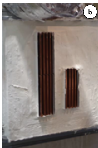
Fot. 8. Uszczelnienia przejść szynoprzewodów: a) szynoprzewody zabezpieczone płytami ogniochronnymi oraz farbą w ścianie; b) i c) szynoprzewody zabezpieczone wełną mineralną oraz farbą w ścianie; d) szynoprzewody zabezpieczone systemem modułowym
