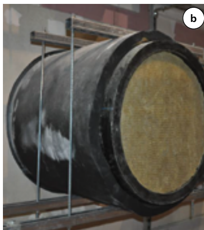
Fot. 7. Uszczelnienia przejść rur o dużych średnicach zabezpieczonych przy użyciu opasek oraz płyt ogniochronnych: a) rura stalowa, ø 610 mm; b) rura PE-HD, ø 710 mm
