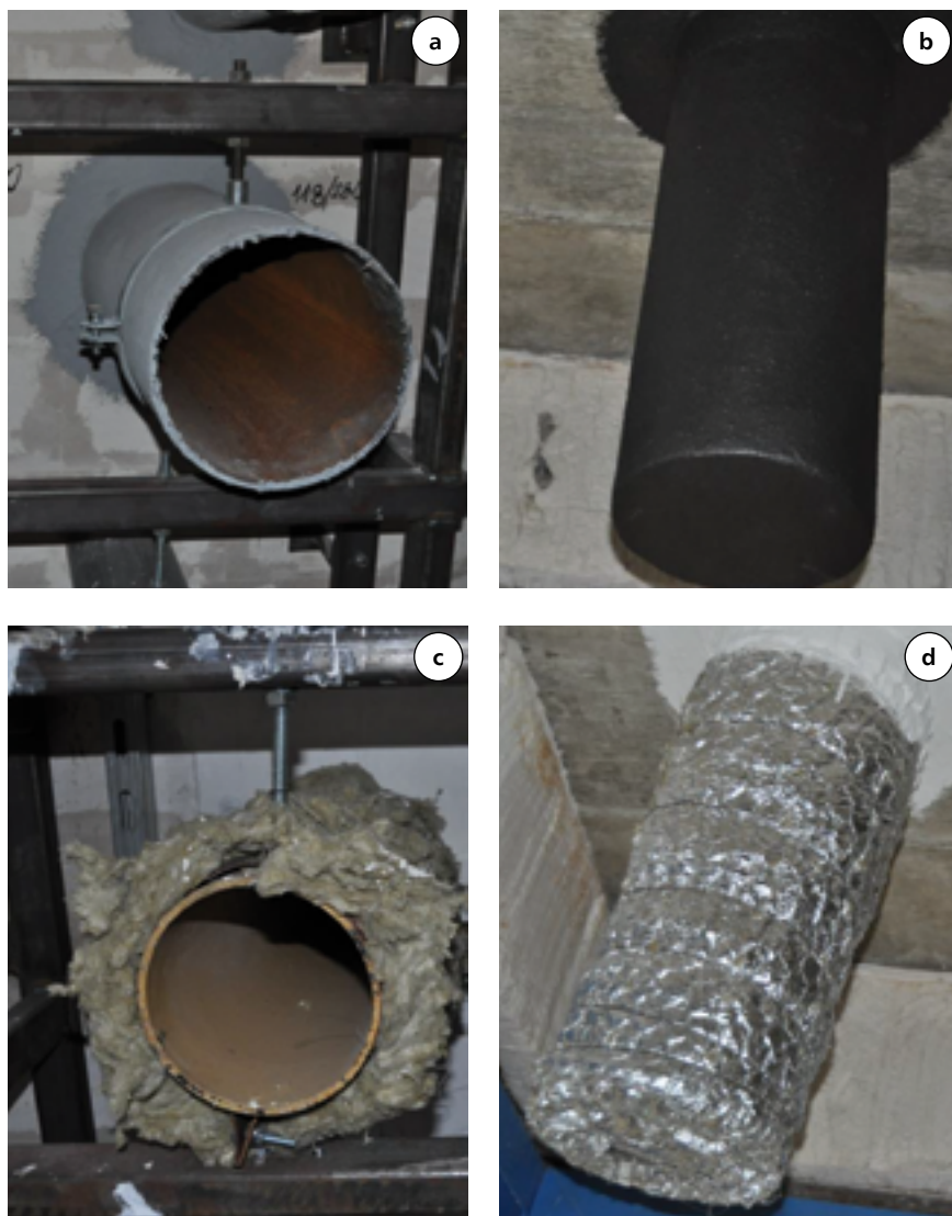
Fot. 4. Uszczelnienia przejść rur metalowych: a) rury zabezpieczone farbą ogniochronną w ścianie; b) rury zabezpieczone farbą ogniochronną w stropie; c) rury zabezpieczone wełną mineralną w ścianie; d) rury zabezpieczone wełną mineralną i farbą ogniochronną w stropie
