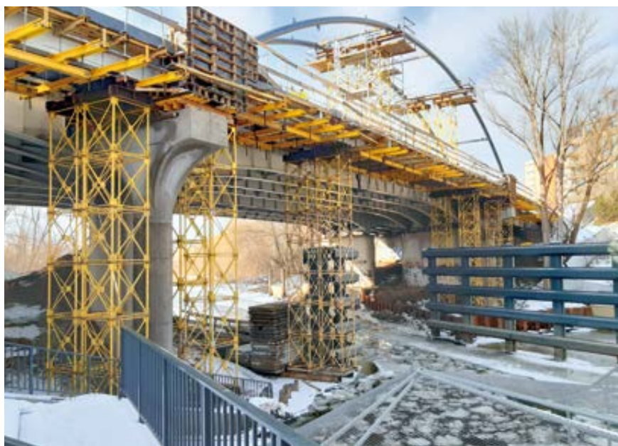
Fot. 7. Widok od dołu na rusztowania i konstrukcję kładki
