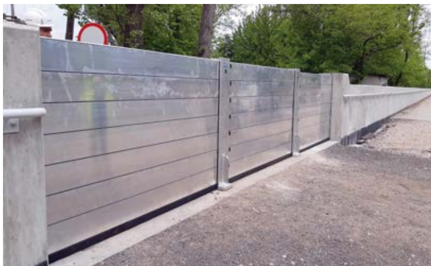
Fot. 4. Brama przeciwpowodziowa
