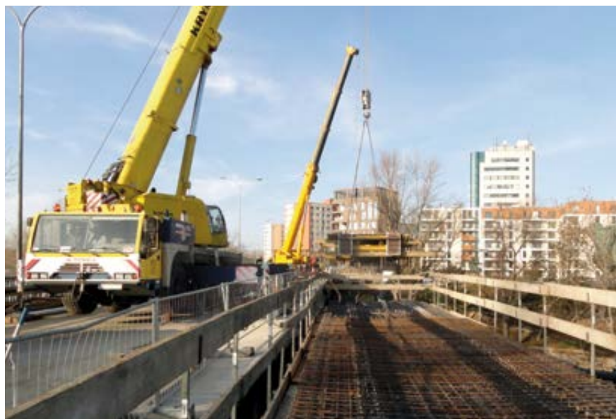
Fot. 6. Montaż segmentu kładki dwoma dźwigami
