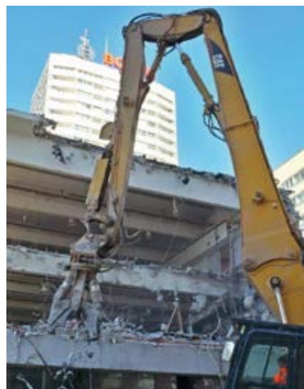
Fot. 3. Rozbiórka DT Sezam za pomocą koparki uzbrojonej w kleszcze
