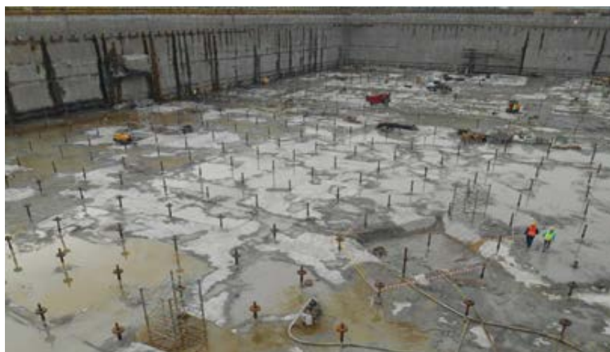
Fot. 1. Widok korka po oczyszczeniu i uszczelnieniu, widoczne mikropale z płytami kotwiącymi
