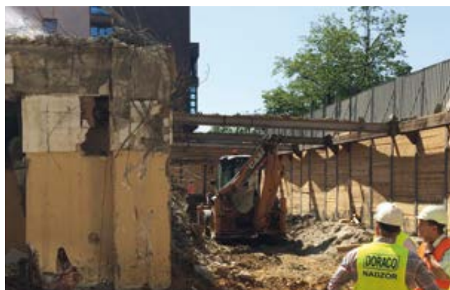
Fot. 4. Tymczasowe podparcie ściany berlińskiej o konstrukcję piwnic DT Sezam
