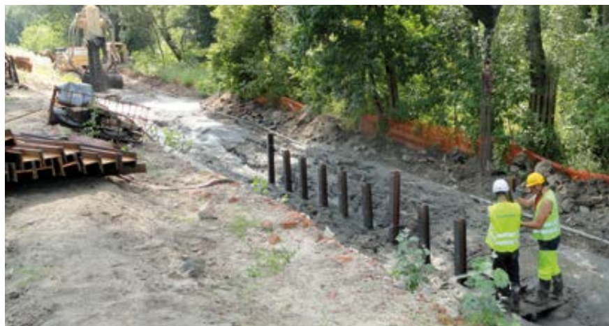
Fot. 1. Formowanie przesłony trenczerem i osadzanie dwuteowników
