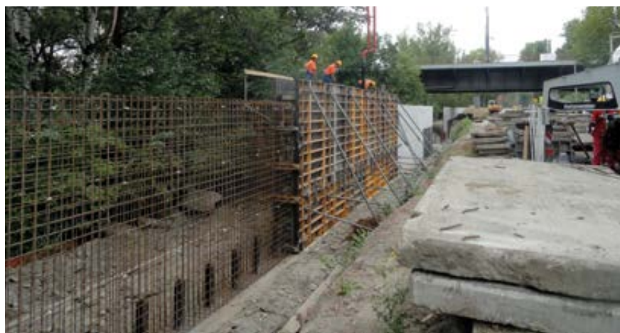
Fot. 2. Realizacja muru oporowego
