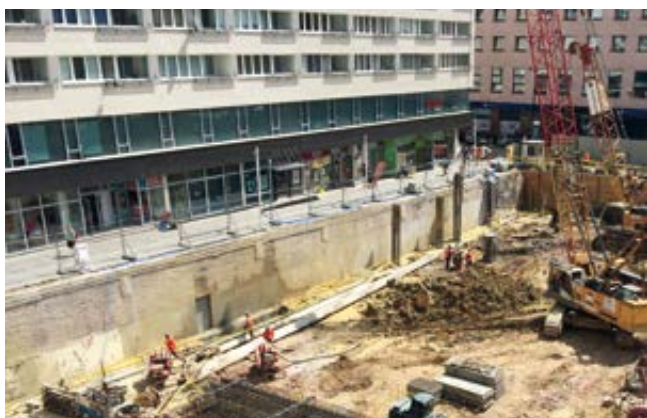
Fot. 2. Oddzielenie konstrukcji podziemnej DT Sezam od piwnic pasażu Rowickiego
