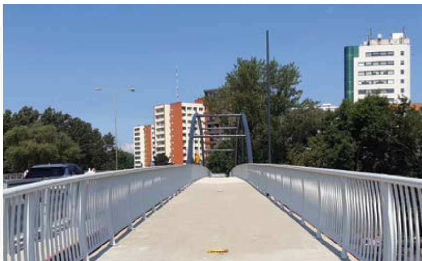
Fot. 8. Kładka gotowa do użytku
