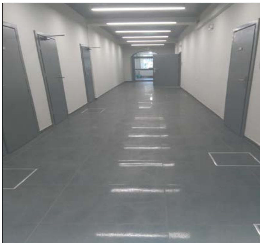
Fot. Uciążliwe oślnienie: a) lampy zainstalowano na czarnym suficie, widoczne są z zamgleniem wokół ich kształtu, b) występują jaskrawe odbicia lamp w czarnej posadzce
