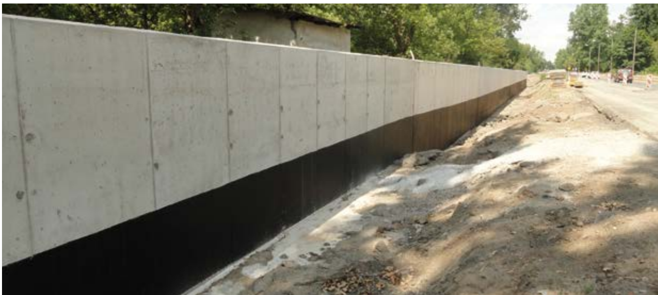
Fot. 3. Mur oporowy wzdłuż zoo
