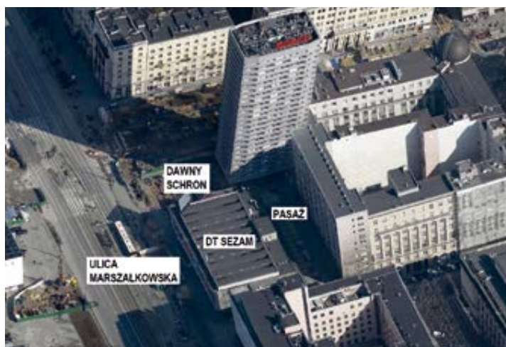
Rys. 1. Lokalizacja budynku DT Sezam wg Google Maps (2016 r.)
