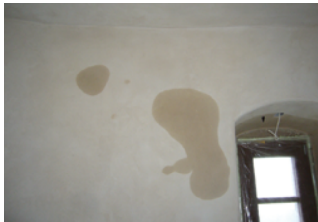
Fot. 1, 2. Na łączne oddziaływanie wody opadowej i wiatru narażone są szczególnie obiekty wysokie, zlokalizowane w strefie często występujących opadów atmosferycznych, zwłaszcza w miejscach pozbawionych naturalnych przeszkód i wystawionych na ekspozycję czynników atmosferycznych; zdjęcia pokazują rezultaty oddziaływania wody opadowej i wiatru na wieżę zamkową
