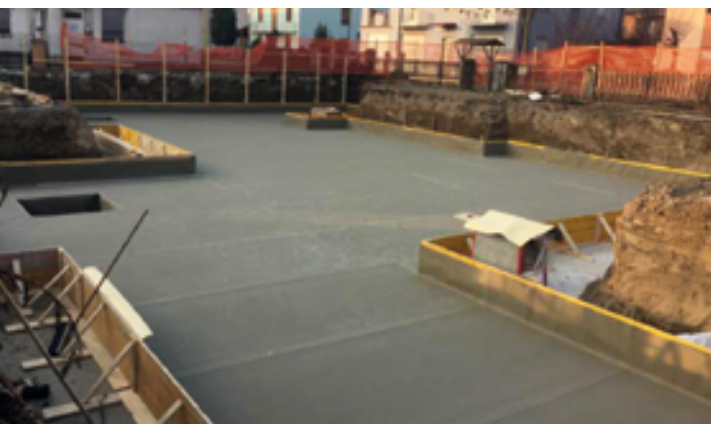
Typowe zastosowanie SikaProof® A+ na płycie fundamentowej
