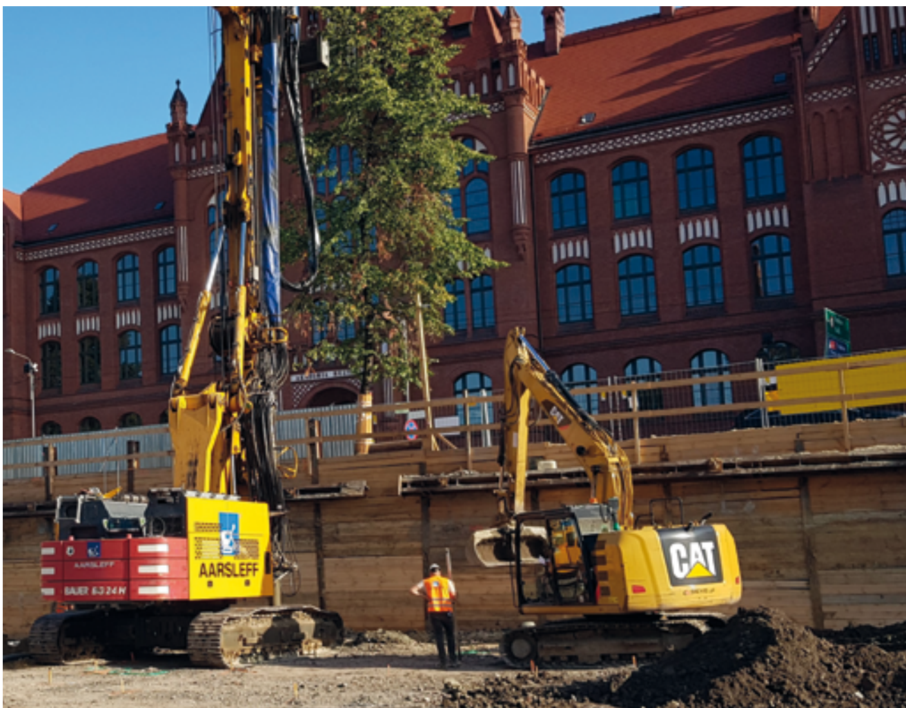
Fot. 2. Wykonanie kolumn przemieszczeniowych
