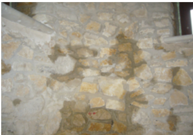
Fot. 1, 2. Na łączne oddziaływanie wody opadowej i wiatru narażone są szczególnie obiekty wysokie, zlokalizowane w strefie często występujących opadów atmosferycznych, zwłaszcza w miejscach pozbawionych naturalnych przeszkód i wystawionych na ekspozycję czynników atmosferycznych; zdjęcia pokazują rezultaty oddziaływania wody opadowej i wiatru na wieżę zamkową
