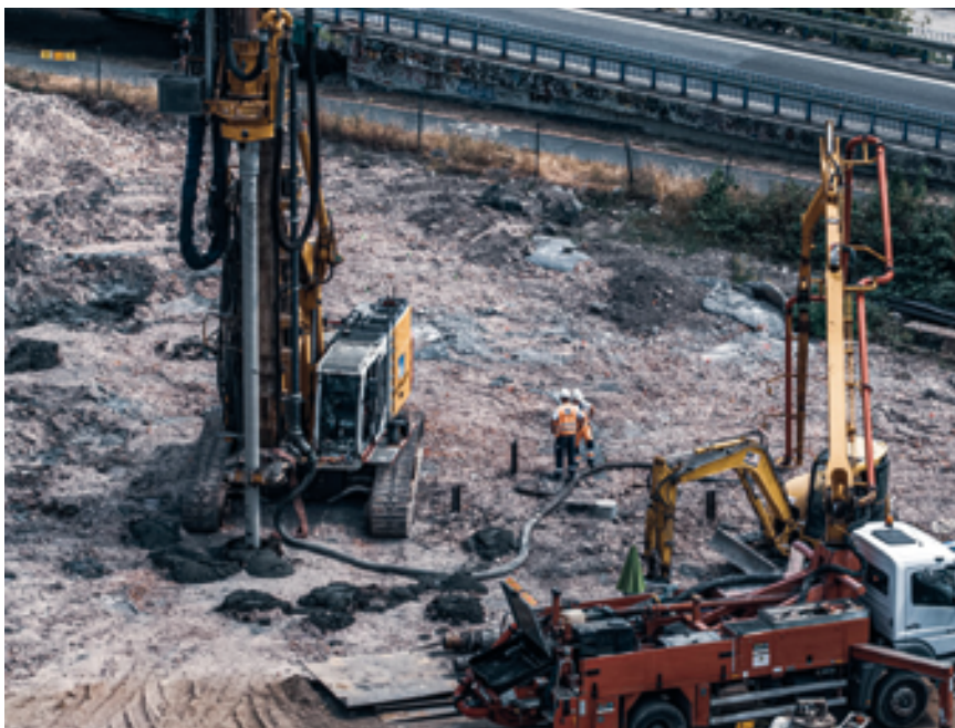
Fot. 1. Formowanie kolumn przemieszczeniowych
