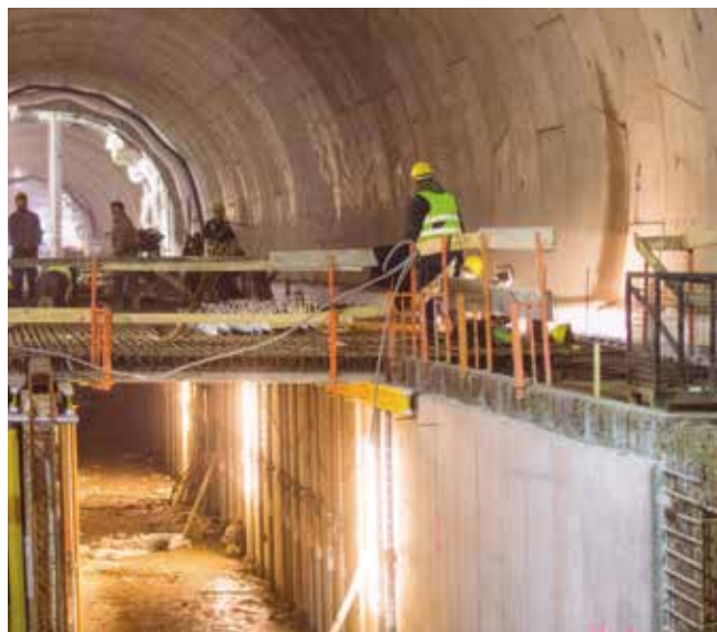
Fot. 2. Budowa konstrukcji trójnawowej w tunelu drążonym
