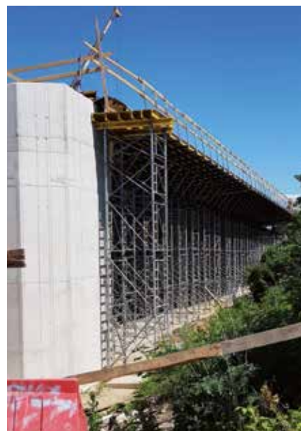
Fot. 3. Rusztowanie podporowe
