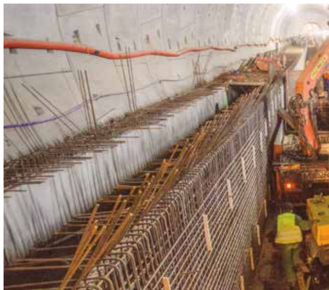
Fot. 3. Zbrojenie ścian wewnętrznych
