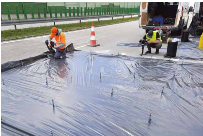
Fot. 3. Zabezpieczanie nawierzchni
