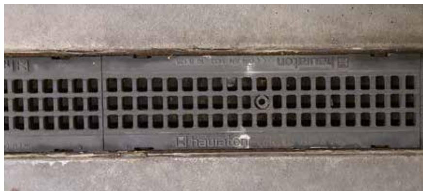
Fot. 4. Wylugowanie masy uszczelniającej na styku krawędzi podłużnej profilu korytka i warstwy posadzki
