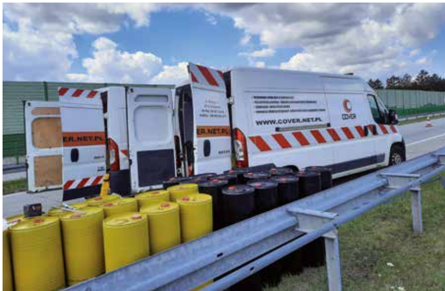
Fot. 2. Materiał iniekcyjny w przenośnych metalowych beczkach
