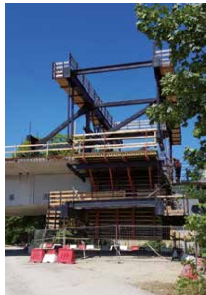
Fot. 2. Rusztowanie do budowy mostów
