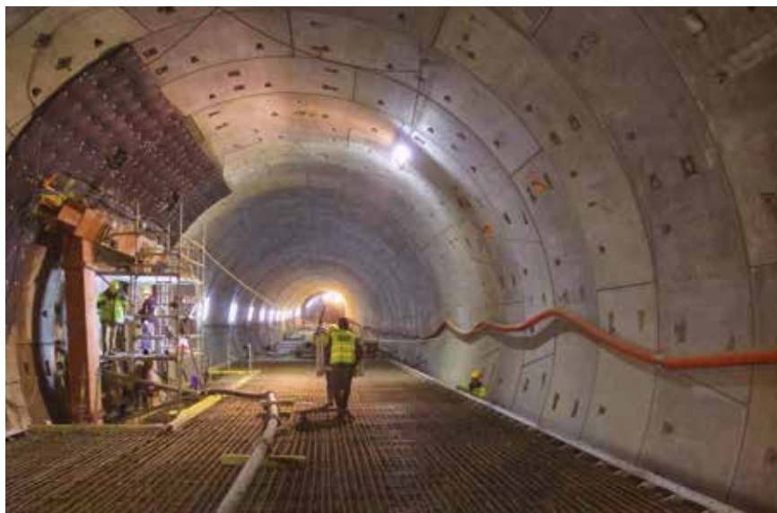
Fot. 4. Układanie płyt ogniochronnych
