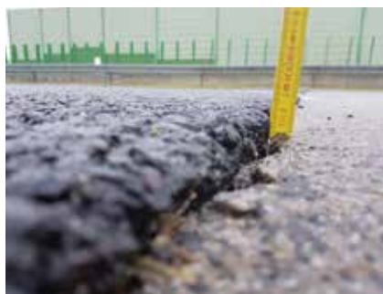
Fot. 1. Nawiercone otwory iniekcyjne w płytach drogowych
