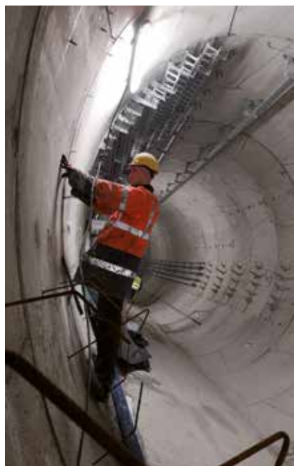
Fot. 4. Osadzanie pakerów iniekcyjnych w szczelinach tubingów
