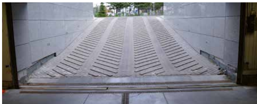
Fot. 2. Korytka odwodnienia liniowego wzdłuż bramy garażowej
