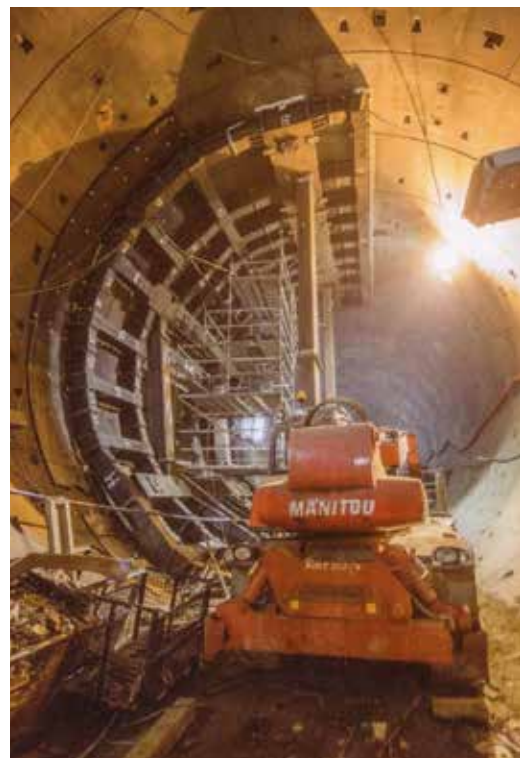
Fot. 1. Otwieranie przejścia poprzecznego z pierwszej rury tunelu
