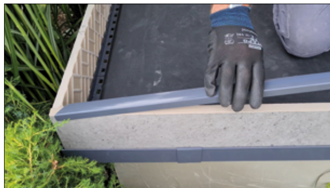
Fot. 4. Klejenie powłoki wodochronnej z membrany EPDM
