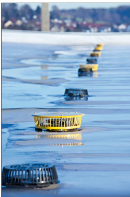
Wpusty główne (czarny koszyk) i towarzyszące wpusty awaryjne (żółty element spiętrzający)
