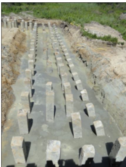
Fot. 2. MS-2a, pale 40 x 40 x 900 cm białe pod podporę 1 na stronie zachodniej
