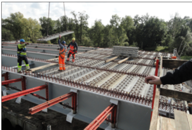
Fot. 4. MS-2a, deskowanie przęsła jezdni głównej deskami żelbetowymi (filigranami)
