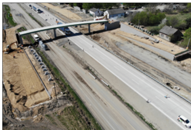
Fot. 11. KŁ-3a, kładka zabetonowana, pochylnie z gruntu zbrojonego w trakcie realizacji
