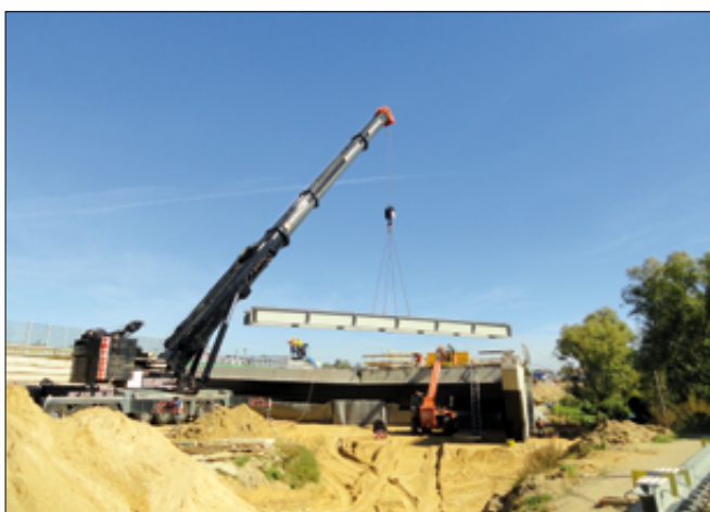
Fot. 6. MS-2a, montaż tandemów konstrukcji po stronie wschodniej
