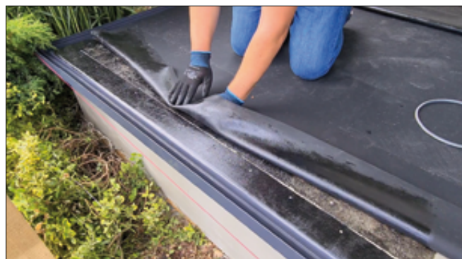
Fot. 4. Klejenie powłoki wodochronnej z membrany EPDM
