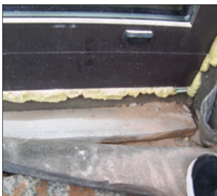
Fot. 20. Montaż drzwi w progu na „piankę PU, styropian, gruz i kawałki papy” – bardzo powszechny, niemal 80% przypadków
