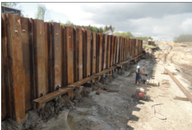
Fot. 1. Obiekt MS-2a, ścianka kotwiona zabezpieczająca fundamenty zachodniej jezdni
