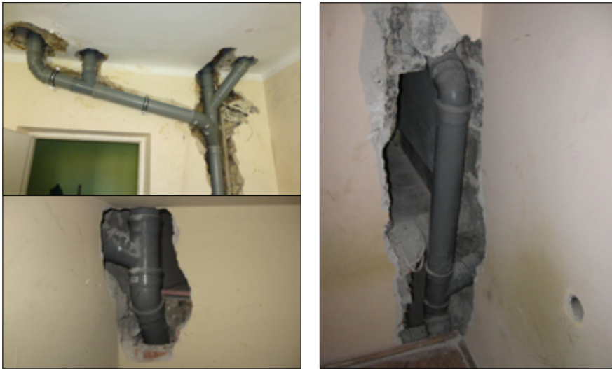
Fot. 5. Piony kanalizacyjne w trakcie modernizacji (hydratec.pl; generalnyremontdomu.blogspot.com)
