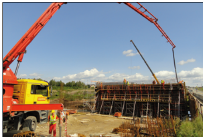
Fot. 3. MS-2a, betonowanie przyczółka nr 2 jezdni głównej po stronie zachodniej
