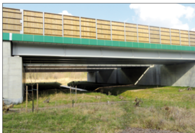
Fot. 7. MS-2a, widok zakończonego obiektu, widać aranżację przejścia dla dużych zwierząt
