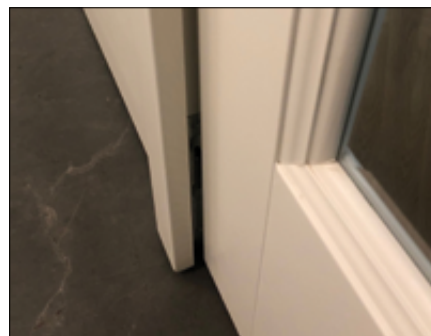
Fot. 14. Przykład drzwi dwuskrzydłowych. Inwestor nie wyraził zgody na dziurawienie podłogi: na wsuwany bolec kantrygla. W efekcie drzwi nie są zaryglowane
