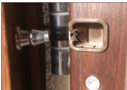
Fot. 16. Drzwi antywłamaniowe z plastikowym gniazdem na stalowy bolec antywłamaniowy. Gniazdo wyrwane po lekkim uderzeniu zamkniętych drzwi
