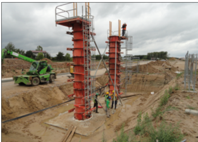
Fot. 8. WD-3, formy słupów podpory nr 4
