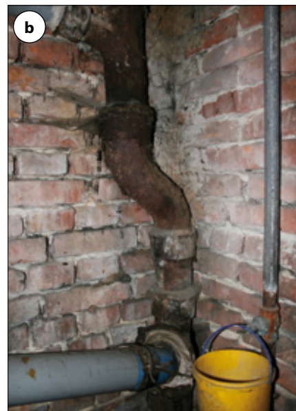
Fot. 1. Widoczne uszkodzenia elementów pionów kanalizacyjnych: a) pęknięty trójnik PVC, b) skorodowany pion żeliwny (wyciek.pl; alchemiawolnosci.blogspot.pl)
