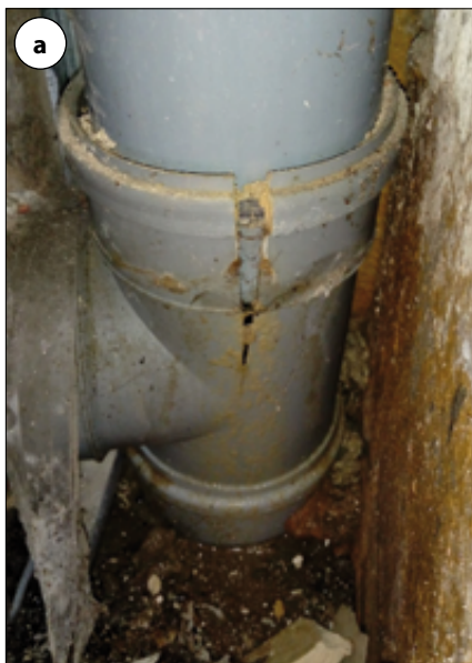
Fot. 1. Widoczne uszkodzenia elementów pionów kanalizacyjnych: a) pęknięty trójnik PVC, b) skorodowany pion żeliwny (wyciek.pl; alchemiawolnosci.blogspot.pl)
