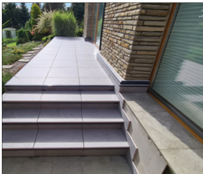
Fot. 1. Taras naziemny i schody z posadzką na podstawkach dystansowych
