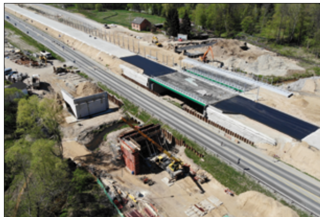
Fot. 5. MS-2a, widok robót wiosną 2018 – na ukończeniu jezdni zachodniej i podpory jezdni lokalnej wschodniej
