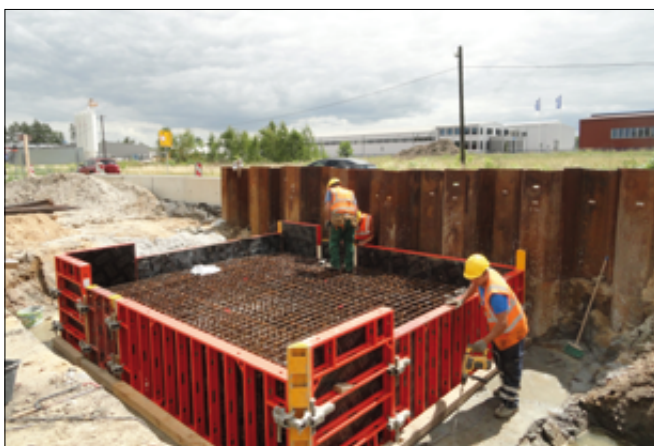
Fot. 10. KŁ-3a, deskowanie i zbrojenie fundamentu nr 3 kładki i ścianka zabezpieczająca
