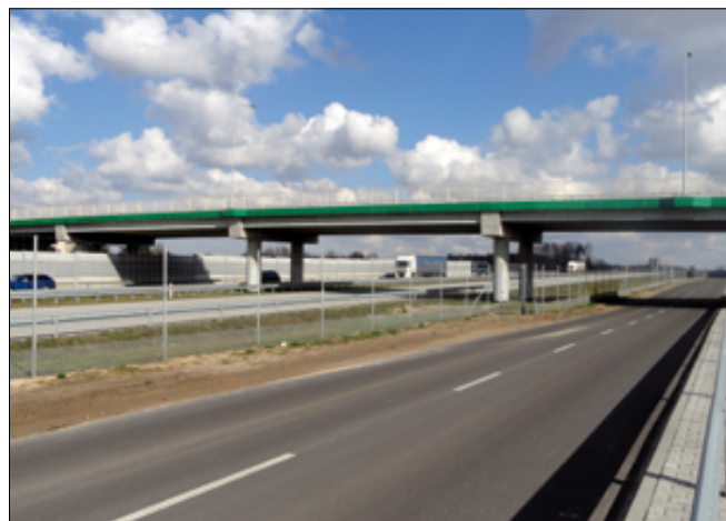
Fot. 9. Wiadukt WD-3 od strony południowej
