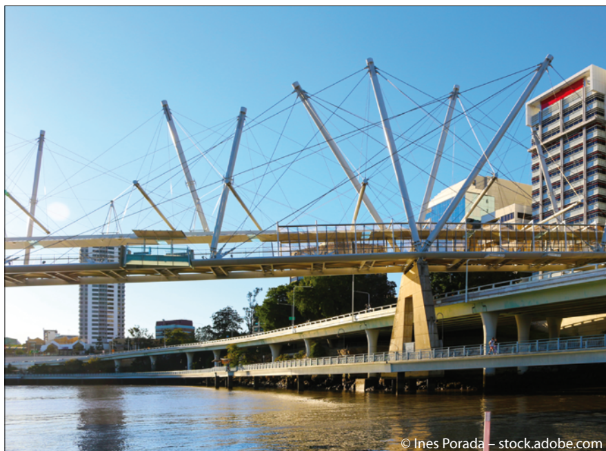
Fot. 7. Kładka typu tensegrity Kurilpa Bridge, Australia
