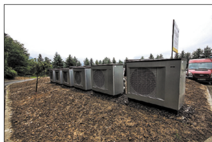
Fot. 1. Kaskada pomp ciepła w ośrodku „Biawena” w Wysowej-Zdrój (fot. NIBE)
