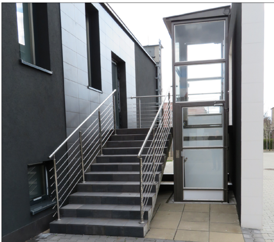
Fot. 1. Dźwig osobowy dla osób niepełnosprawnych
