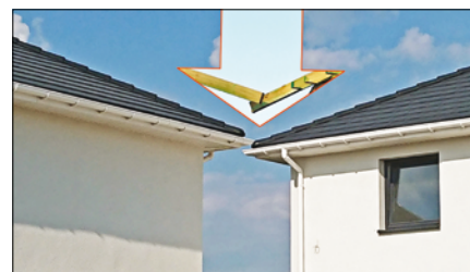
Fot. 5. Budynki jednorodzinne budowane przez dewelopera na jednej działce (fot. E.I. Kotwica)
