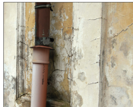
Fot. 7 i 8. Nieprawidłowe połączenia rur spustowych na elewacji wschodniej
