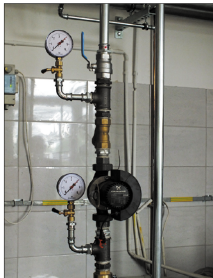
Fot. 2. Pomiary podczas montażu pompy ciepła
