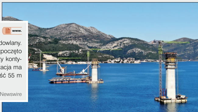
Budowa mostu Pelješać przy wykorzystaniu żurawi wieżowych i urządzeń dźwigowych Zoomlion
