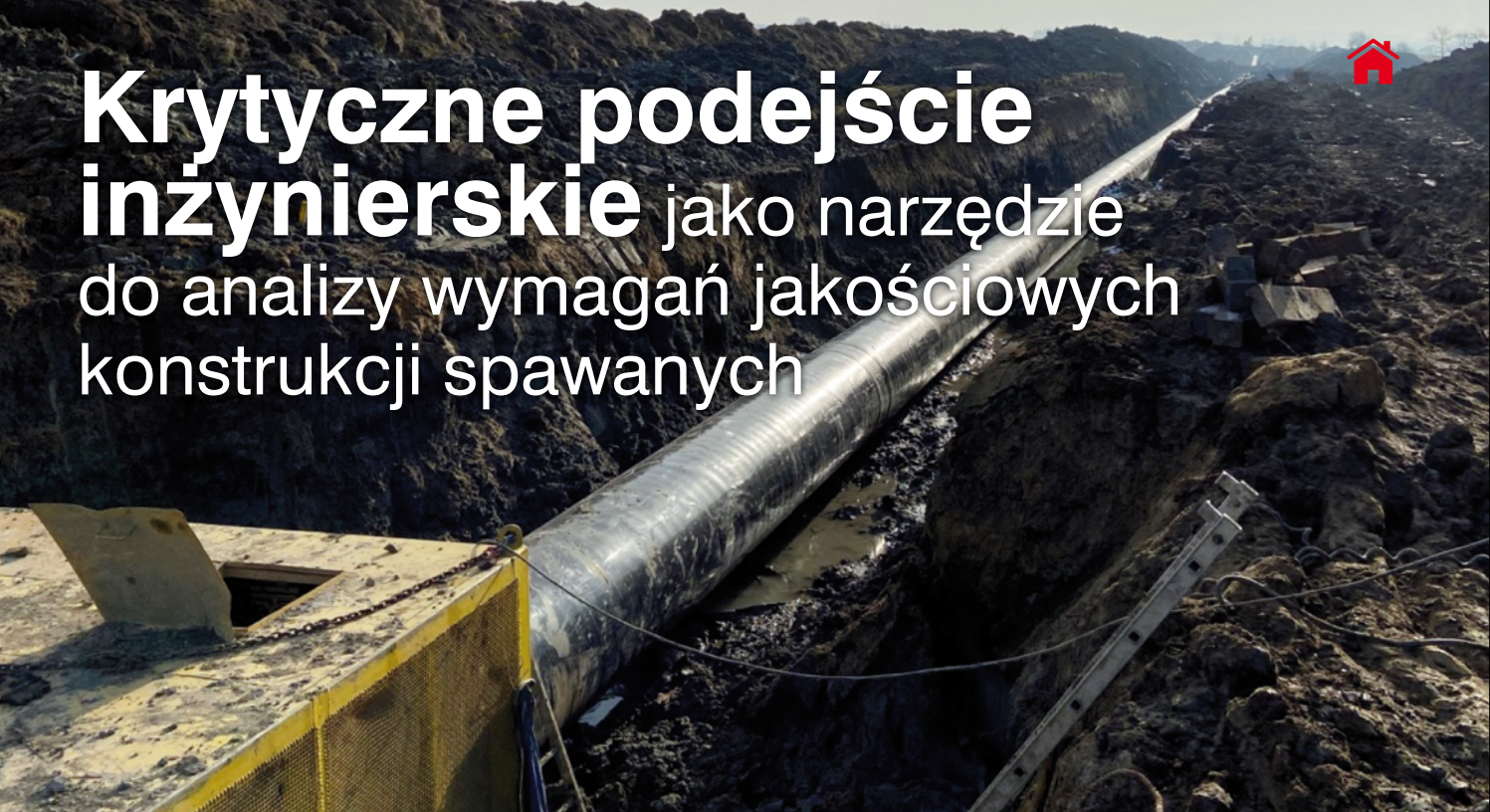
Fot. Budowa gazociągu Strachocina – granica RP (fot. autora)
