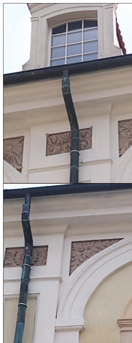
Fot. 12 i 13. Nieszczelne połączenie wpustu z rynny do miedzianej rury spustowej
