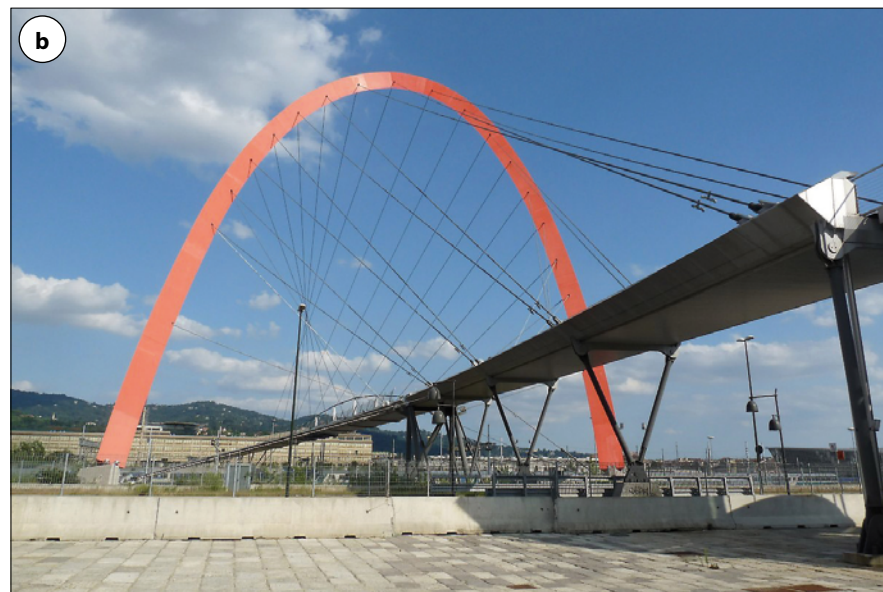
Fot. 4. Układy podwieszane w kładkach: a) kładka podwieszona z zakrzywionym pylonem; b) kładka łukowo-ciężnowa
