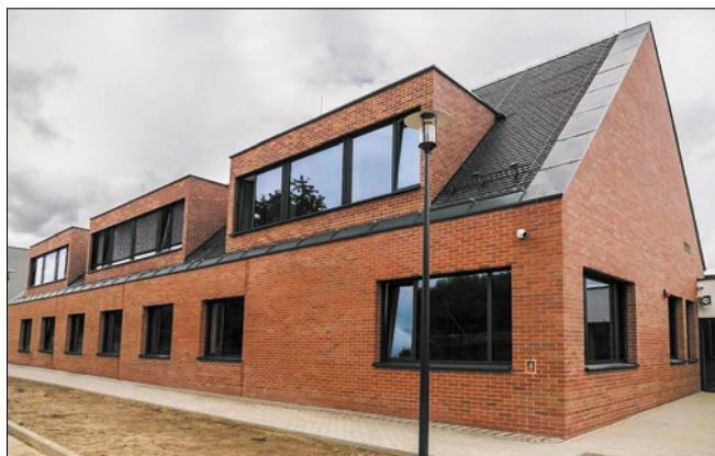
Fot. 4. Nowoczesna bryła szkoły w Żukowie (fot. ABB)
