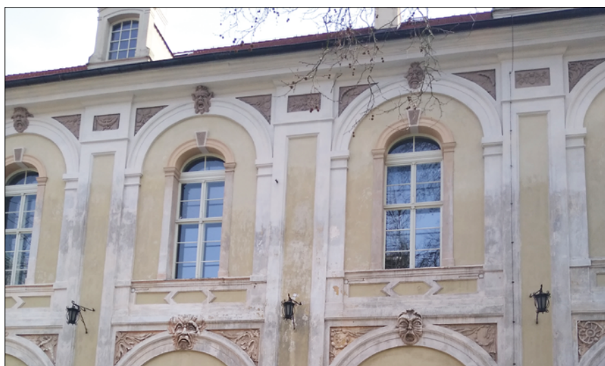
Fot. 9. Naprawiona elewacja wschodnia
