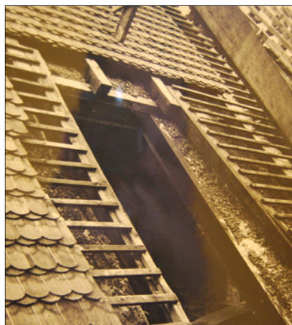
Fot. 3 i 4. Zdjęcia dachu pałacu zrobione w 1972 r. [3] (fot. M. Świątek)
