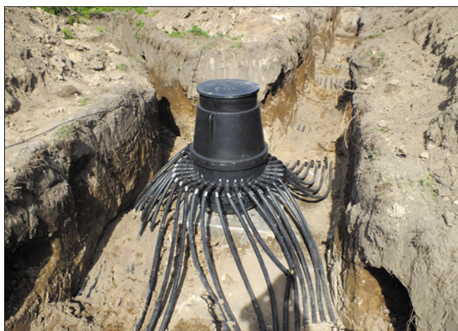
Fot. 6. Odwiert pod sondę głębinową (przedszkole w Gniazdowie)
