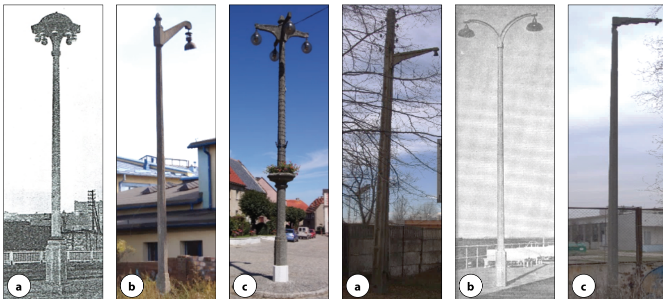
Fot. 1. Niemieckie wysięgniki z betonu [8]: a) plafon [3], b) 1-ramienny (Gdańsk), c) 4-ramienny (Dobromierz)
