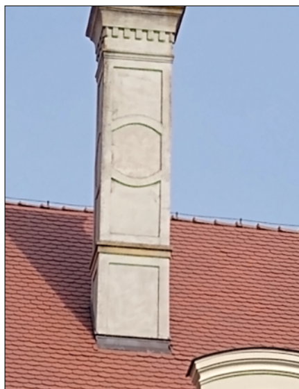
Fot. 10. Otynkowany komin
