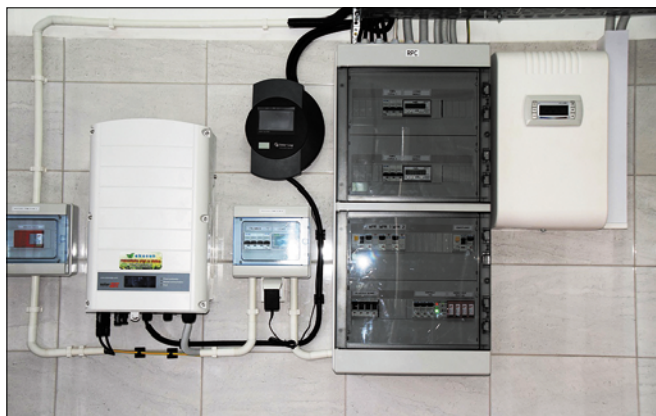
Fot. 3. Sterowanie i okablowanie maszynowni węzła cieplnego z pompami ciepła
