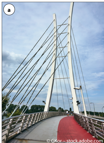
Fot. 4. Układy podwieszane w kładkach: a) kładka podwieszona z zakrzywionym pylonem; b) kładka łukowo-ciężnowa
