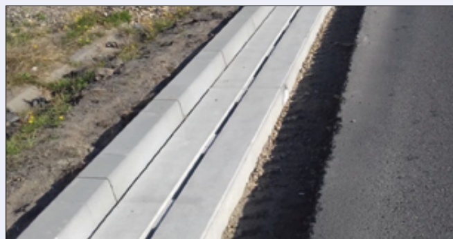
Fot. 5. Ściek szczelinowy
