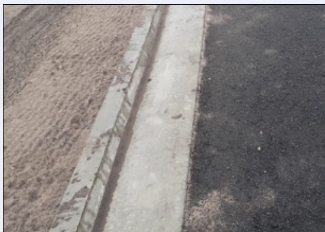
Fot. 1. Trójkątny ściek monolityczny jako element odwodnienia jezdni klasy S
