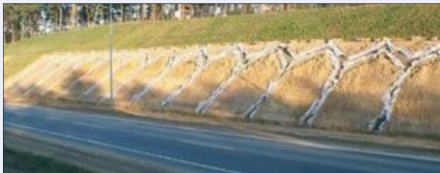
Fot. 6. Drenaż skarpy przyporowy na skarpie drogowej
