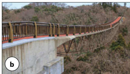
Fot. 2. Modyfikowane kładki wstęgowe: a) kładka nad drogą R3508 k. Ołomuńca w Czechach; b) kładka Morino-Wakuwaku Bridge w Japonii
