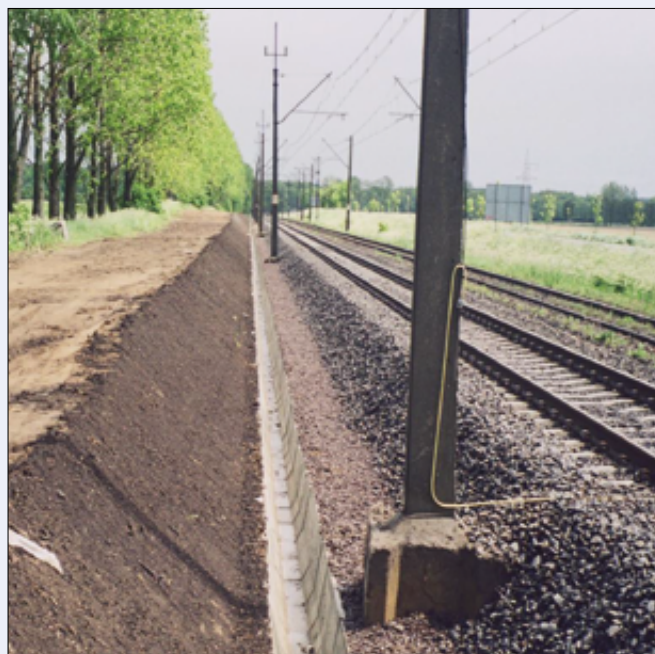
Fot. 3. Rów umocniony korytkami krakowskimi
