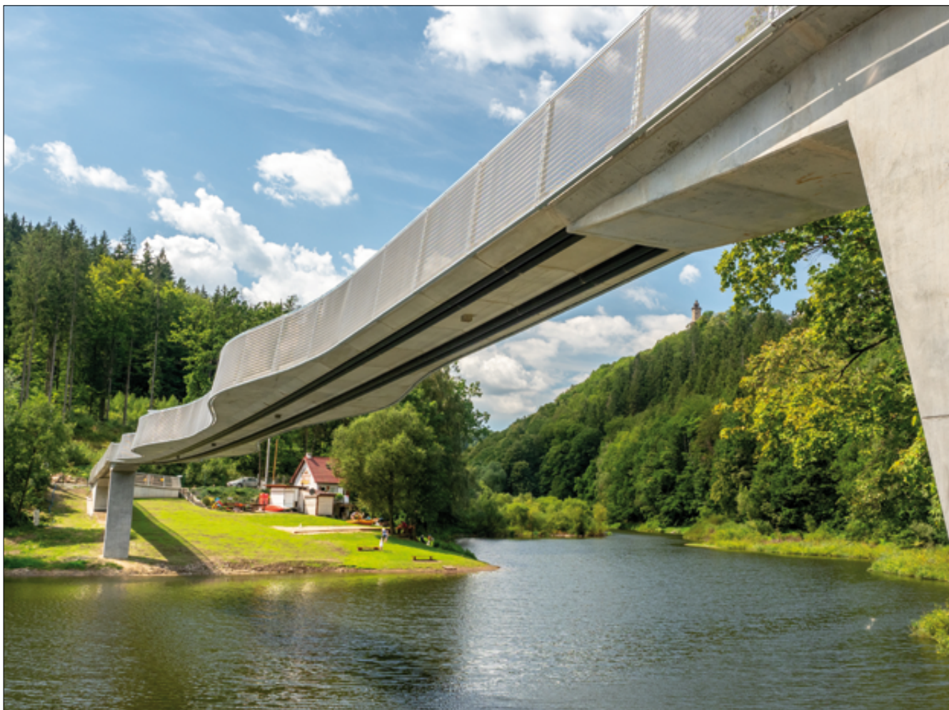
Fot. 1. Betonowa kładka wstęgowa w Zagórz Śląskim, woj. dolnośląskie (fot. Strabag Polska)
