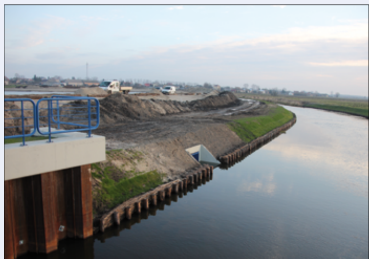
Fot. 4. Wlot rurociągu umożliwiającego napełnianie zbiornika. Pierwsze „nalanie” niecki zajęło sześć dni (fot. B. Klem)
