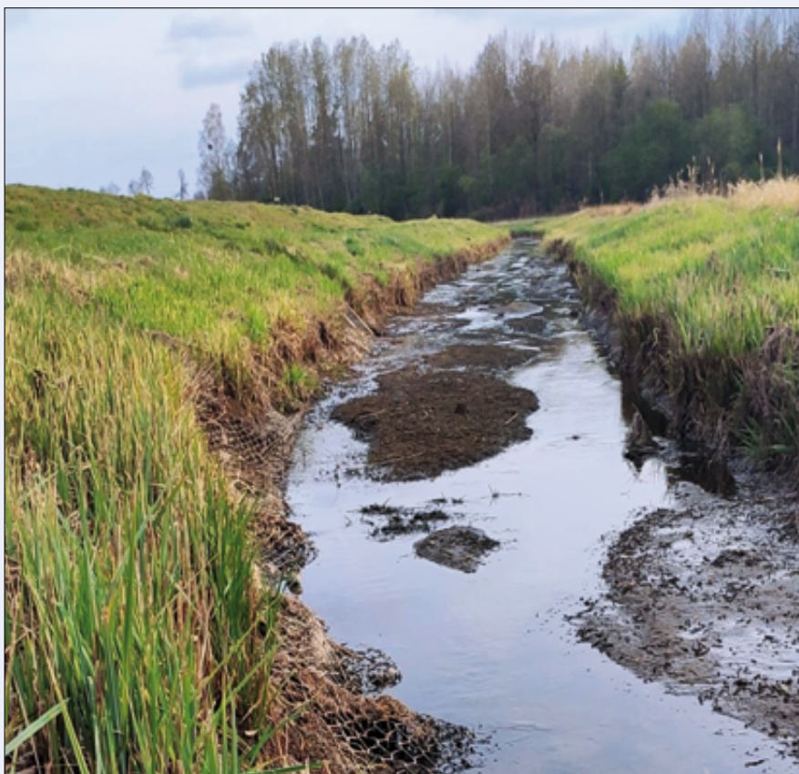
Fot. 3. Brak wody w uregulowanym korycie rzeki Supraśl w kwietniu 2020 r., jaki nastąpił w wyniku niekontrolowanego blokowania odpływu przez rolników przez wrzucenie do rzeki beł siana (fot. J. Grygoruk)
