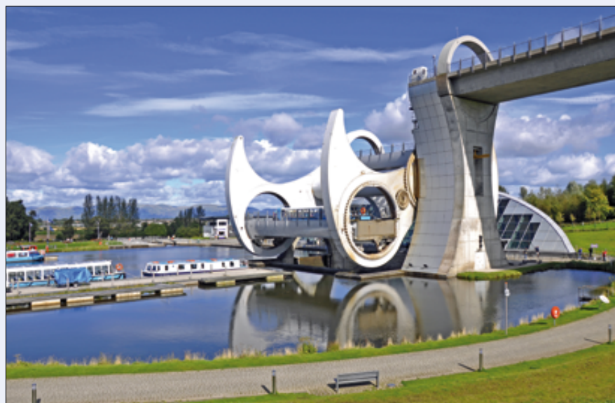
Fot. 1. Podnośnia obrotowa Falkirk Wheel w Szkocji między kanałem Forth and Clyde a kanałem Union (fot. Waldteufel – stock.adobe.com)
