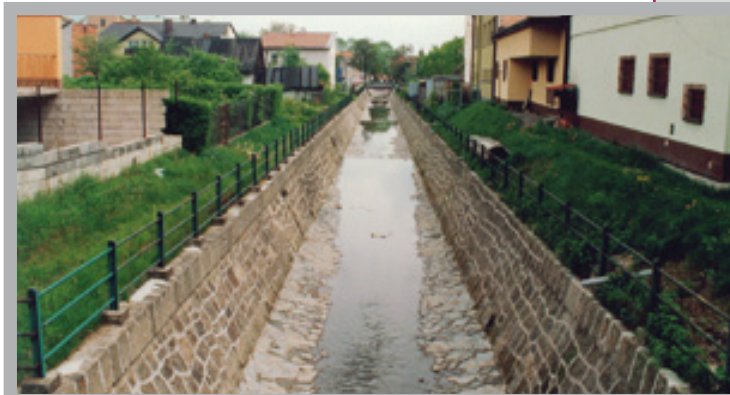
Potok Bysinka w Myślenicach – usunięte szkody popowodziowe
