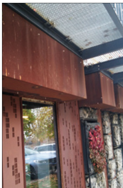
Fot. 1. Stalowa elewacja wentylowana ze stali typu Corten (fot. autora)
