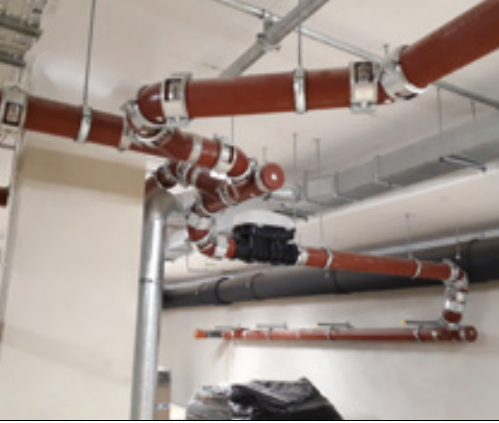
System SMU® zastosowano w hotelu Radisson Blu w Zakopanem
