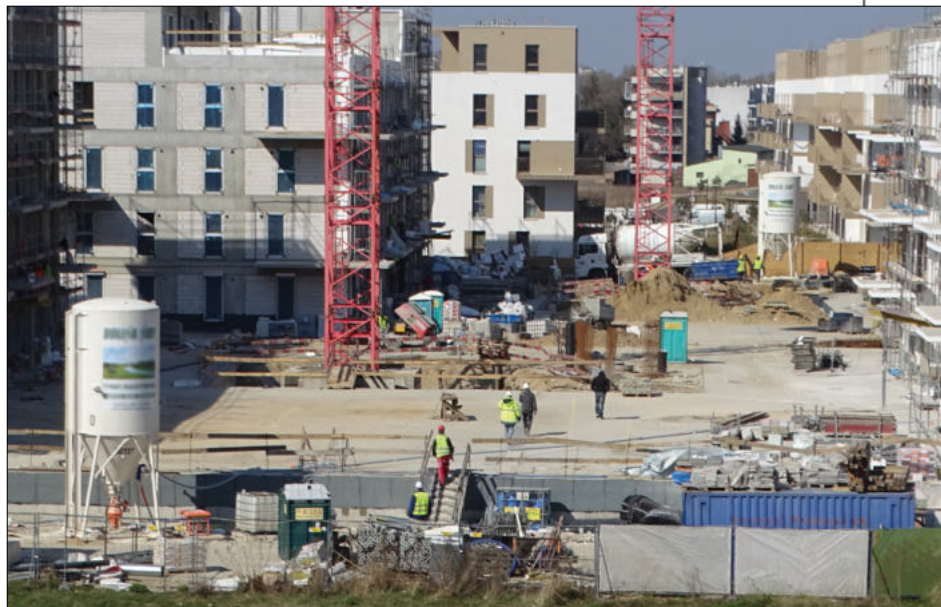
Budowa domów mieszkalnych przy ul. Lazurowej w Warszawie, kwiecień 2020 r. (fot. K. Wiśniewska)
