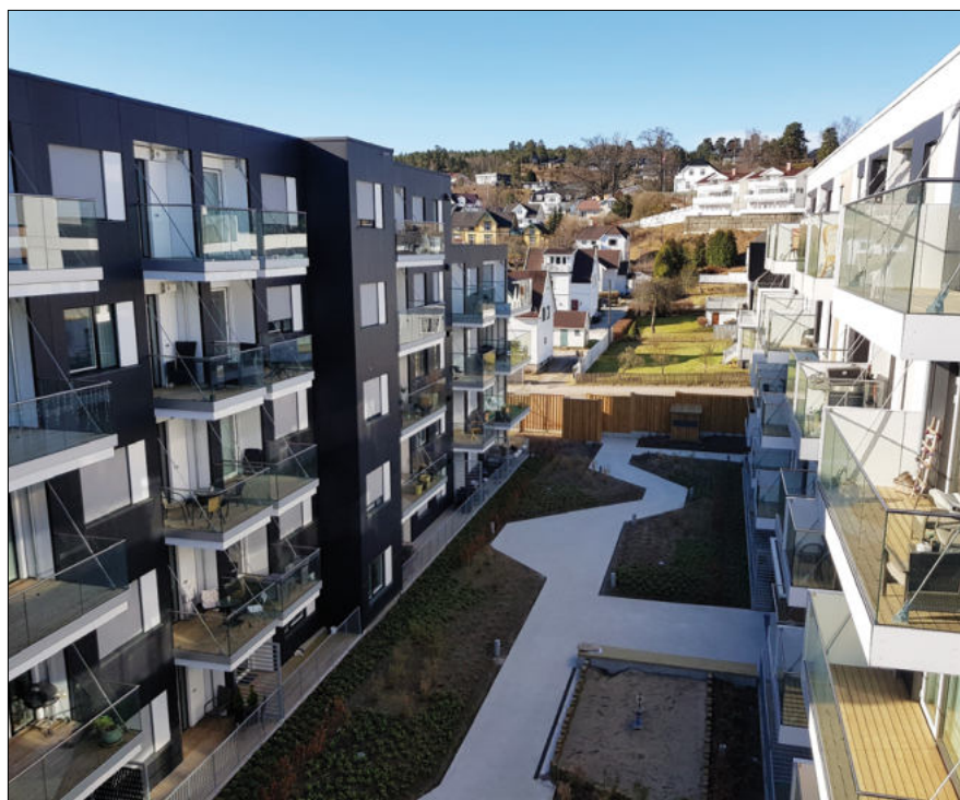
Fot. 2. Przykłady elementów budownictwa modułowego
