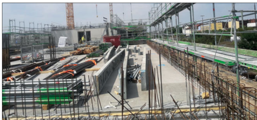
Fot. 3. Rusztowanie wyprzedzające z zabezpieczeniem krawędzi stropu
