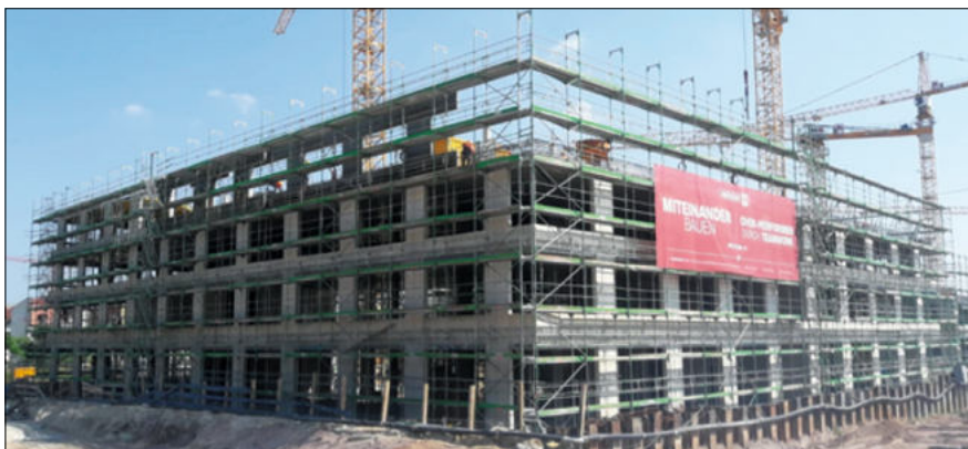
Fot. 5. Rusztowanie wyprzedzające z klatkami schodowymi
