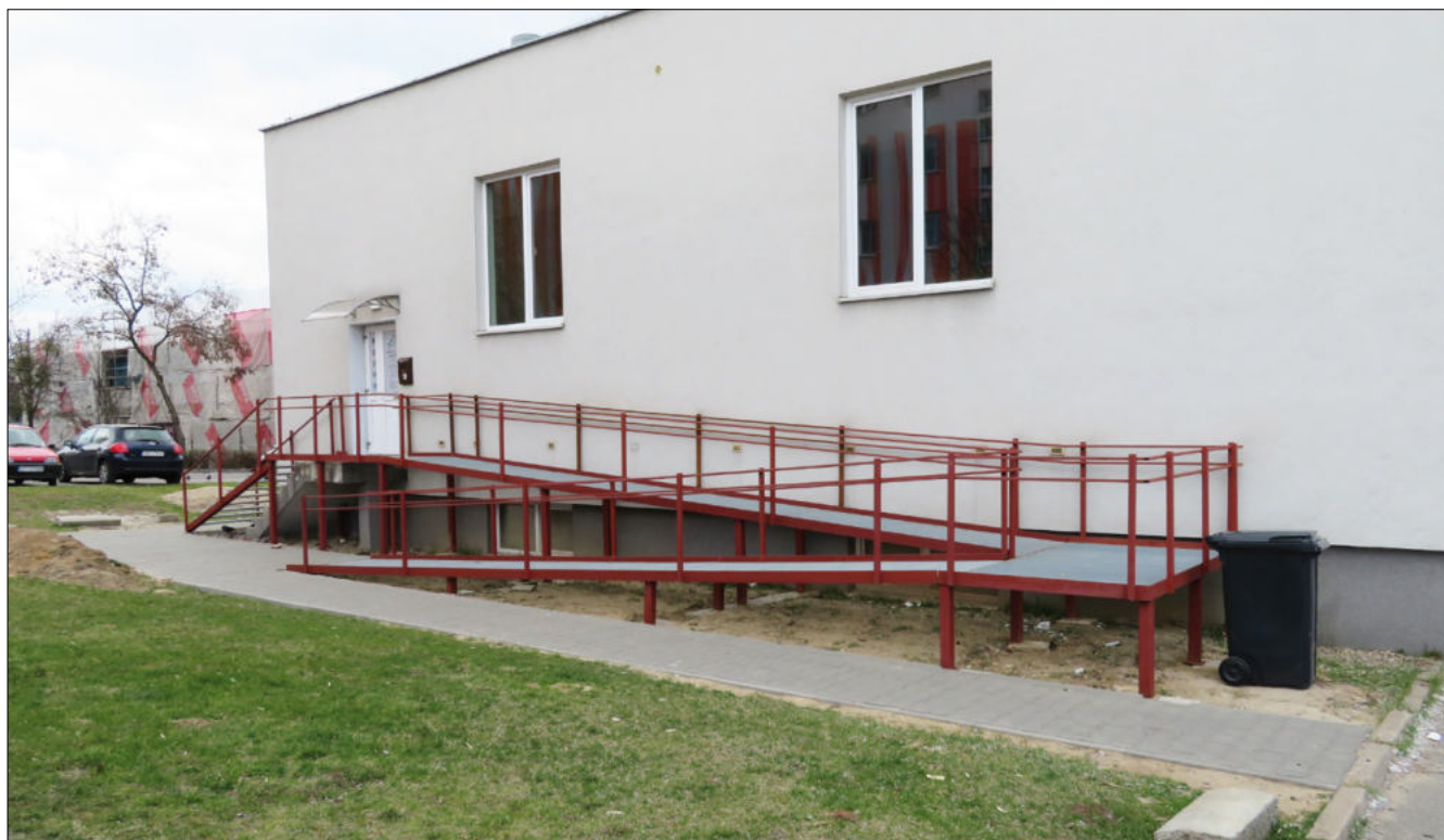
Fot. 1. Budowa pochylni dla osób niepełnosprawnych
