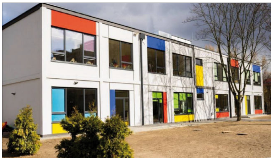
Fot. 3. Budynek przedszkola wzniesiony z elementów modułowych (źródło: www.climatic.pl)
