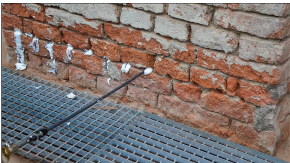
Fot. 2. Tworzenie bariery przeciwwilgociowej metodą iniekcji chemicznej kremem iniekcyjnym
