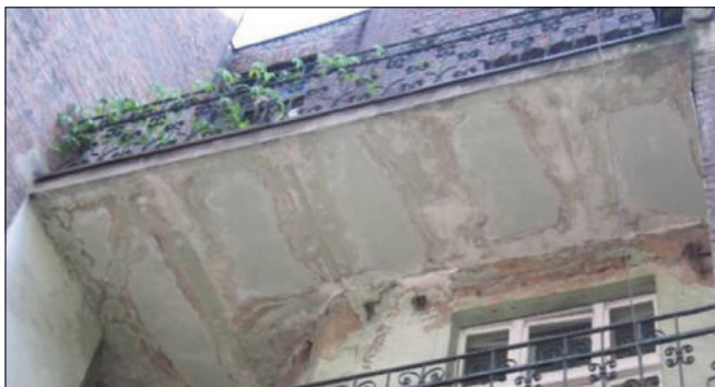
Fot. 4. Przecieki przez płytę balkonu w okolicy stalowych belek nośnych (z lewej) oraz uszkodzenia korozyjne belek i mrozowe płyty ceramicznej i wypraw tynkarskich (z prawej)
