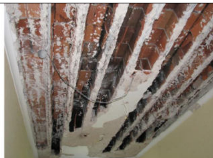
Fot. 7. Uszkodzenia stropu Ackermana powstałe w wyniku korozji zbrojenia żeber
