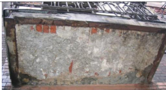
Fot. 4. Przecieki przez płytę balkonu w okolicy stalowych belek nośnych (z lewej) oraz uszkodzenia korozyjne belek i mrozowe płyty ceramicznej i wypraw tynkarskich (z prawej)
