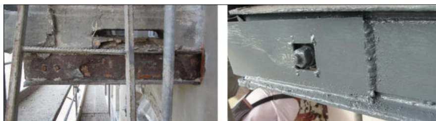
Fot. 14. Belka wspornikowa balkonu przed (po lewej) i po wzmocnieniu (po prawej)
