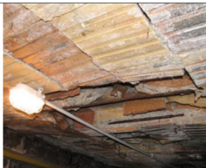
Fot. 7. Uszkodzenia stropu Ackermana powstałe w wyniku korozji zbrojenia żeber
