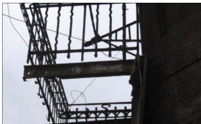
Fot. 4. Przecieki przez płytę balkonu w okolicy stalowych belek nośnych (z lewej) oraz uszkodzenia korozyjne belek i mrozowe płyty ceramicznej i wypraw tynkarskich (z prawej)
