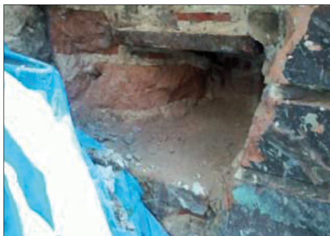
Fot. 12. Otwór po wyjęciu wspornikowej belki balkonu
