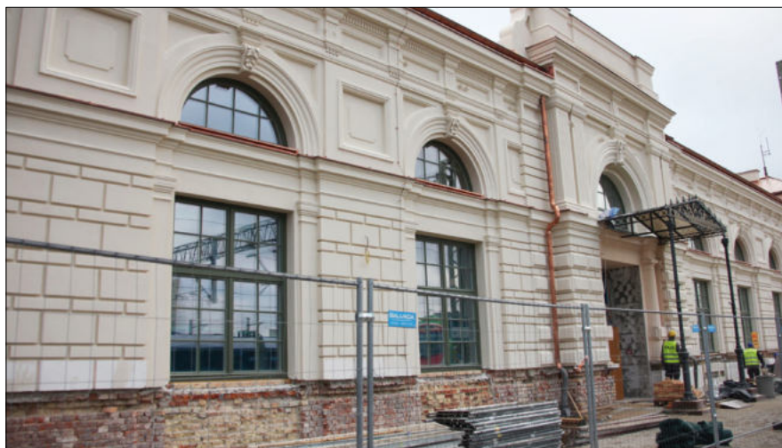
Wystrój zewnętrzny zabytkowych ścian to odtworzenie boniowania, gzymsów ciągniętych i fryzów kostkowego na murach ceglanych – w korpusie głównym dworca (fot. B. Klem)
