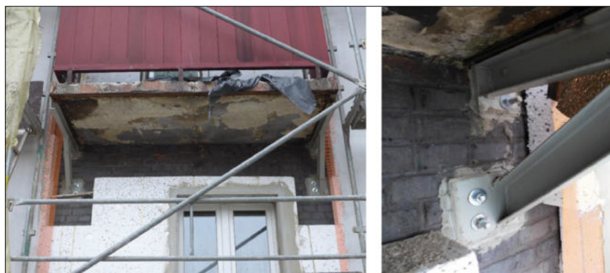
Fot. 15. Podparcie wspornikowej belki balkonu dodatkową belką i zastrzałem
