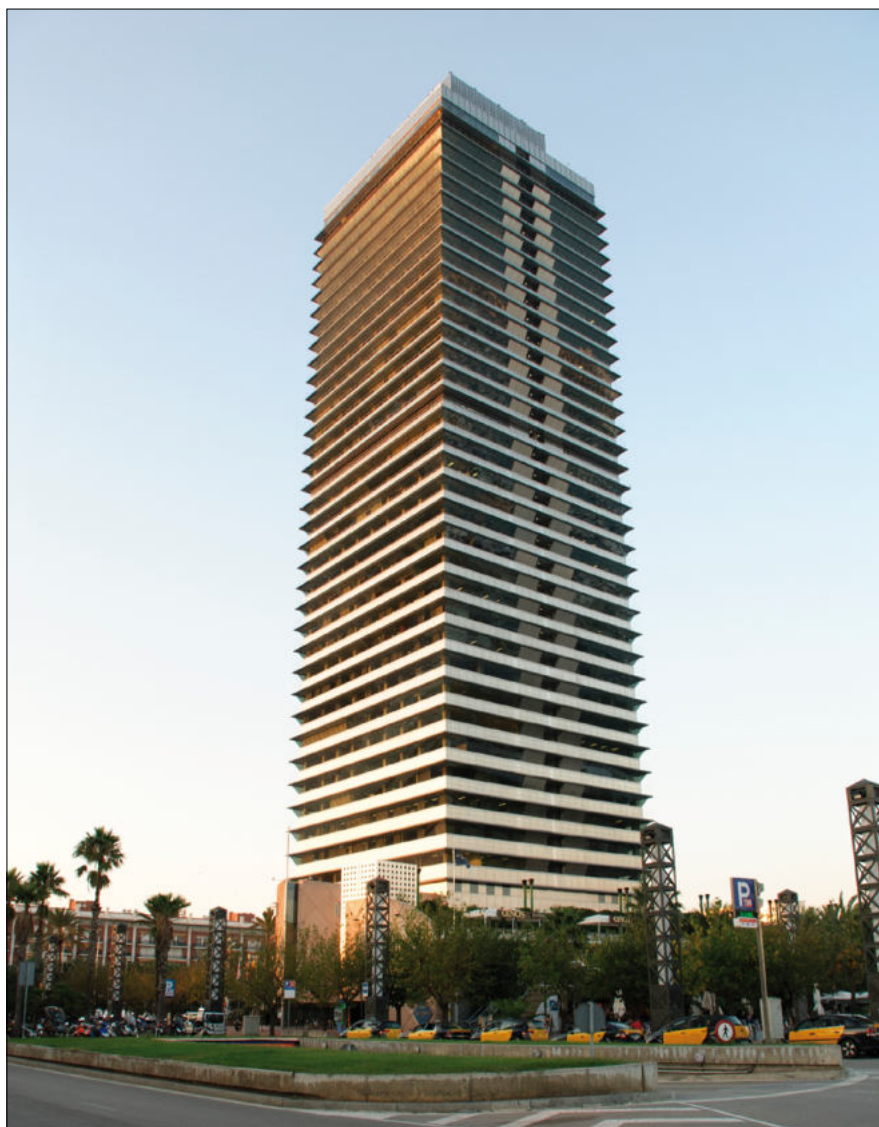
Fot. Przykład zastosowania SWW w budownictwie – Mapfre Tower, Barcelona (Wikipedia)
