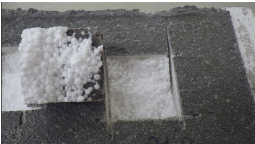
Fot. 3. Przyczepność kleju cementowego do styropianu
