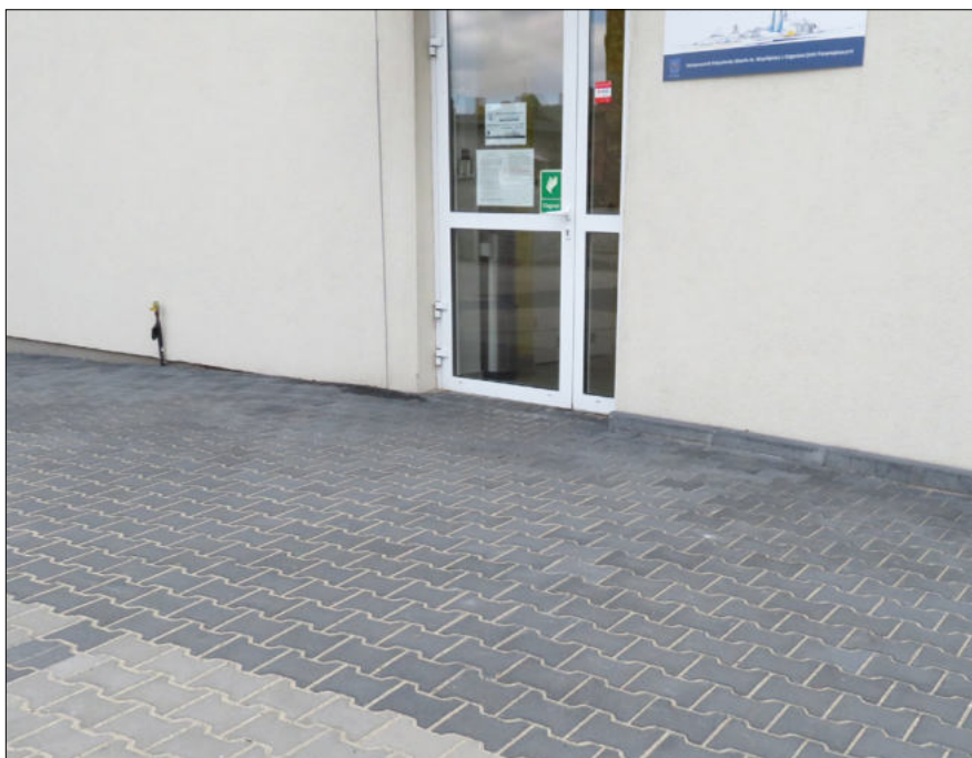
Wejście do budynku bez barier architektonicznych
