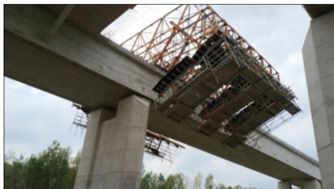
Fot. 10. Wózek przejeźdnego (deskowanie wspornika – faza otwarcia)
