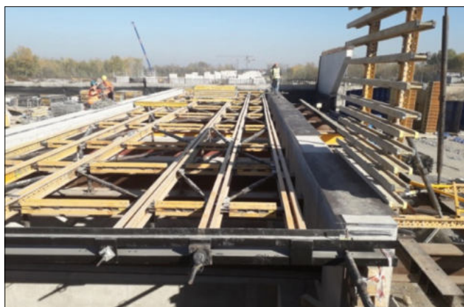
Fot. 5. Deskowanie etap I (plyta dolna)
