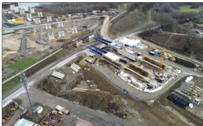
Fot. 4. Stanowisko nasuwania podłużnego
