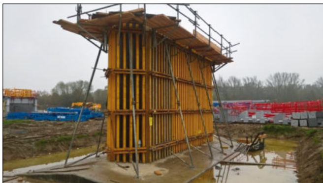
Fot. 1. Deskowanie filarów
