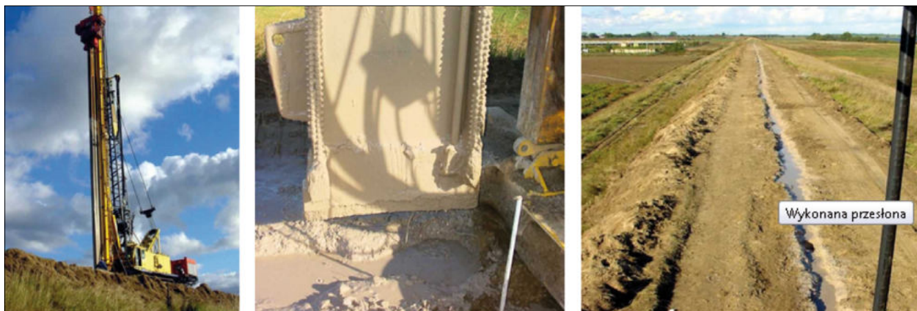
Fot. 1. Technologia WIPS wykonywania przesłony ( https://www.keller.com.pl/ )
