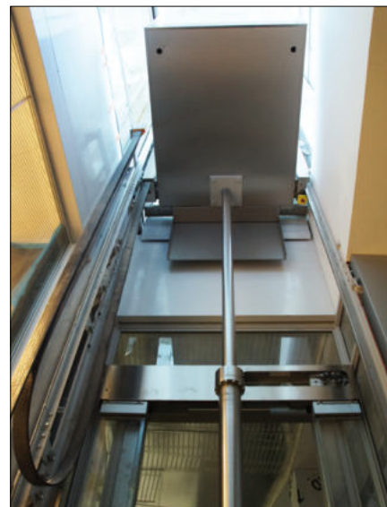
Fot. 5. Kabina dźwigu W1 od spodu, widoczny siłownik teleskopowy
