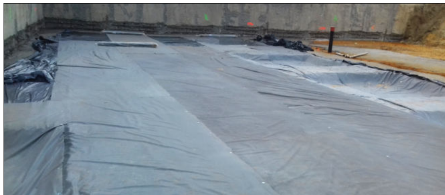
Hydroizolacja płyty dennej wykonywana z użyciem produktu Hydrostop-Mata Penetrująca
