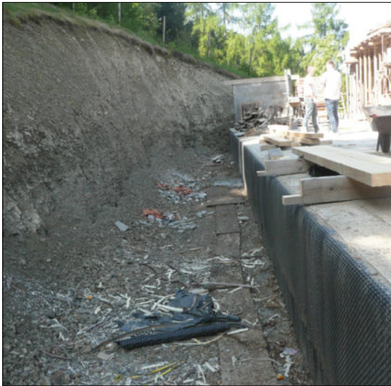
Fot. 1, 2. Szczególną uwagę trzeba zwrócić na sytuację, gdy od strony skarpy zlokalizowany jest taras nad częścią piwniczną (fot. autor)
