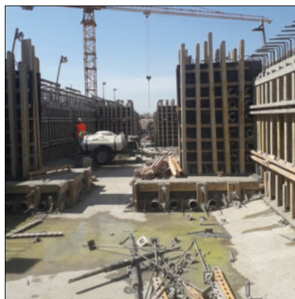
Fot. 7. Deskowanie etap I (środniki wewnętrzne)
