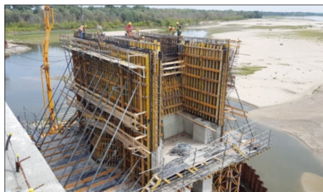
Fot. 2. Deskowanie segmentu startowego etap I (płyta dolna + środniki)
