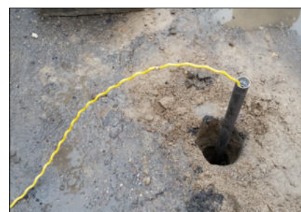
Fot. 4. Instalacja końcówki filtrującej BAT poniżej betonowej nawierzchni drogi usytuowanej na wale przeciwpowodziowym
