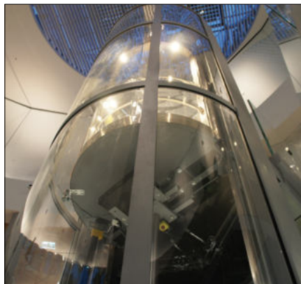
Fot. 7. Mechanizmy otwierania drzwi i napęd dźwigu okrągłego schowano pod kabiną
