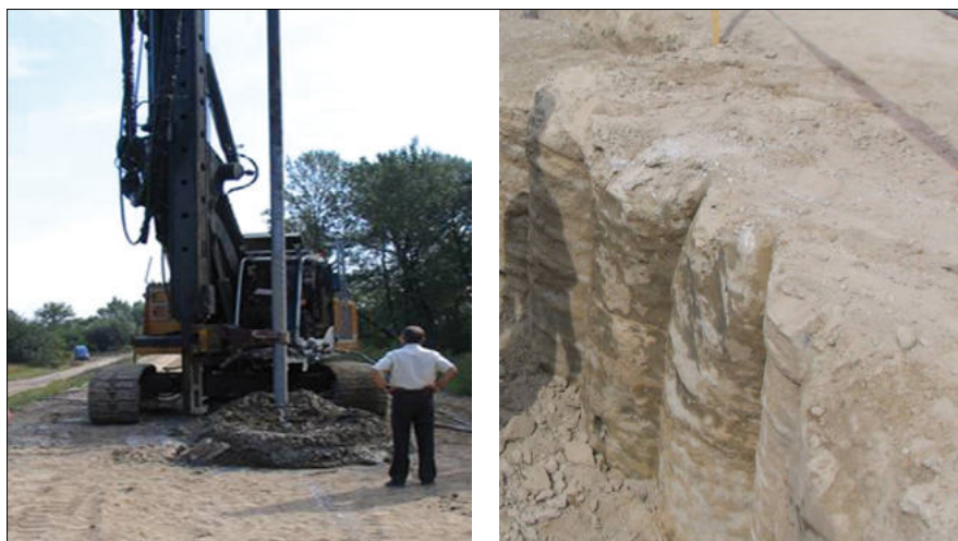
Fot. 2. Wykonywanie przesłony w technologii DSM oraz przesłona po odkopaniu
