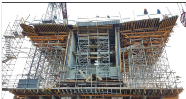
Fot. 3. Deskowanie segmentu startowego etap II (płyta górna)
