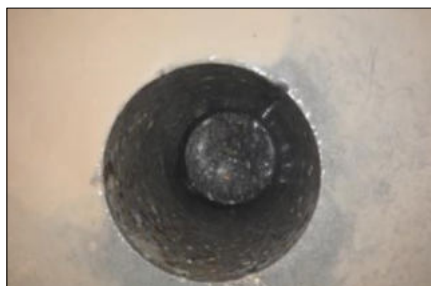
Fot. 4. Miejsce odwiertu
