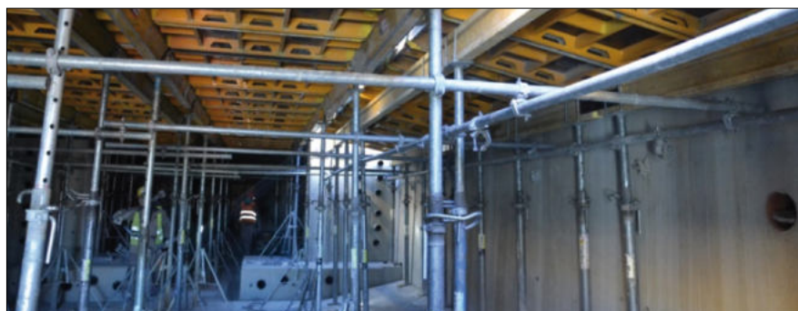
Fot. 8. Deskowanie etap II (płyta górna)
