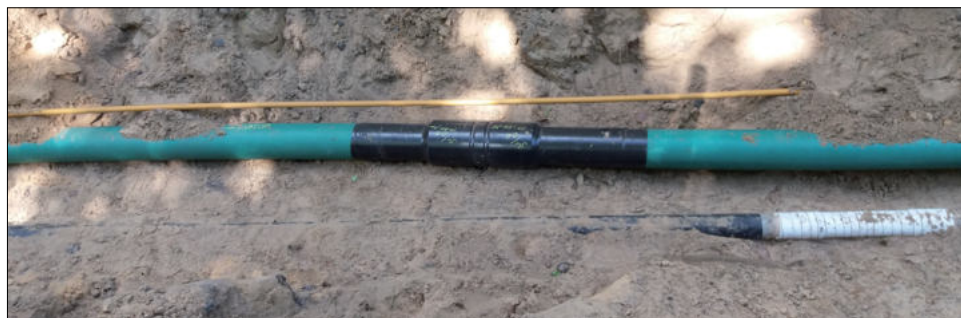
Fot. 5. Połączenie międzyrurowe po zaizolowaniu
