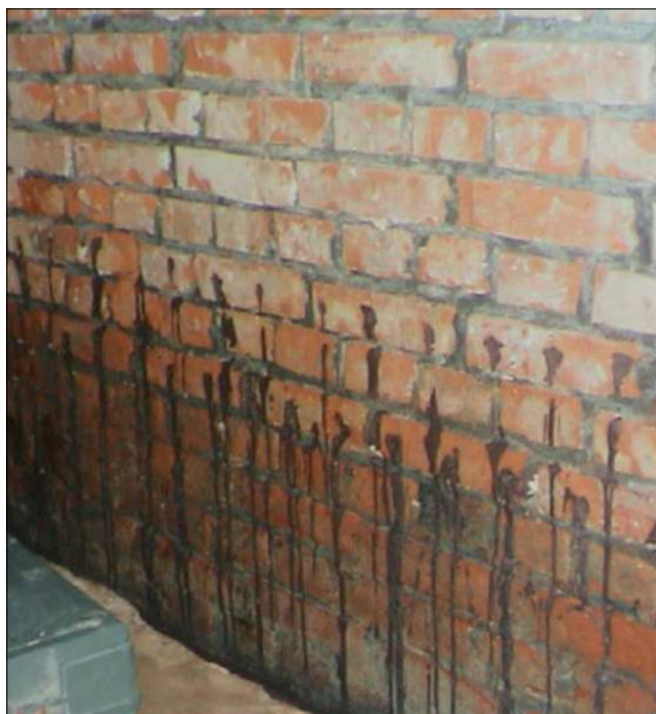
Fot. 6. Ściana murowana po zalaniu otworów iniekcyjnych materiałem krystalizującym
