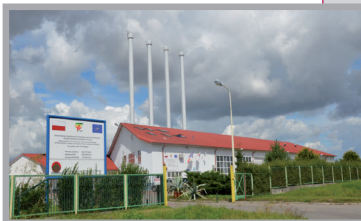
Ciepłownia geotermalna w Pyrzycach
