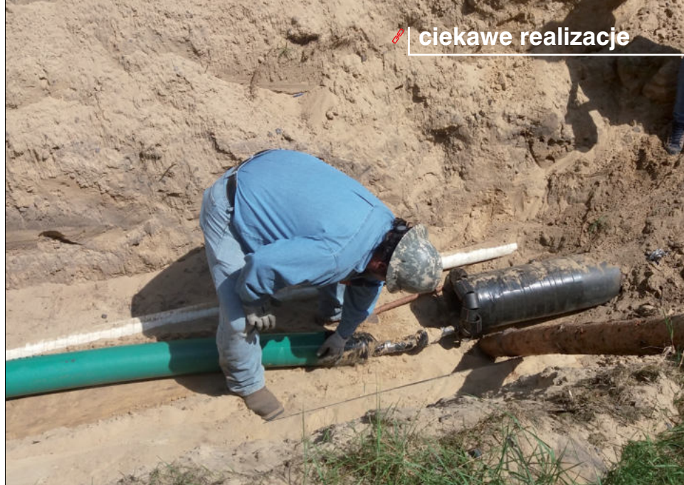
Fot. 3. Przygotowanie rury do przeciągnięcia
