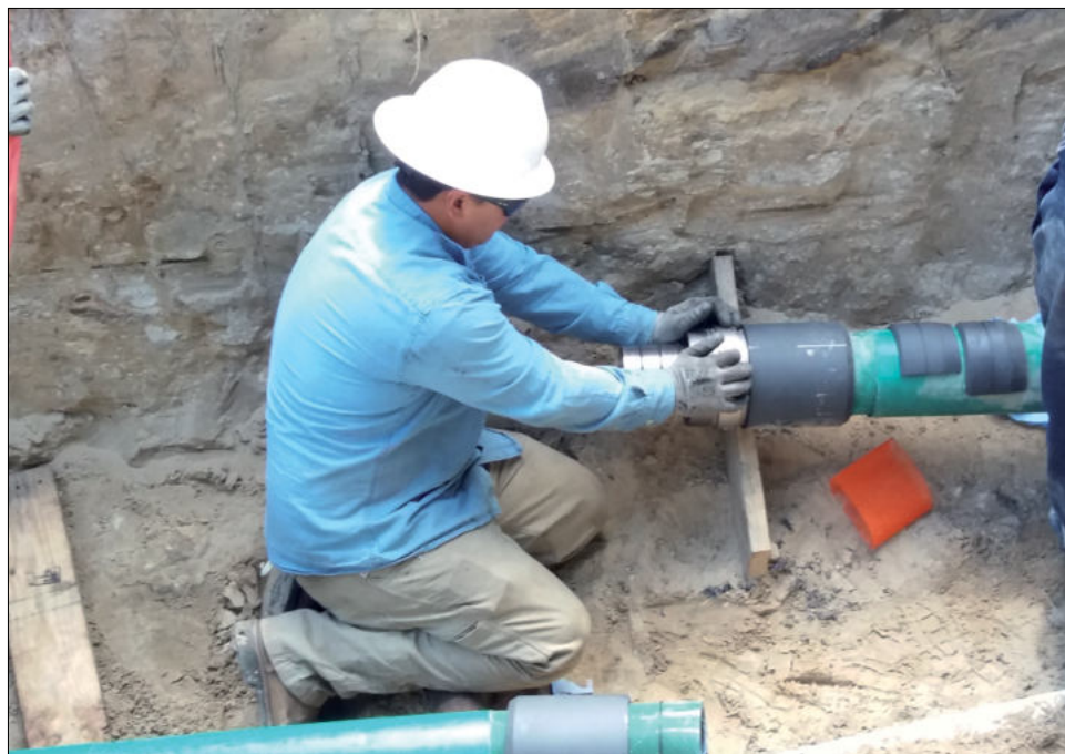
Fot. 4. Połączenie międzyrurowe – nałożenie złączy
