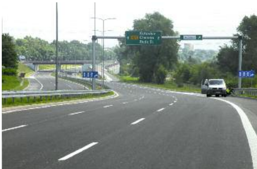
Zabrzańska DTŚ, w kierunku Katowic. Zjazd na Zaborze.
