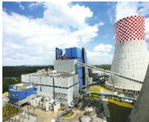
Rozbudowa Elektrowni Łagisza w Będzinie
