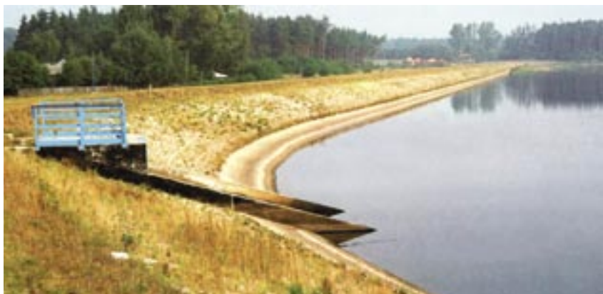
Rys. 4. Zapora boczna Brudnów
