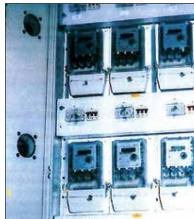
Fot. 2 | Przedział licznikowy rozdzielniczy wg normy
