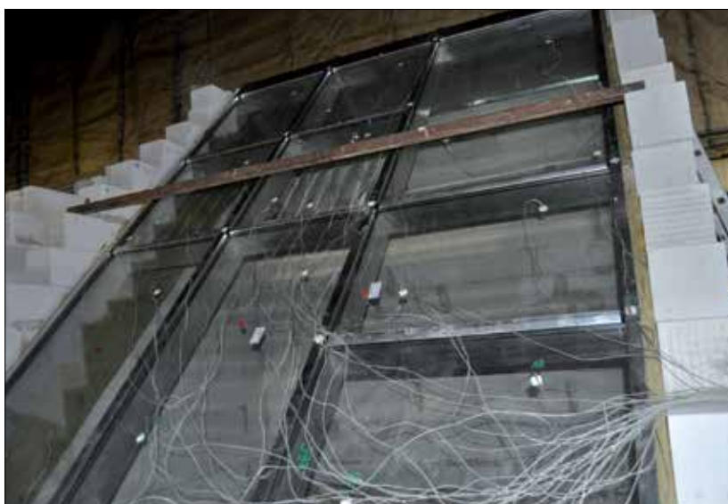
Fot. 1 | Dach z przeszkleniem przed badaniem (archiwum ITB)
