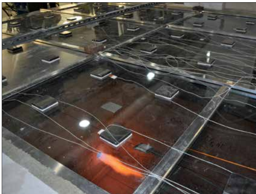
Fot. 3 | Dach z przeszkleniem podczas badania odporności ogniowej – początek badania (archiwum ITB)
