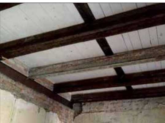
Fot. 2 | Przykłady powtórnego wykorzystania elementów drewnianych w trakcie remontu zespołu pałacowego w Gorzanowie [9]
