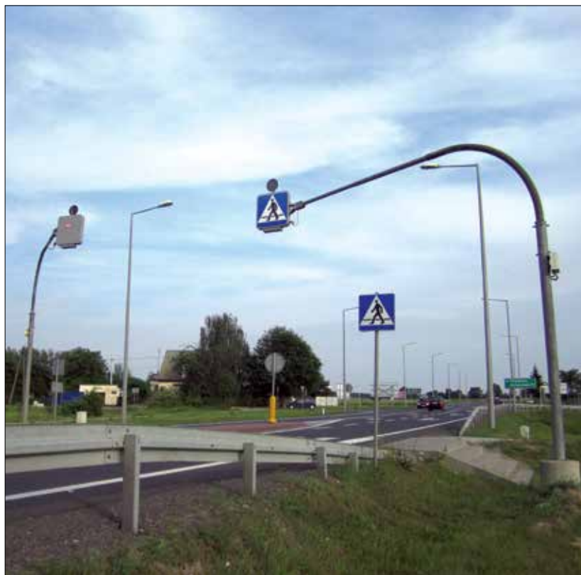
Fot. 3 | Oznakowanie, oświetlenie i sygnalizacja na przejściu dla pieszych
