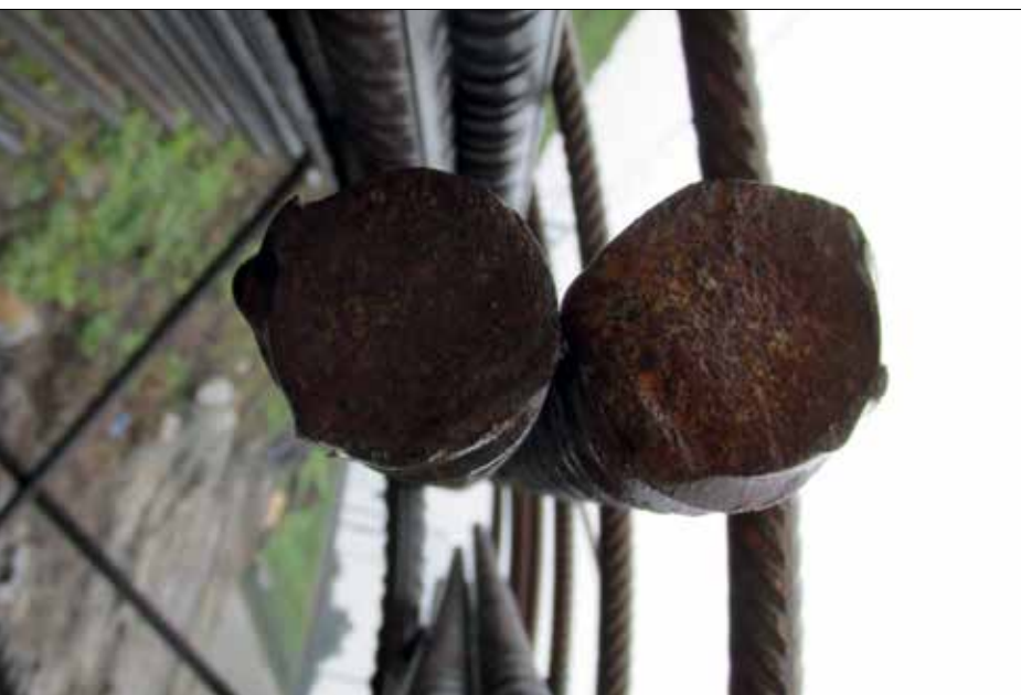
Fot. 3 | Pręty podwójne w koszu zbrojeniowym
