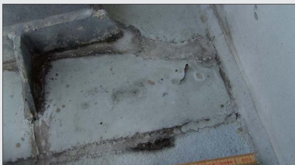
Fot. 6 | Doszczelnienie stopy słupa przebijającego warstwy izolacji przeciwwodnej
