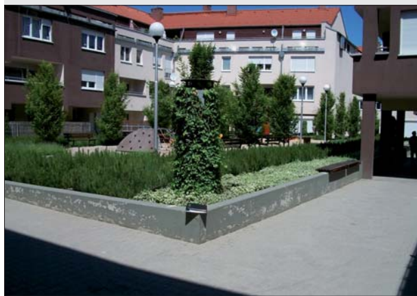
Fot. 4 | Zabudowa terenu nad izolacjami stropu garażu podziemnego
