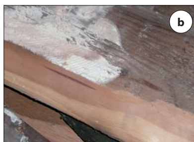
Fot. 1a, b | Grzybnia grzyba domowego właściwego ( Serpula lacrymans )
