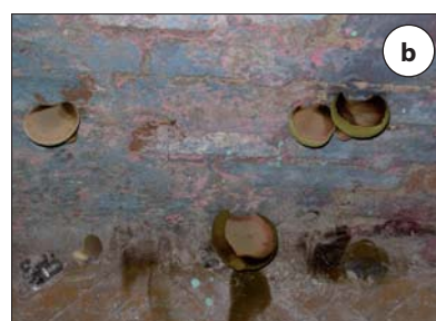
Fot. 2b Owocniki wyrastające z murowanej ściany
