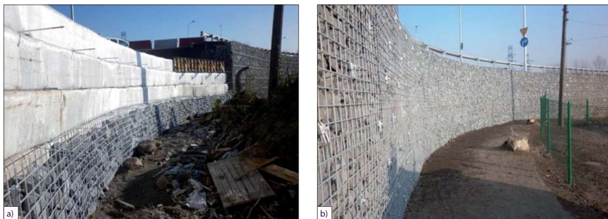
Fot. 5 | Ściana oporowa z pasywnym oblicowaniem kamiennym: a) wznoszenie lica kamiennego, b) ściana po oblicowaniu (fot. Inora)
