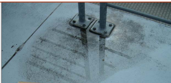
Fot. 5 | Mocowanie barierki z przebiciem warstw izolacji przeciwwodnej
