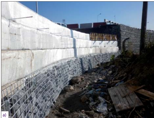
Fot. 6 | Ściana oporowa z semipasywnym licem z blozków betonowych, S7 obwodnica Kielc, 2012 (fot. Inora)
