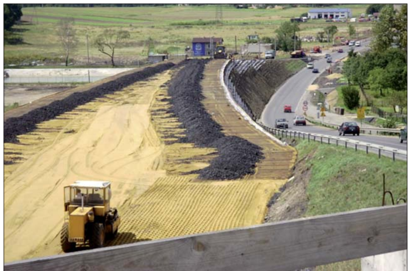
Fot. 4 | DW 933 Jastrzębie-Zdrój – budowa nasypu z gruntu zbrojonego na terenie aktywnych szkód górniczych (fot. Inora)
