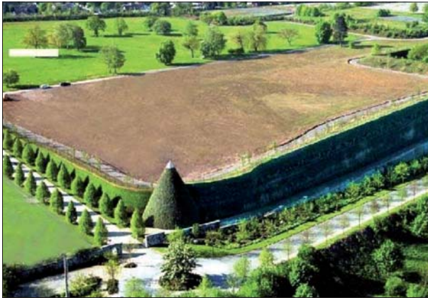
Fot. 2 | Ściany oporowe z gruntu zbrojonego geosyntetykami, Niemcy, 2001 (fot. Huesker)
