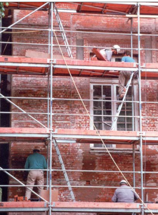
Fot. 2 Środki ochrony zbiorowej na rusztowaniu roboczym
