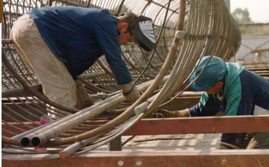
Fot. Prace przy budowie mostu na Martwej Wisle w Gdańsku; fot. L. Głowala/ KFP
