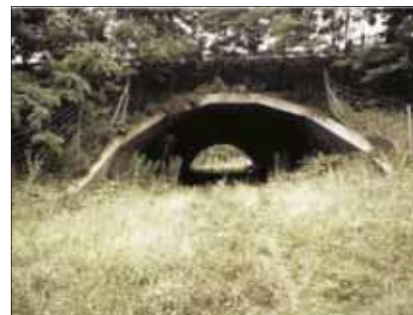
Fot. 4. Przejście podziemne betonowe: 9 m szerokości i 4 m wysokości (Francja). Widać poprawnie umocowane ogrodzenie, które nachodzi wysoko na konstrukcję [7]
