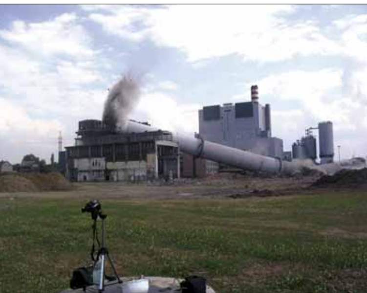
Fot.: Wyburzenie komina żelbetowego w Chorzowie (2007 r.), o pierwotnej wysokości 170 m, skróconego mechanicznie do około 128 m. Zastosowano wzmocnienie płaszczą w rejonie stopy oporowej oraz linę naciągową z podwieszonym obciążnikiem (archiwum autora)
