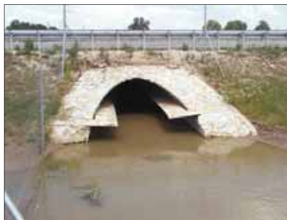
Fot. 3. Przejście dla płazów oraz małych ssaków pod autostradą A2 [6]
