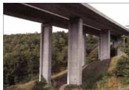
Fot. 6. Wiadukt w Słowenii [9]
