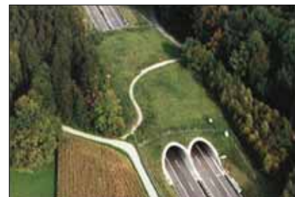
Fot. 13. Przejście górne zespolone (widać drogę gruntową) na autostradzie A7 koło miejscowości Wigoltingen w Szwajcarii, 140 m szerokości [11]
