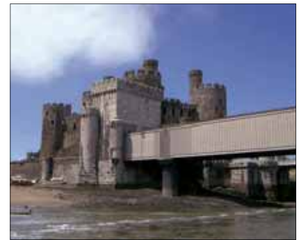
Fot. 3. Rurowy (tubularny) most przez rzekę Conwy w Walii, zaprojektowany przez Roberta Stephensona, długość przeszła 125 m, 1849 r.
