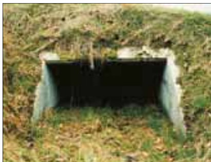
Fot. 2. Przejście dla małych zwierząt pod drogą gminną w południowych Niemczech [5]
