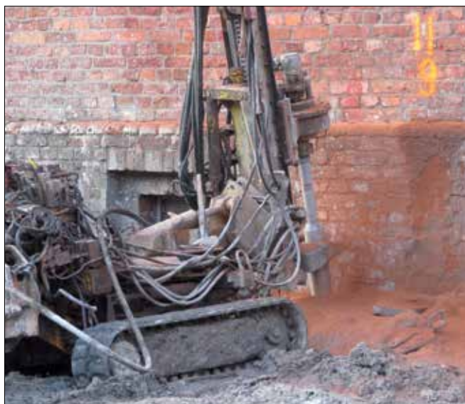
Fot. 2. Maszyna do wykonywania kolumn wzmacniających fundamenty istniejącego budynku
