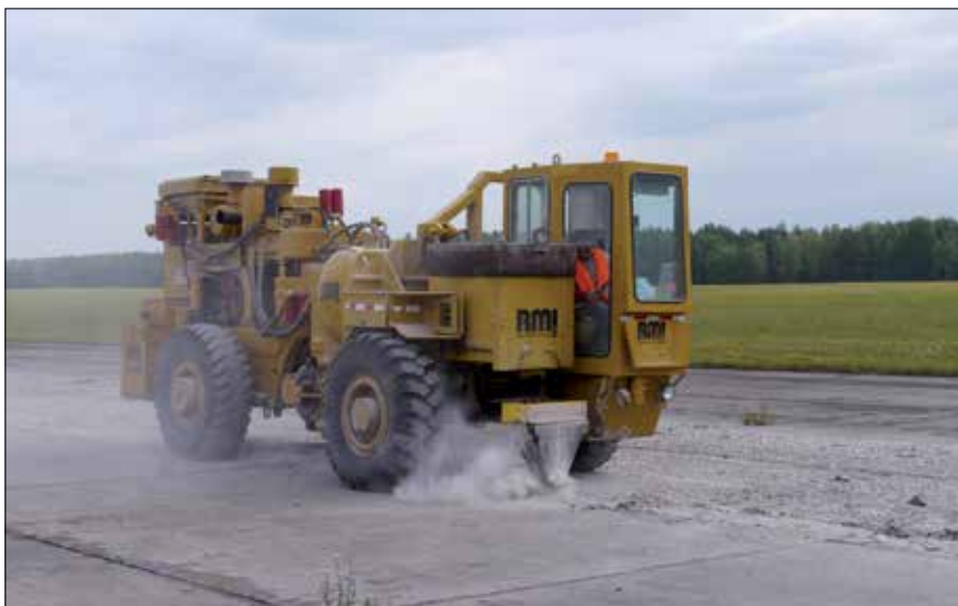
Fot. 4. Kruszenie nawierzchni drogi startowej lotniska w Szymanach metodą RMI (fot. archiwum firmy Rekma)
