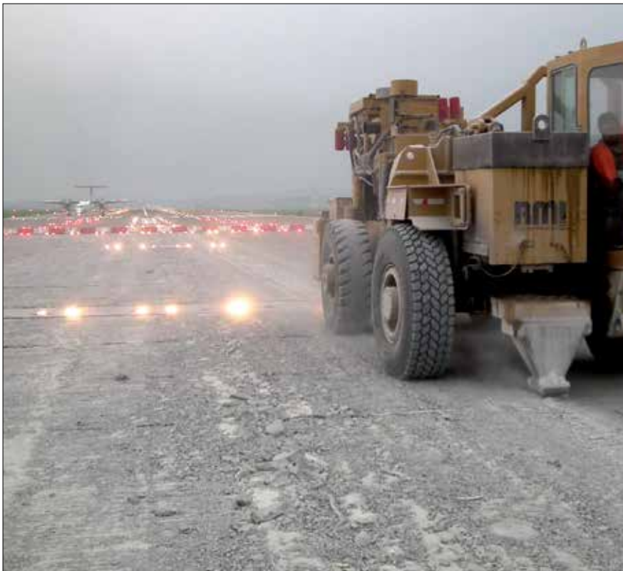
Fot. 2. Kruszenie nawierzchni drogi startowej lotniska w Balicach metodą RMI, 2014 r. (fot. archiwum firmy Rekma)
