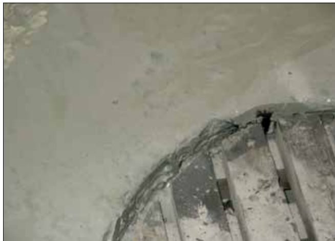
Fot. 2. Wyjątkowo niemądry sposób wykonania wpustu
