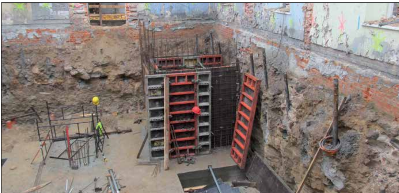
Fot. 4. Wykonanie kondygnacji podziemnej w istniejącym budynku możliwe dzięki zastosowaniu kolumn jet grouting
