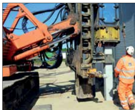
Rys. 1. Pograżanie pali prowadzone w pobliżu istniejącego obiektu
