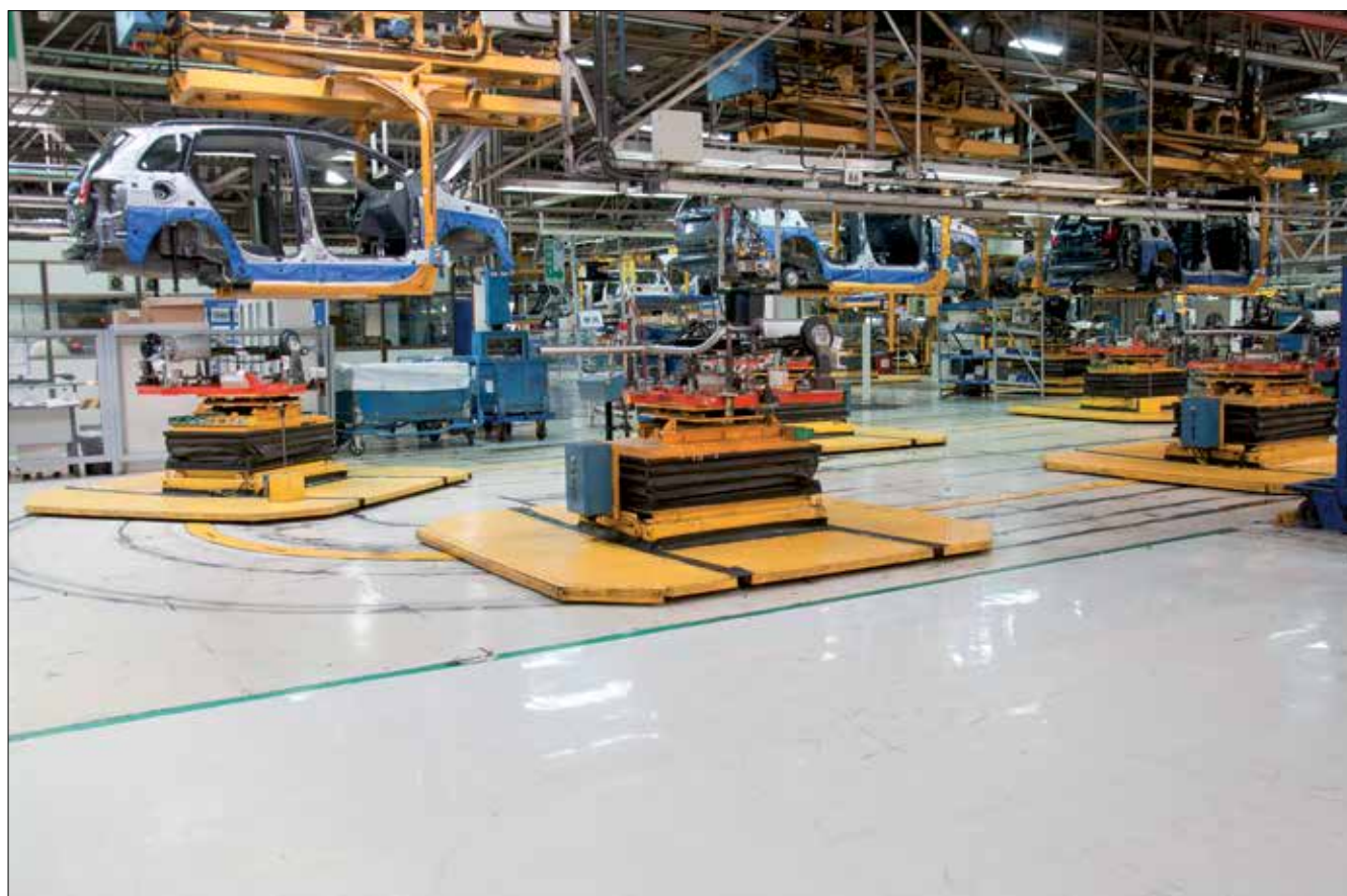
Fot. Przykład posadzki żywicznej wykonanej w montowni samochodów osobowych [12]
