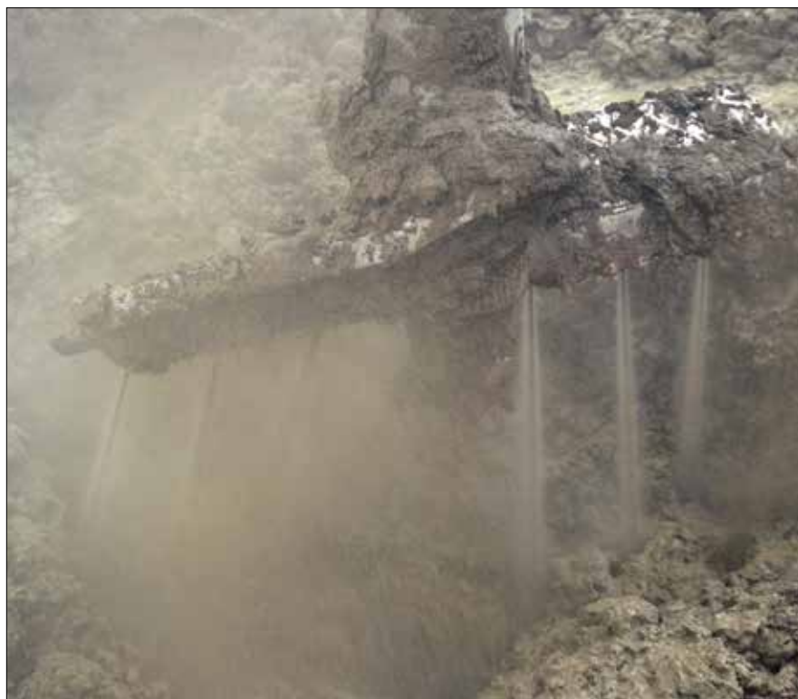
Fot. 5. Dolna część mieszadła kolumn DSM wyposażona w dysze do tłoczenia zaczynu pod dużym ciśnieniem
