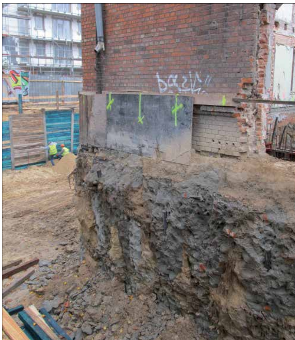
Fot. 3. Konstrukcja budynku wraz z fundamentami oparta w czasie przebudowy na kolumnach iniekcyjnych
