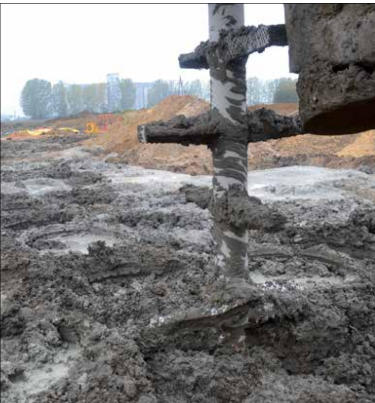
Fot. 6. Mieszadło oraz platforma z wykonanymi kolumnami
