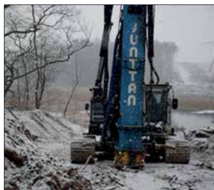
Rys. 3. Pograżanie pali w temperaturach ujemnych
