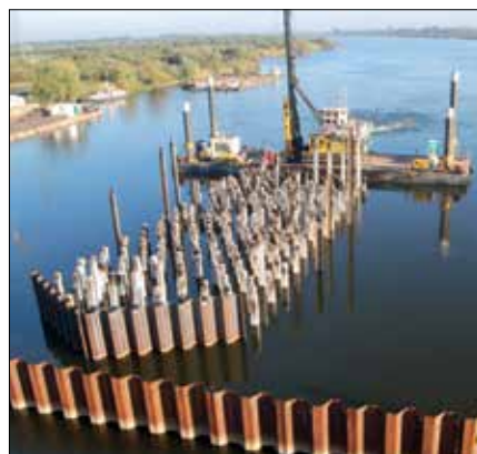
Rys. 2. Pograżanie pali z jednostek pływających
