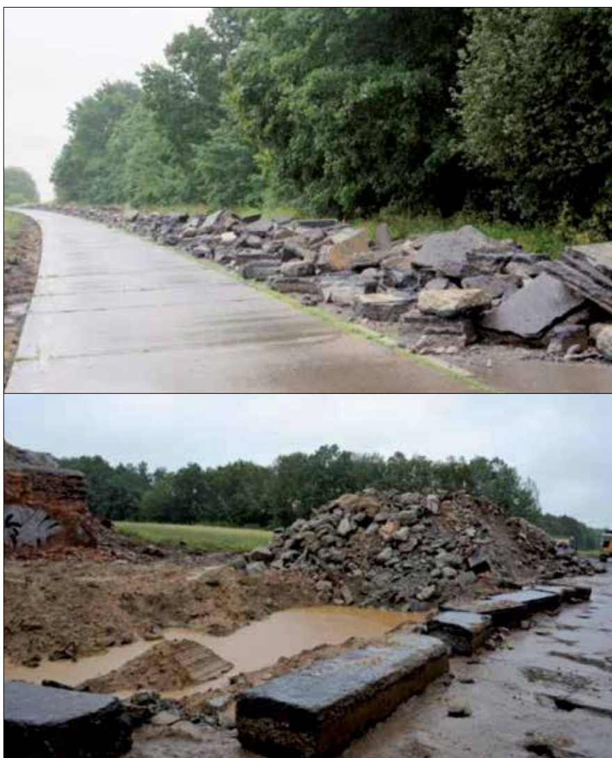
Fot. 1. Kruszenie betonowych płyt metodą rubblizingu na drodze wojewódzkiej nr 142 w ramach prac realizowanych przez Budimex w 2017 r. (fot. Zachodniopomorski Zarząd Dróg Wojewódzkich)
