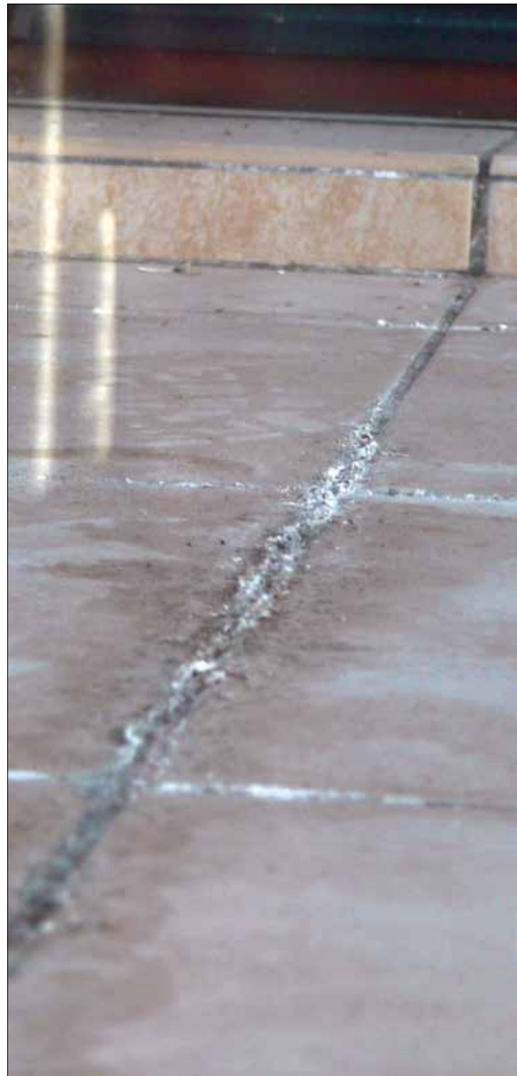
Fot. 1 Widoczne objawy mogą mieć kilka przyczyn, jedną z nich może być kondensacja międzywarstwowa w jastrychu dociskowym (fot. autora)
