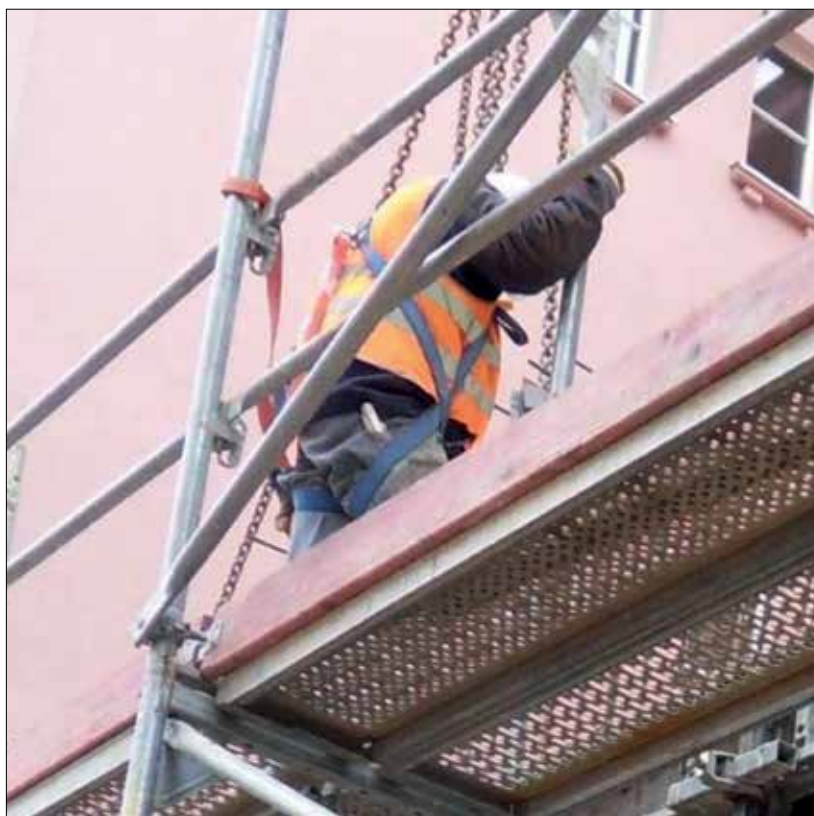
Fot. 1 | Wykorzystanie środków ochrony indywidualnej na rusztowaniu (fot. archiwum firmy Warbud SA)
