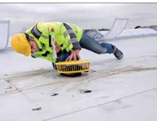
Montaż elementu SitaMore do odwodnienia awaryjnego
