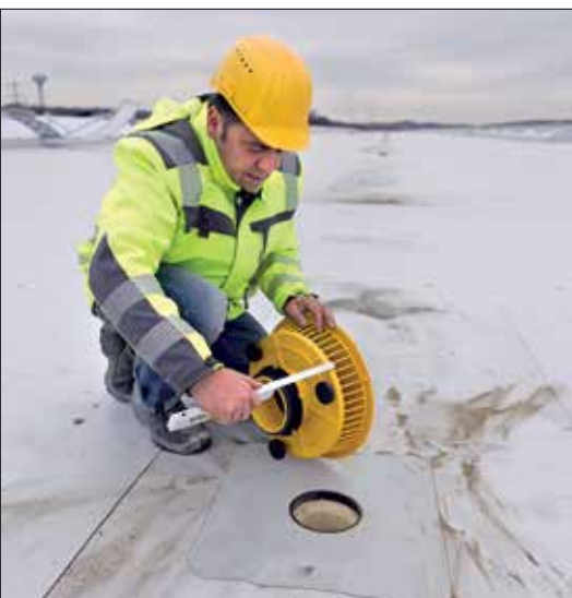
Montaż elementu spiętrzającego SitaMore do wpustu dachowego
