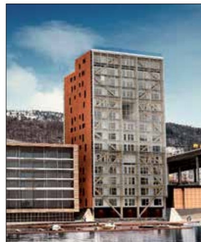
Fot. 1 | 14-piętrowy apartamentowiec Treet w Bergen ukończony w 2015 r.
