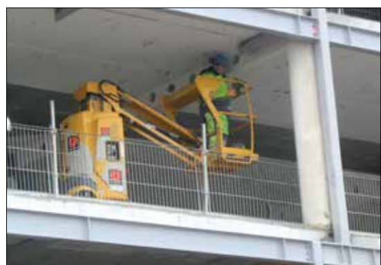
Fot. 7 | Minipodnośnik koszowy – budowa budynku mieszkalnego w Oslo
