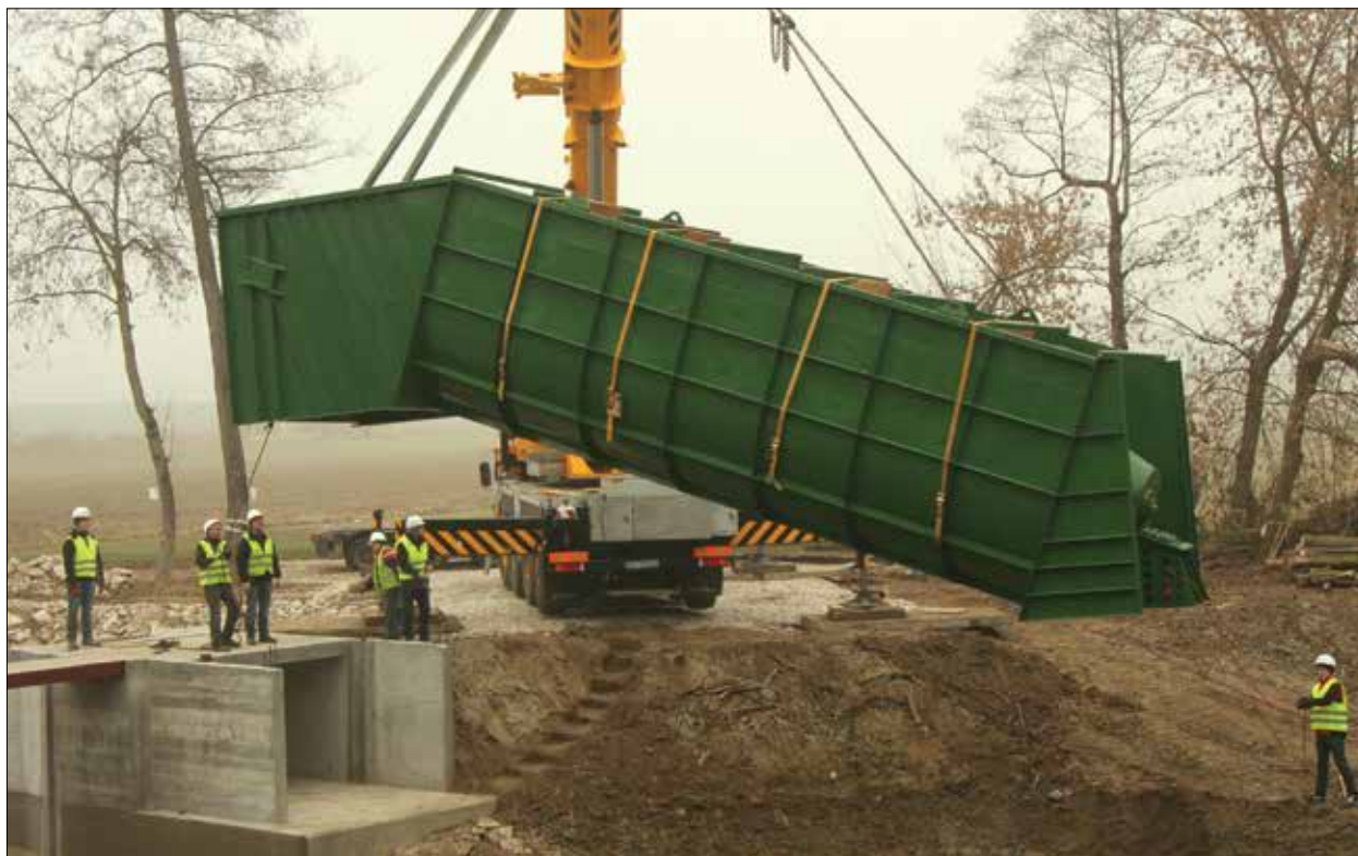
Fot. 2 | Montaż śruby Archimedes w MEW Bronocice
