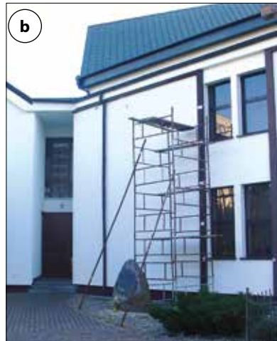
Fot. 4 | Rusztowanie przejazdne typu „Warszawa”: a) prawidłowe zastosowanie (fot. Rew -Ton), b) błędy rusztowania warszawskiego
