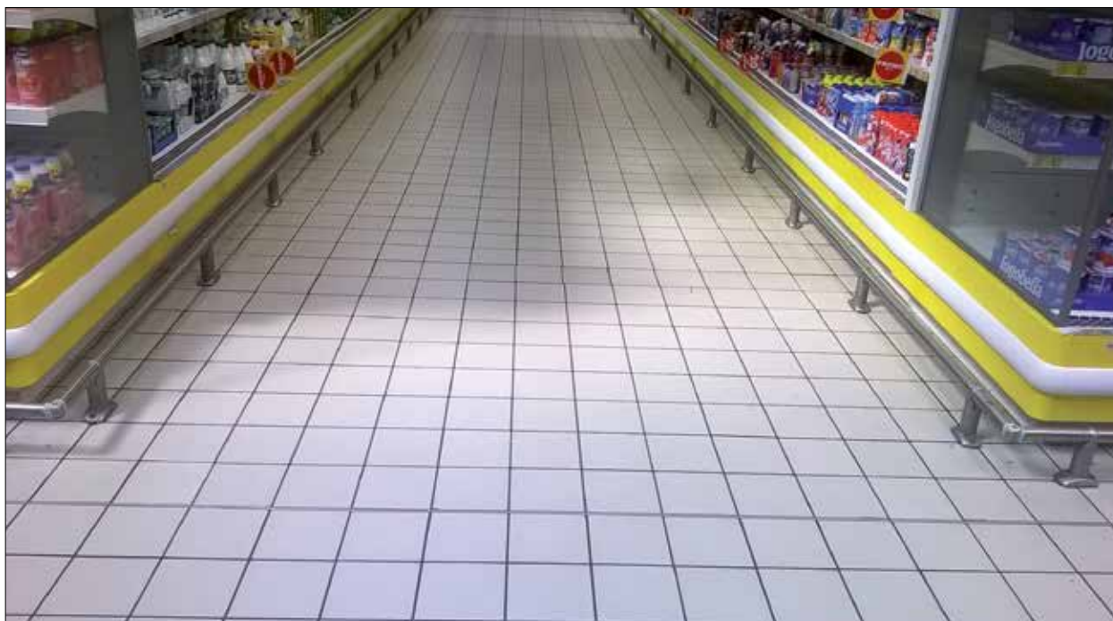
Fot. 2 | Przykład posadzki ceramicznej wykonanej w obiekcie handlowym (fot. autora)
