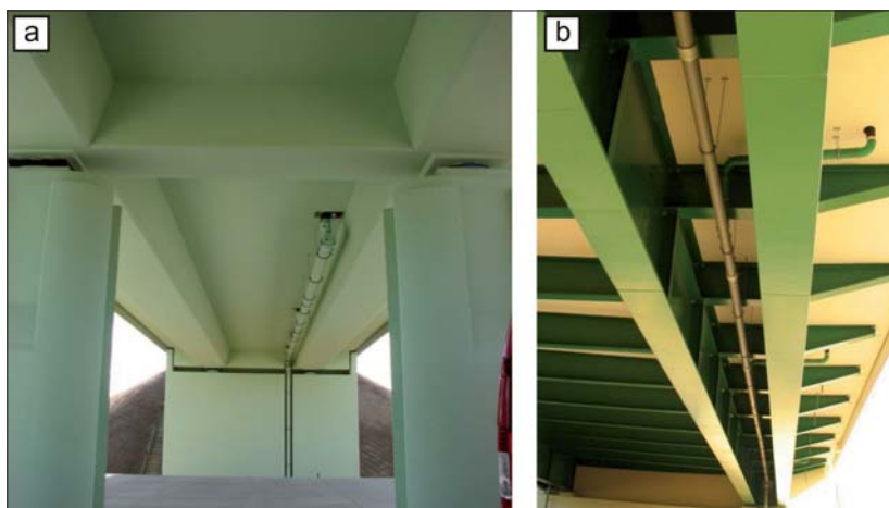
Fot. 7 | Przykłady prowadzenia rurociągów na konstrukcji obiektu mostowego: a) rura spustowa umieszczona we wnęce ściany przyczółka, b) kolektor odwodnienia usytuowany między dźwigarami konstrukcji pomostu
