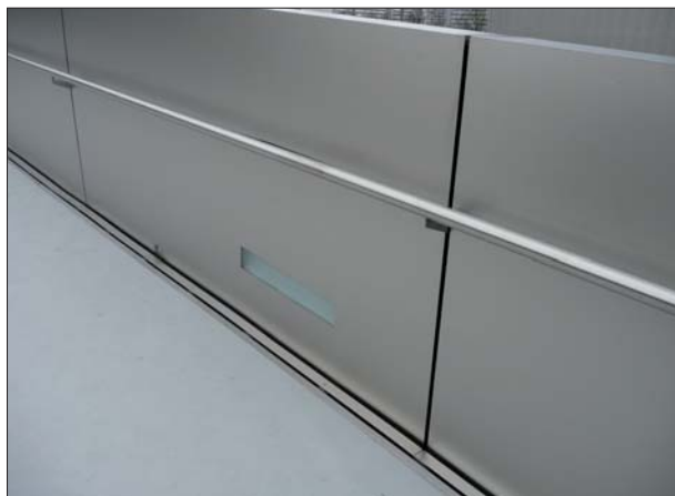
Fot. 6 Ściek szczelinowy wzdłuż balustrady na kładce dla pieszych w Niemczech
