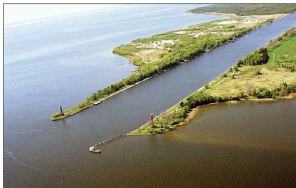
Fot. 4 | Stacja radarowa VTS na I Bramie Torowej (fot. UMS)
