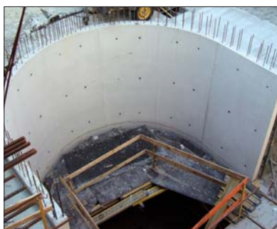
Fot. 3 | Radialna klatka schodowa z betonu licowego
