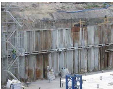
Fot. 2 | Północna krawędź wykopu
