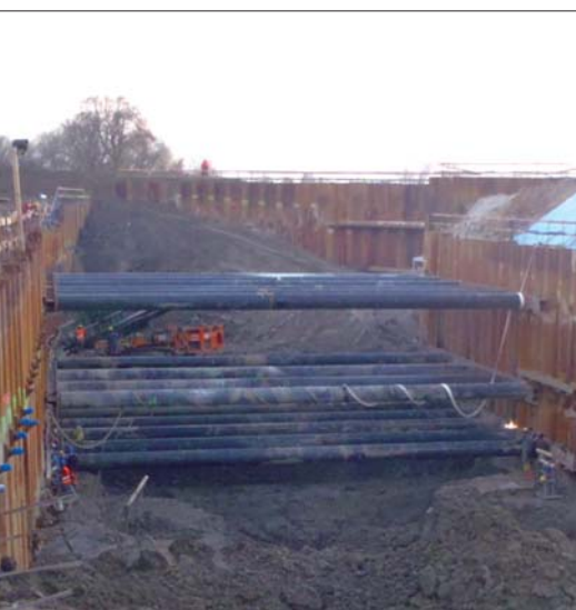
Fot. 7 | Wykop pod halę turbin trzykrotnie rozparty
