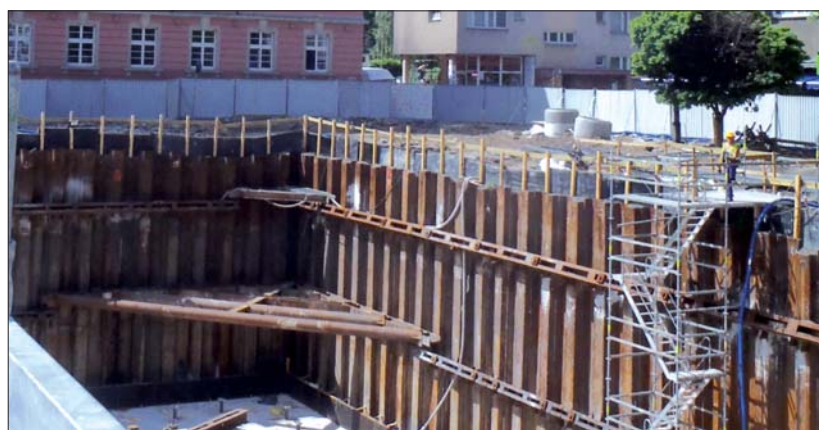
Fot. 3 | Rozparcia stosowane w narożach wykopu
