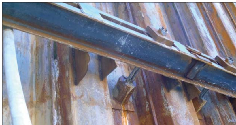
Fot. 5 | Widok głowicy wodoszczelnej kotwienia poniżej zwierciadła wody gruntowej
