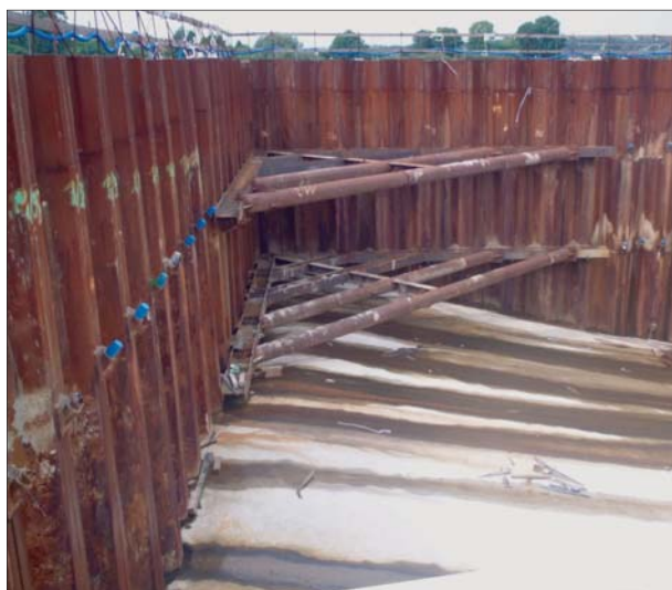
Fot. 10 | Narożnik obudowy wykopu w strefie wlotowej
