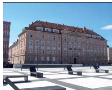
Fot. 1 | Plac Nowy Targ po zrealizowaniu parkingu podziemnego
