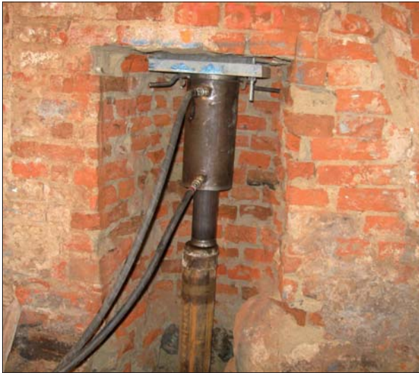
Fot. 2 | Wciskanie pala siłownikiem opartym na konstrukcji
