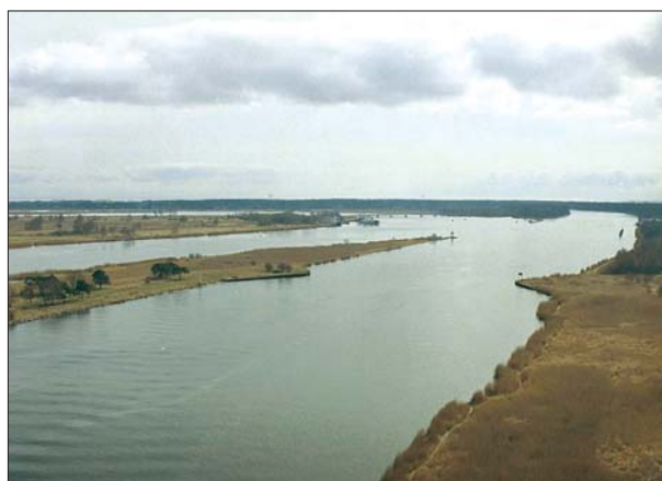
Fot. 6 | Falochrony I Bramy Torowej przed odbudową. Cypel przy nasadzie zniszczonego falochronu zachodniego obudowany ścianką szczelną (fot. UMS)
