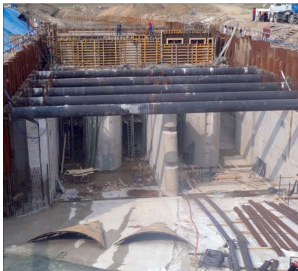
Fot. 9 | Hala turbin po zdemontowaniu dwóch dolnych rzędów rozparć
