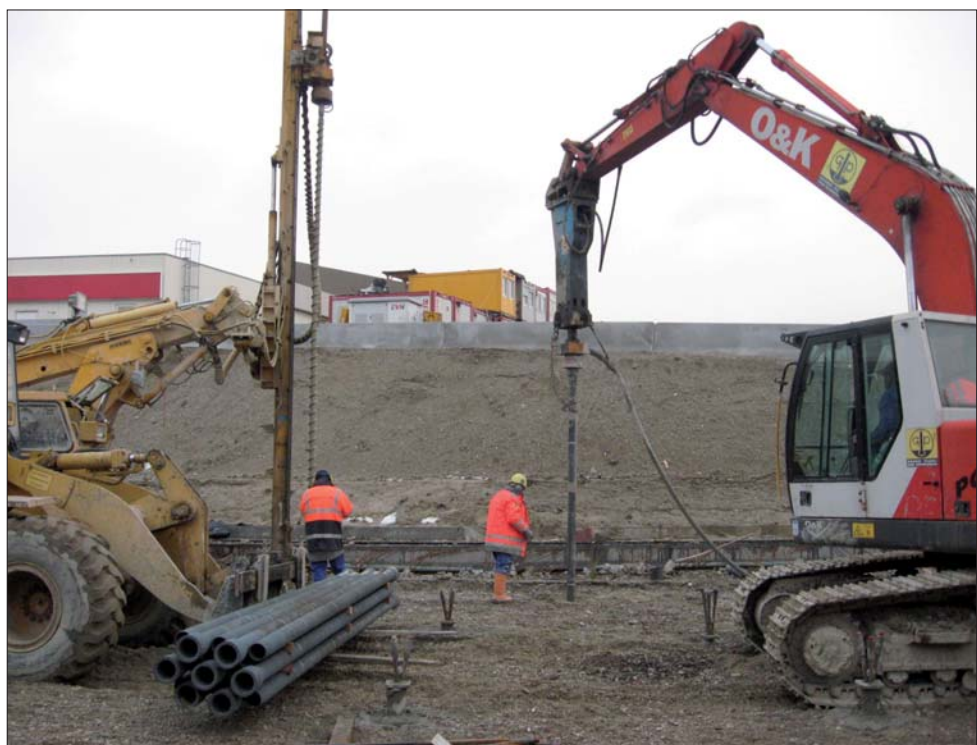
Fot. 1 | Wbijanie pali żeliwnych
