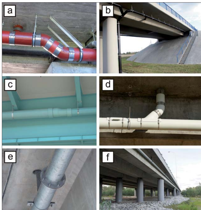
Fot. 2 Materiały stosowane w konstrukcjach kolektorów i rur spustowych: a) rury żeliwne nowej generacji, b) rury z tworzyw sztucznych, c) rury z kompozytów GRP, d) rury z kompozytów CC-GRP, e) i f) rury stalowe z połączeniami kolnierzowymi (przykład z Australii Zachodniej)
