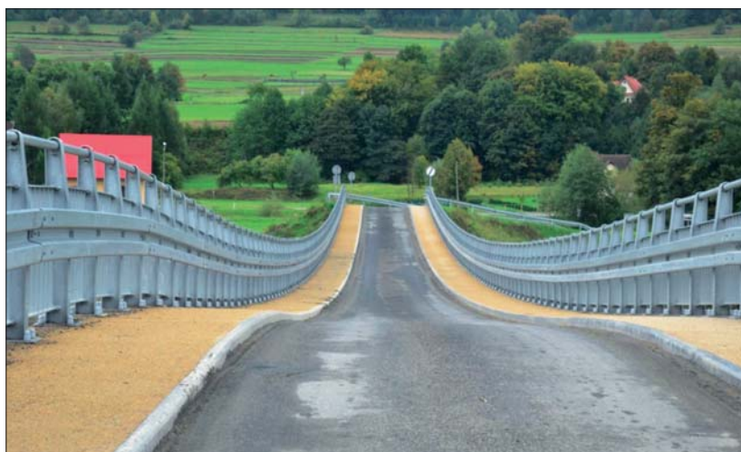
Fot. 1 | Wstępowa kładka pieszo-jezdna w Lubniu. Patrz także zdjęcie na okładce
