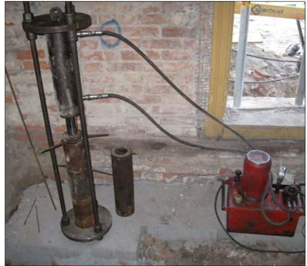
Fot. 3 | Pale wciskane zakotwione do fundamentu
