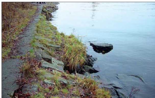
Fot. 3 | Modernizacja toru wodnego Świnoujście – Szczecin
