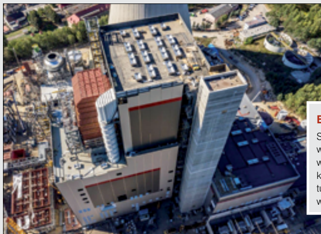
Kotłownia elektrowni (fot. Budimex SA)
