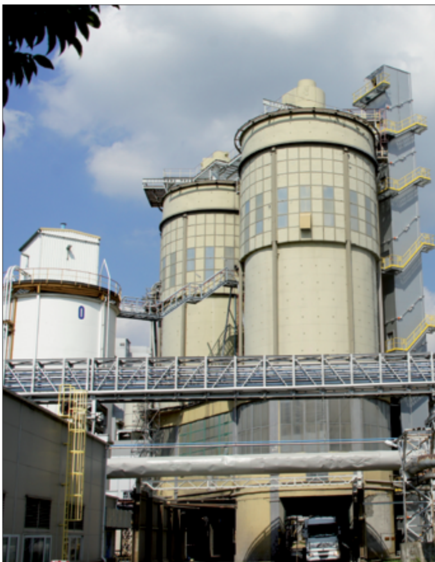
Fot. 1. Ładowanie popiołu ze zbiornika retencyjnego na samochód
