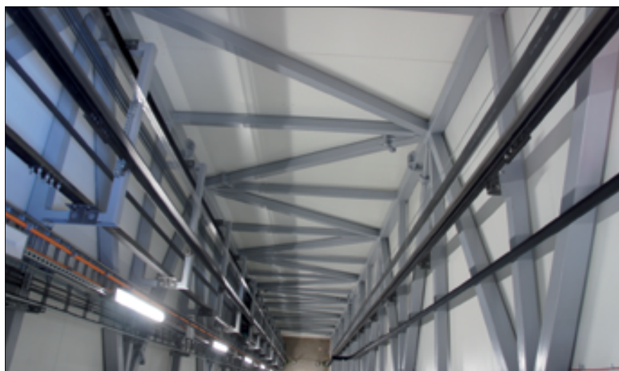
Fot. 3. Konstrukcja nowego szybu z zamontowanymi prowadnicami
