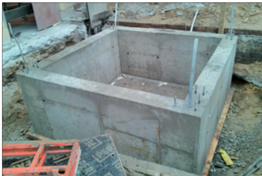
Fot. 4. Nowy fundament szybu
