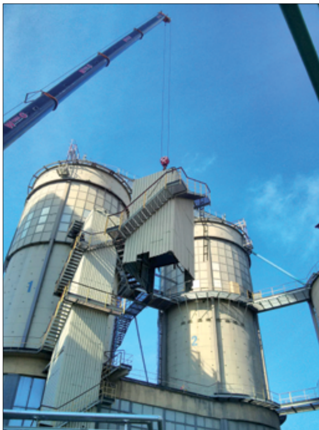
Fot. 6. Opuszczanie odciętego fragmentu szybu
