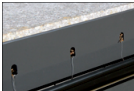
Fot. 12–14. Zanieczyszczenia mogą utrudnić usunięcie wody z połaci, dlatego profil okapowy powinien mieć „awaryjne odprowadzenie wody” (fot. Renoplast)
