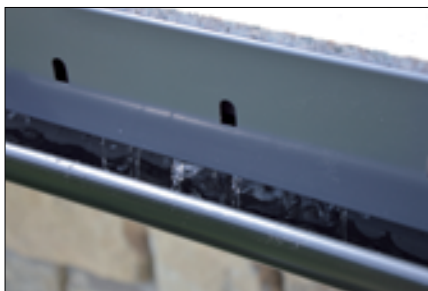
Fot. 12–14. Zanieczyszczenia mogą utrudnić usunięcie wody z połaci, dlatego profil okapowy powinien mieć „awaryjne odprowadzenie wody” (fot. Renoplast)
