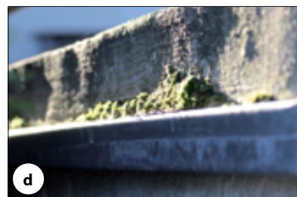
Fot. 6. Wyjątkowo niekorzystny sposób wykonania czoła połaci (fot. 6c – Renoplast)
