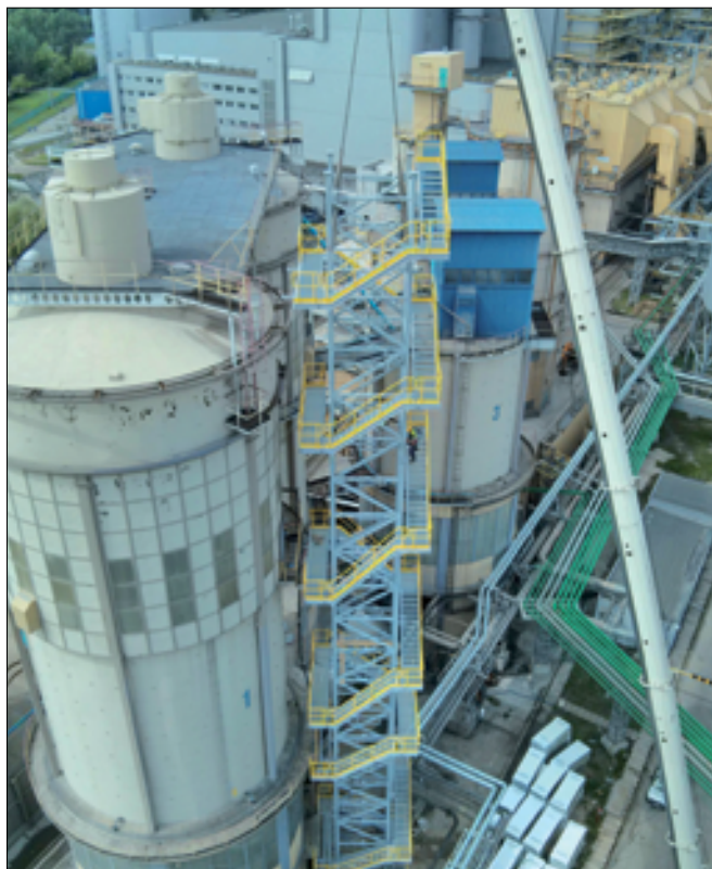
Fot. 8. Ustawianie najwyższego segmentu szybu
