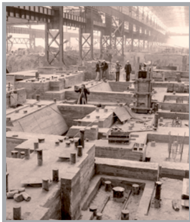
Budowa Huty Katowice
