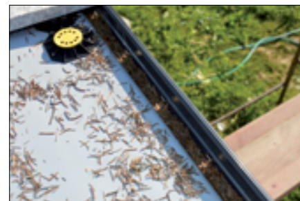
Fot. 12–14. Zanieczyszczenia mogą utrudnić usunięcie wody z połaci, dlatego profil okapowy powinien mieć „awaryjne odprowadzenie wody” (fot. Renoplast)
