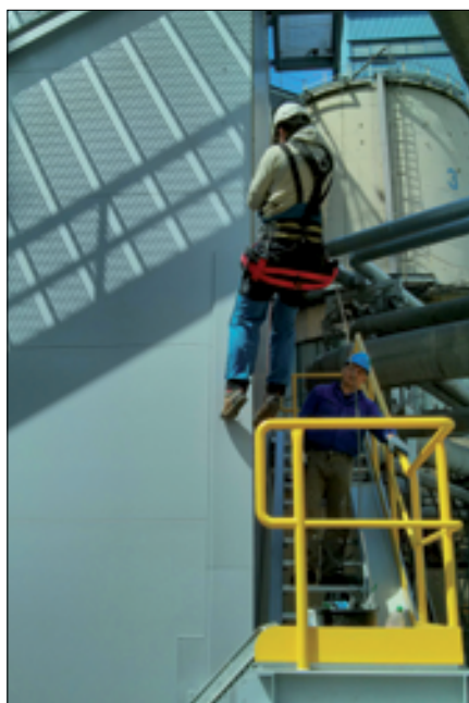
Fot. 9. Montaż poszycia
