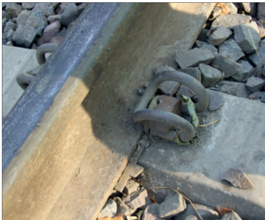
Fot. 1. Przykład systemu przytwierdzeń SB
