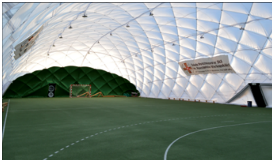
Fot. 2. Hala pneumatyczna, Szkoła Podstawowa 263, Warszawa
