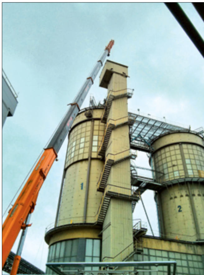
Fot. 5. Przygotowanie do rozbiórki szybu
