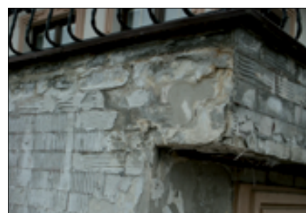
Fot. 10. Problemy ze szczelnością w strefie okapu mogą mieć znacznie dalej idące skutki
