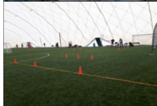
Fot. 4, 5. Hala pneumatyczna 48 x 99 m, ul. Kresowa, Sosnowiec
