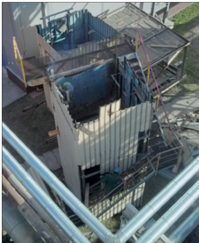
Fot. 7. Rozbierane fragmenty szybu na placu budowy
