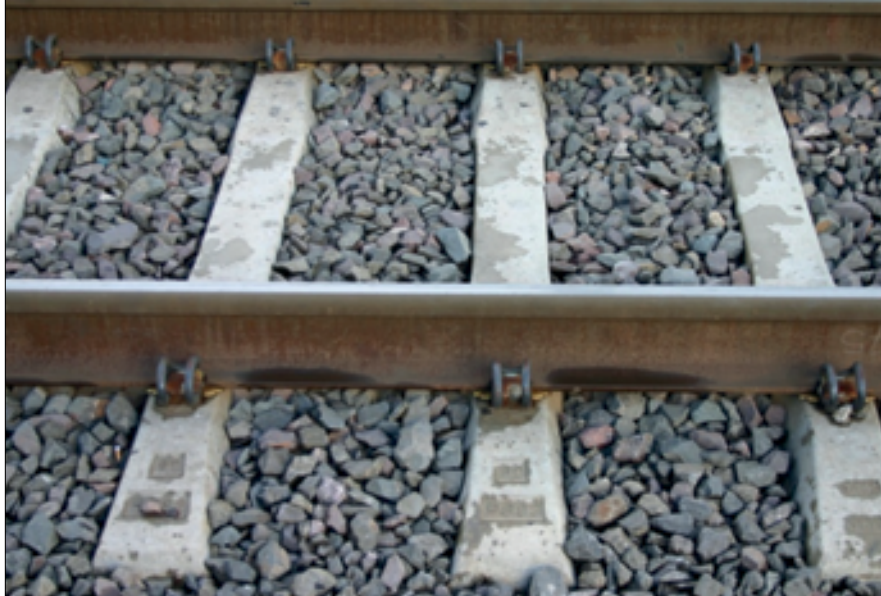
Fot. 2. Przykład toru o tradycyjnej konstrukcji
