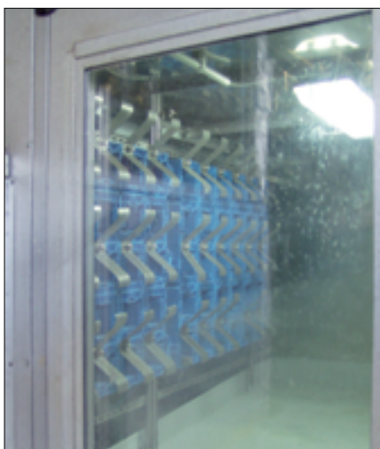
Fot. 2. Widok przez okienko inspekcyjne na zespół dysz nawilżacza wodnego
