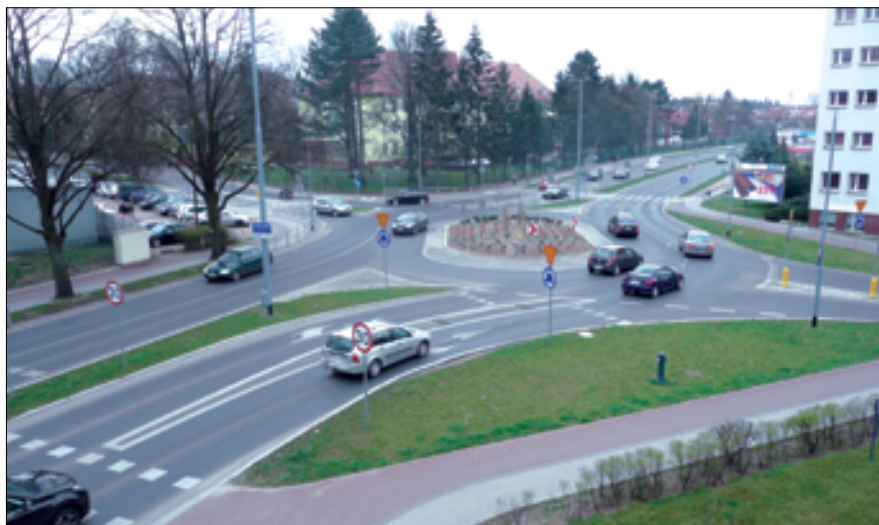
Fot. 2. Rondo w Koszalinie o średnicy zewn. 29,0 x 36,0 m. Geometria wymuszona brakiem możliwości zajęcia terenu (proj. J. Sontowski, 2012 r.)
