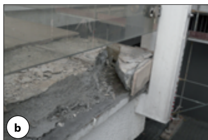
Fot. 6. Wyjątkowo niekorzystny sposób wykonania czoła połaci (fot. 6c – Renoplast)
