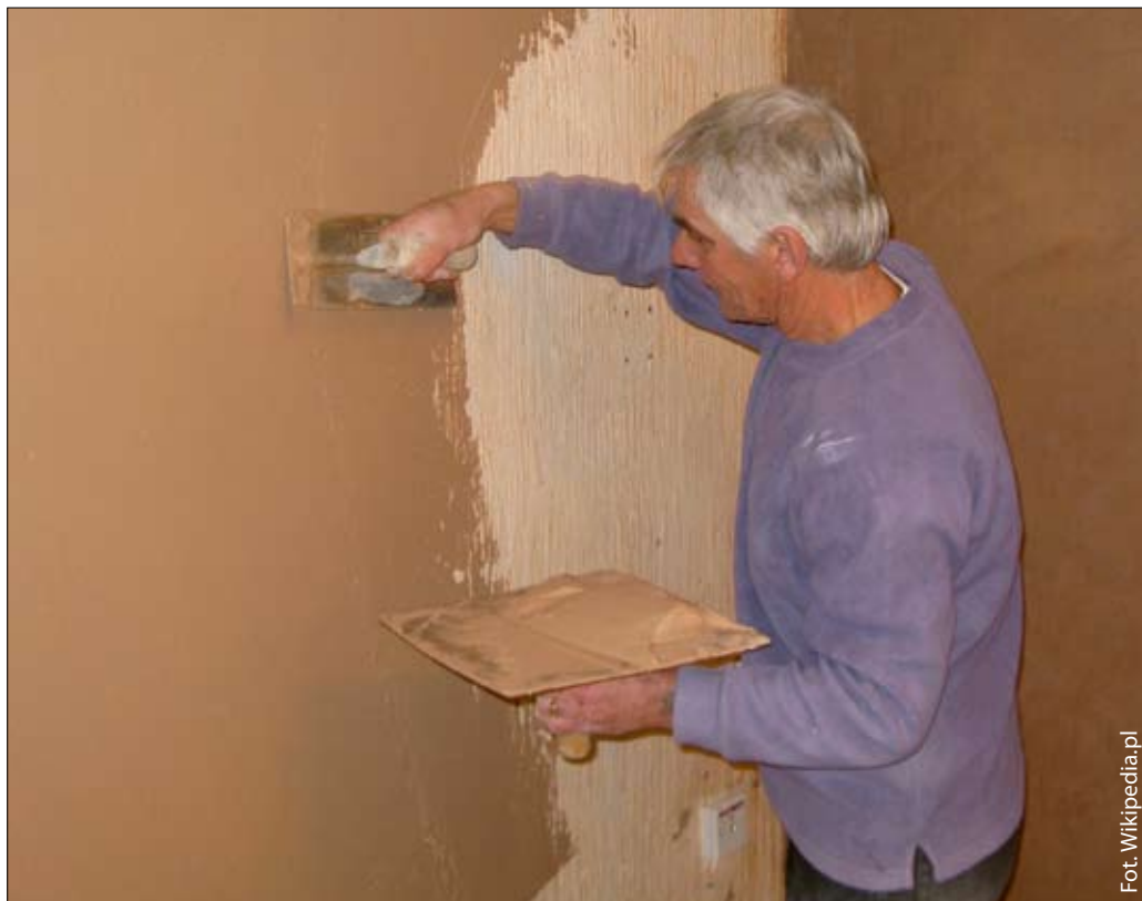
Wykonywanie dekoracyjnej gładzi tynku
