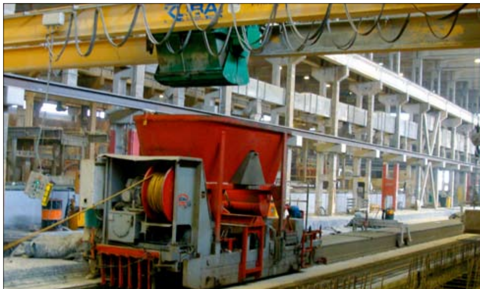
Fot. 3 | Produkcja sprężonych płyt kanałowych
