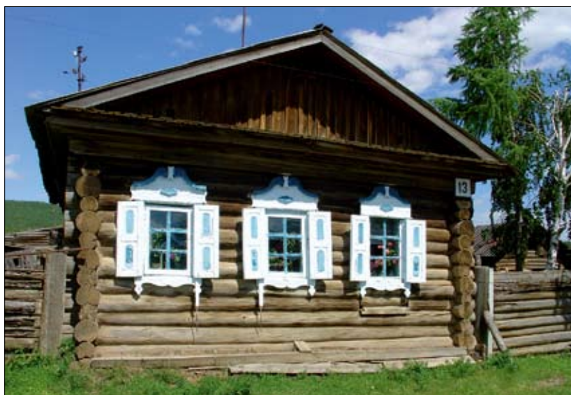
Fot. 4 | Domy na Syberii nie są budowane z bali grubszych niż 25 cm
