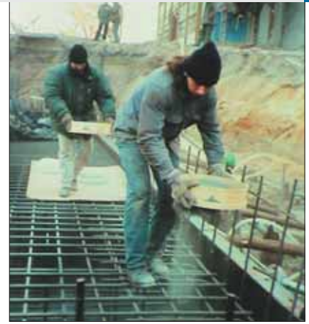
Wykonywanie posypki pod płytą fundamentową wieżowca Żaba Tower w Warszawie
