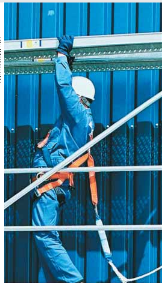
Fot. 2 Montaż rusztowania – Altrad Mostostal
