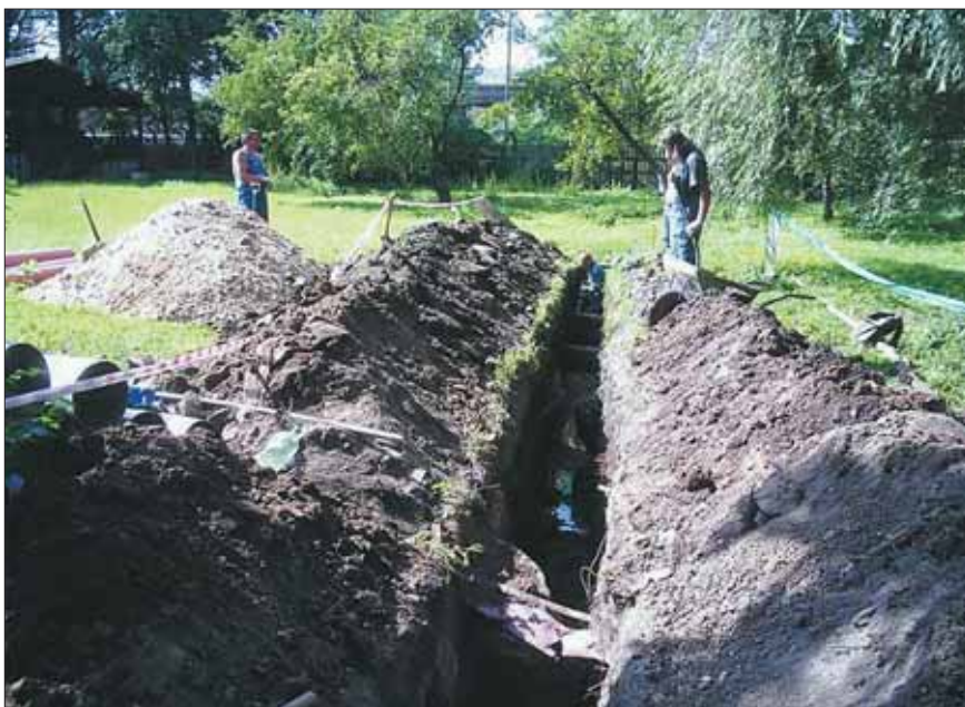
Fot. 2. Budowa nowej sieci kanalizacyjnej
