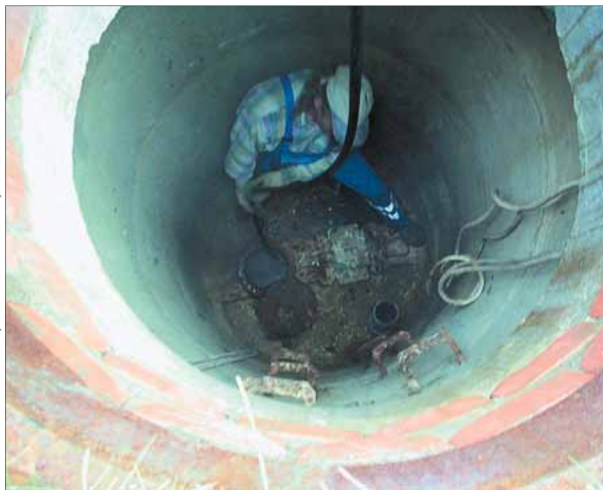
Fot. 1. Czyszczenie kanalizacji
