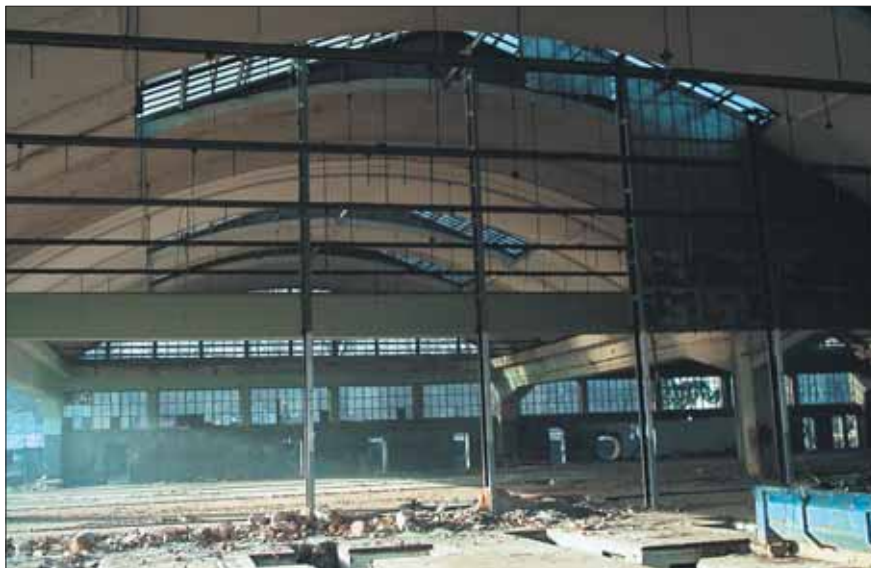
Fot. 1. Hala w trakcie remontu
