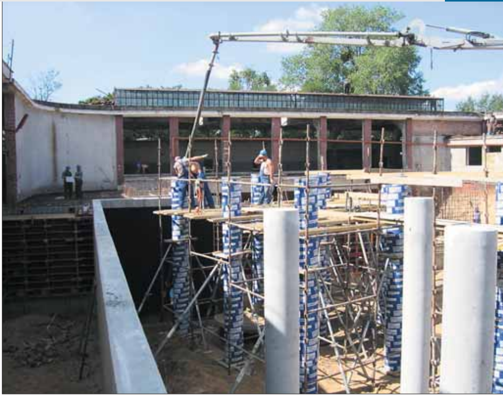
Fot. 2. Prace adaptacyjne; montaż dekoracyjnych pali na zewnątrz budynku
