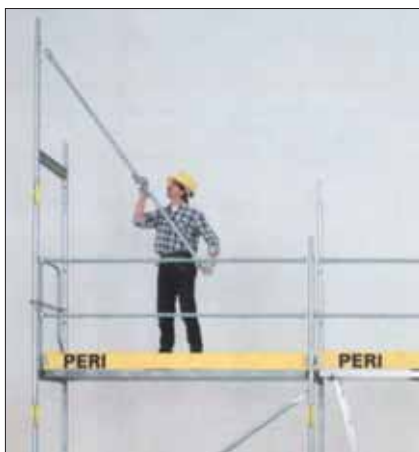
Fot. 3. Montaż barierki bezpieczeństwa – rozwiązanie PERI
