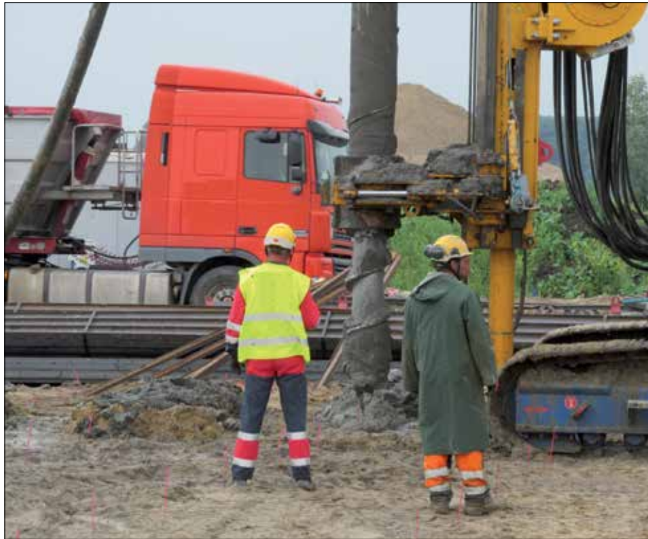
Fot. 1 | Maszyna do formowania betonowej części kolumny o zmiennym module sztywności za pomocą świda przemieszczeniowego z użyciem ciekłej mieszanki betonowej
