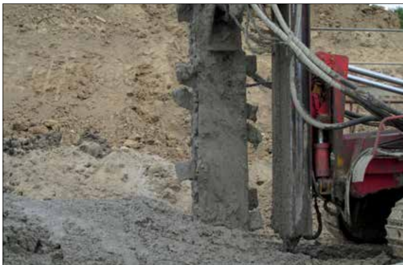
Fot. 6 | Maszyna do wykonywania ścian trenczerowych z podniesionym nieco mieczem i widocznym łańcuchem
