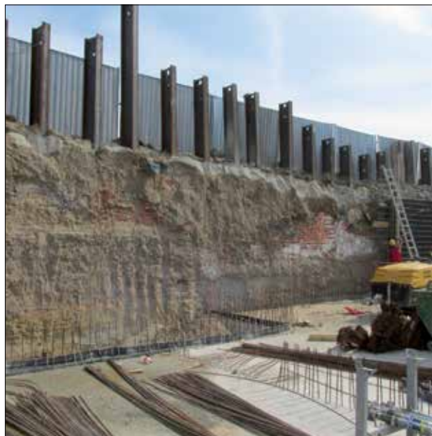
Fot. 10 | Gotowa ściana wykopu, ściana była zbrojona dwuteownikami na wzór ściany berlińskiej osadzonymi w trakcie wykonywania ściany. Jest to bardzo szybka i wydajna metoda formowania takich elementów
