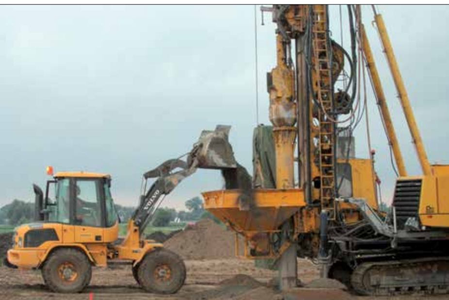
Fot. 3 | Zасыpywanie suchej mieszanki betonowej do zasobnika maszyny
