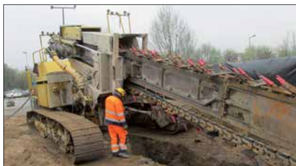
Fot. 9 | Maszyna w trakcie wykonywania ściany oporowej; wykonywała ona ścianę oporową – obudowę wykopu o głębokości dwóch kondygnacji – zabezpieczającą jednocześnie przed napływem wody z sąsiedniej rzeki
