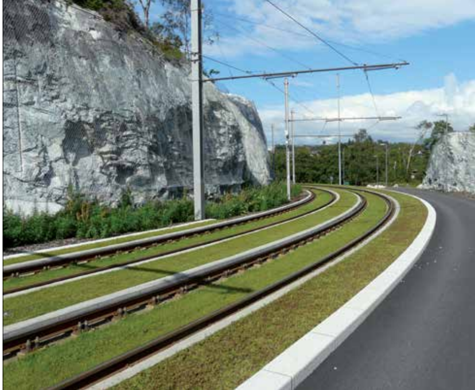
Fot. 1 | Torowisko z zabudową trawiastą i jezdnią serwisową
