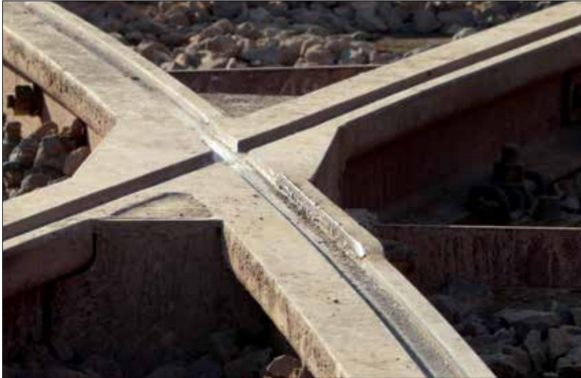
Fot. 2 | Krzyżownica tramwajowa płytkorowkowa
