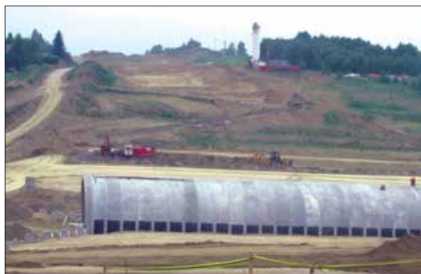
Fot. 8 | Plac budowy wzmocnienia wysokiego nasypu
