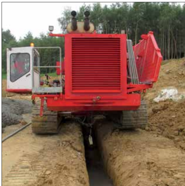
Fot. 7 | Wstępny rowek służący do zebrania nadmiaru urobku i uformowania wierzchu ściany
