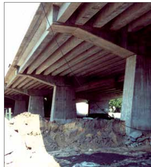
Fot. 1 | Wiadukt w Skierniewicach, pierwsza realizacja z belek T (fot. W. Doboszyński)
