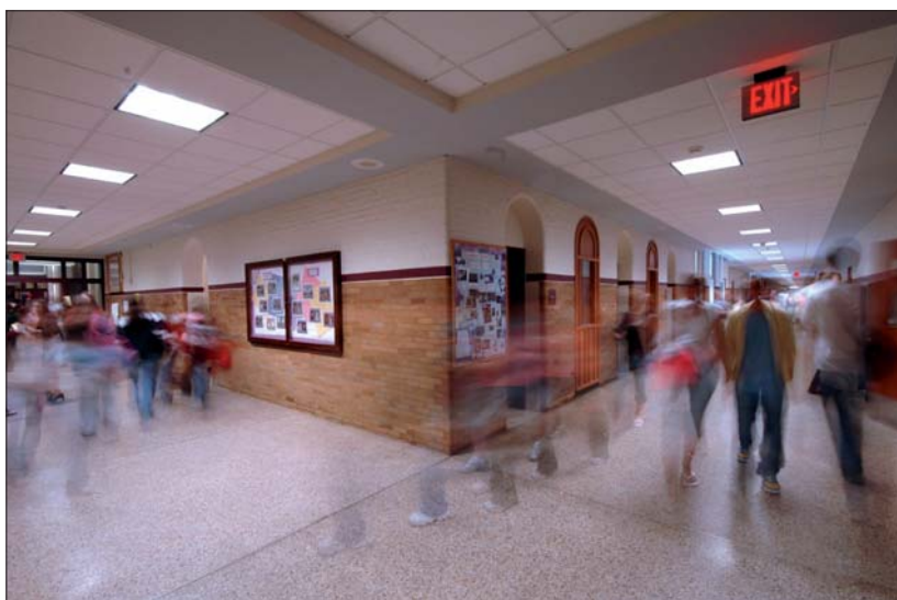
Fot. 2 Korytarz szkolny. Dźwiękochłonne sufity podwieszane oraz ściany wykończone nietynkowaną cegłą, która ma lepsze właściwości dźwiękochłonne niż tynkowana ściana
