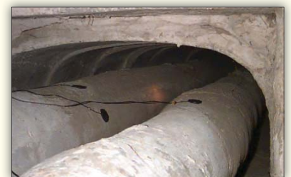
Fot. 2 | Pomiar gęstości strumienia ciepła na powierzchni izolacji
