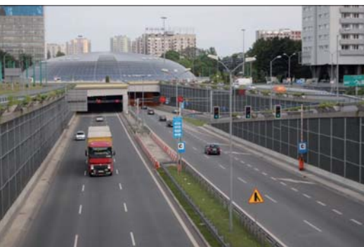
Fot. 1 | Dojazd i tunel Drogowej Trasy Średnicowej w Katowicach
