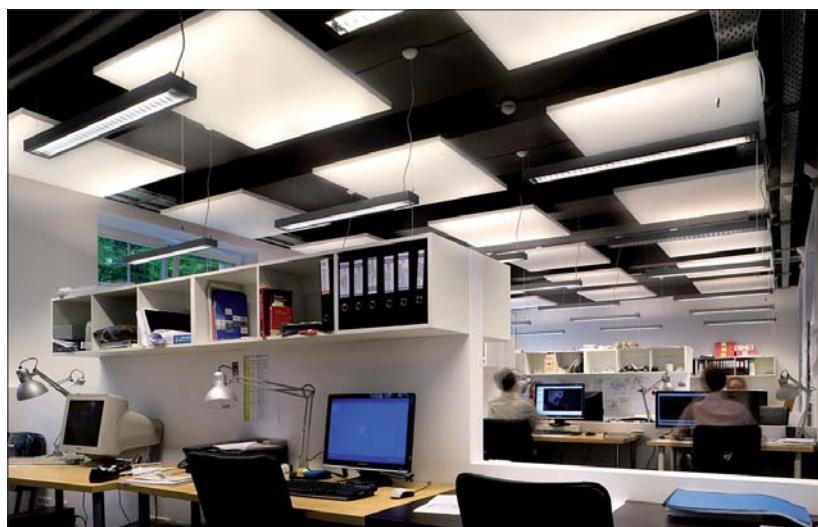
Fot. 5 Biuro typu open space. Odpowiednią chłonność akustyczną zapewniają wolno wiszące panele dźwiękochłonne i wykładzina dywanowa. Wysokie regały działają jak ekrany ograniczające propagację dźwięku
