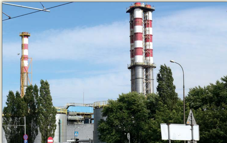
Ciepłownia Wola w Warszawie
