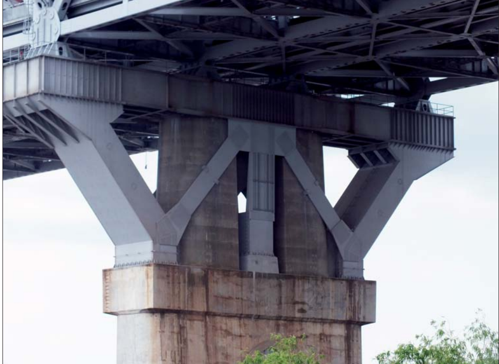
Fot. 2 | Most po przebudowie
