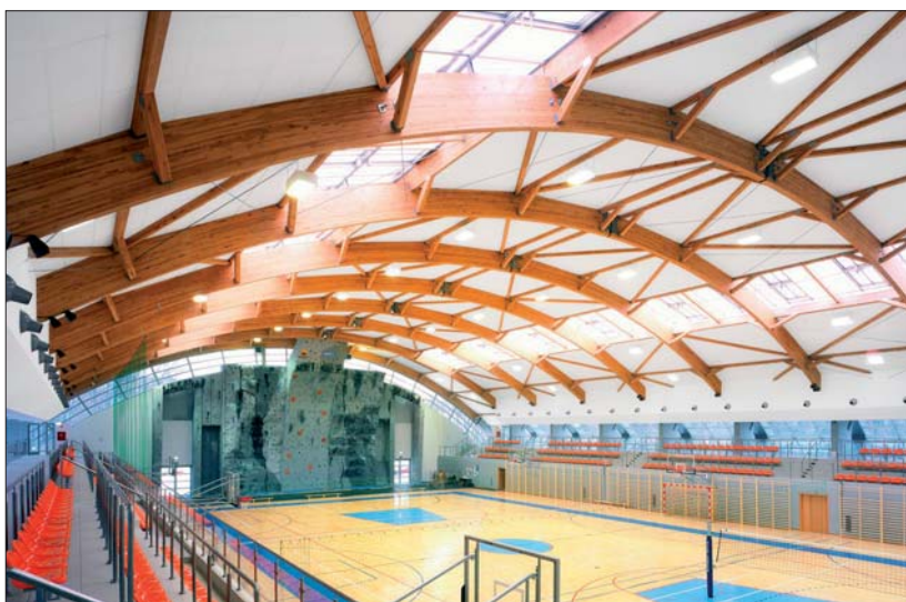
Fot. 4 Hala sportowo-widowiskowa. Dach pokryty w ok. 80% płytami dźwiękochłonnymi. Obustronne trybuny, drabinki gimnastyczne i ścianka wspinaczkowa na ścianie szczytowej gwarantują dobre rozproszenie dźwięku – użycie materiałów dźwiękochłonnych na ścianach nie było konieczne
