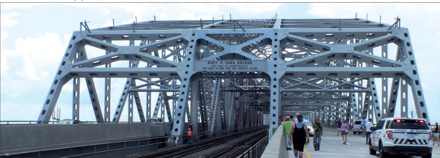
Fot. 1 | Most po przebudowie
