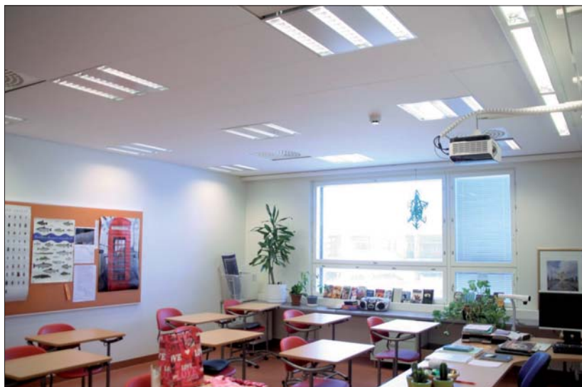
Fot. 1 Mała sala lekcyjna z sufitem dźwiękochłonnym i ściennymi panelami dźwiękochłonnymi na tylnej ścianie
