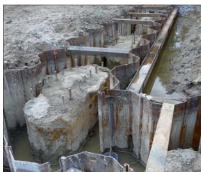
Fot. 3 | Bary w fundamencie przejścia dla zwierząt na obwodnicy Wyszkowa.
