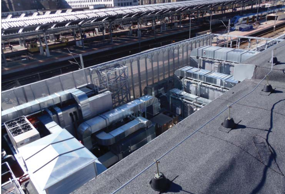
Fot. 2 | Dachy dworca PKP i peronów stacji kolejowej Katowice
