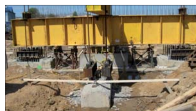
Fot. 7 | Konstrukcja obciążająca zakotwiona do czterech sąsiednich baret
