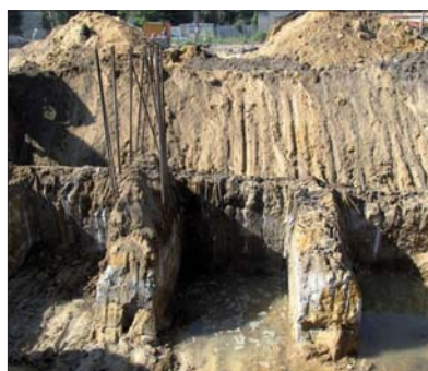
Fot. 5 | Ściana teowa w przyczółku wiaduktu drogowego nad DTŚ w Gliwicach
