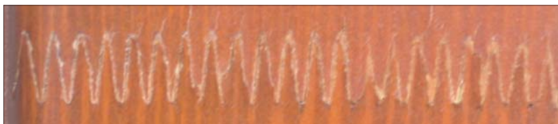
Fot. 6 | Łączenie drewnianych elementów okna na złącze wieloklinowe
