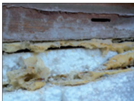
Fot. 7. Podparcie drzwi na styropianie
