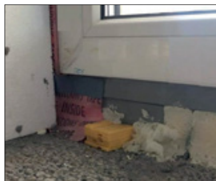
Fot. 15. Typowy montaż okna na piankę PU, styropian, cegły i kliny z użyciem taśmy paroszczelnej (w narożu)
