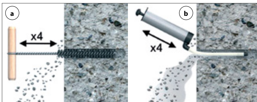
Fot. 6. Oczyszczanie szczotką i przedmuchiwanie miejsca mocowania kotwy
