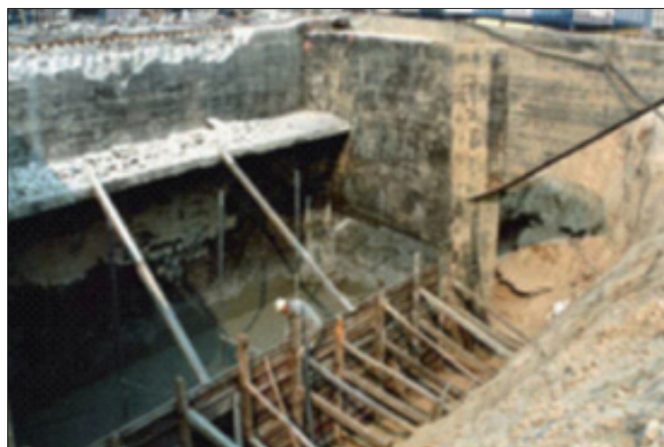
Fot. 5 Wypełnienie przyczółka pianobetonem [29]
