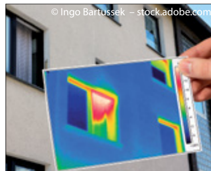
Fot. 18. Termowizja montażu okna
