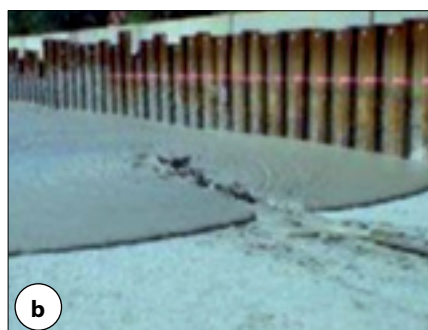
Fot. 2. Zastosowanie pianobetonu: a, b) przy przebudowie nawierzchni autostrady Central Road [24], c) przy naprawie drogi powiatowej w Kórniku [7]
