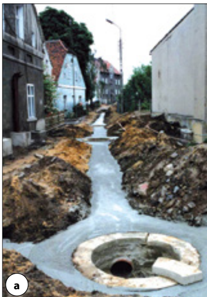
Fot. 4. Wypełnienie pustych przestrzeni pianobetonem: a) [28], b) [7]
