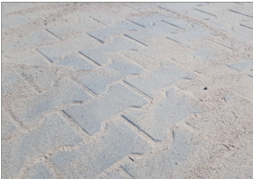
Fot. 2. Betonowa kostka brukowa Behaton w trakcie wypełniania fug piaskiem płukany
