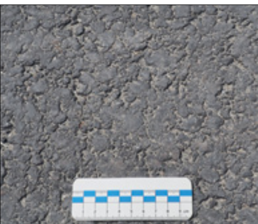
Widok gotowej warstwy z SMA 16 JENA po wbudowaniu (fot. K. Błażejowski)
