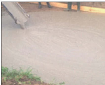
Fot. 3. Wbudowywanie mieszanki pianobetonowej na poligonie doświadczalnym (fot. autorki)
