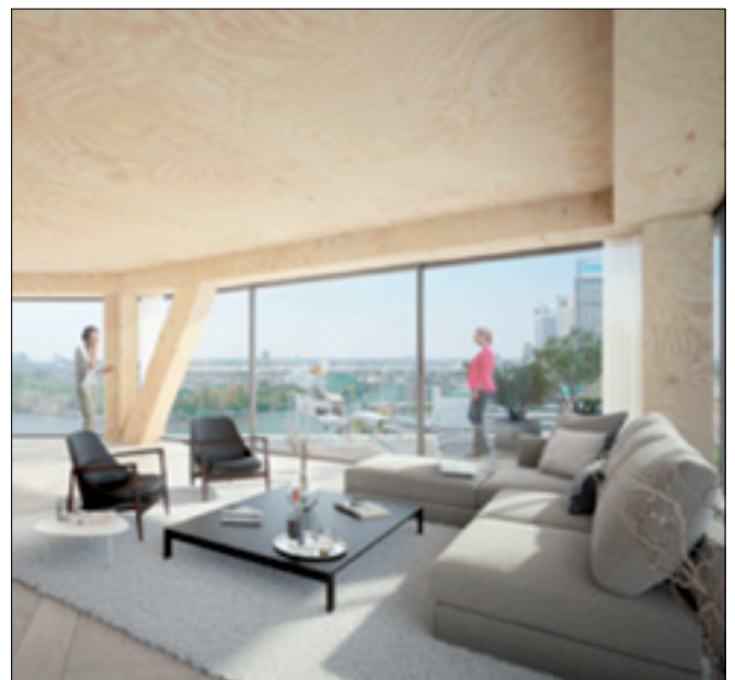
Fot. 4. Widok wnętrza budynku Haut ukazujący odsłonięte podbicia (projekt w Amsterdamie)
