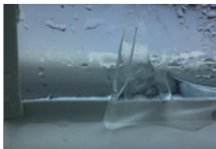
Fot. 13. Lód na oknie energooszczędnym o współczynniku przenikania ciepła U = 0,6 \text{ W/m}^2\text{K}
