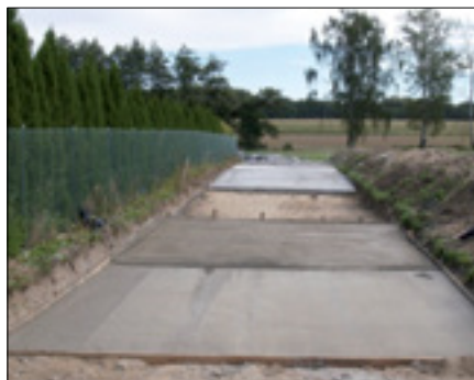
Fot. 3. Wbudowywanie mieszanki pianobetonowej na poligonie doświadczalnym (fot. autorki)
