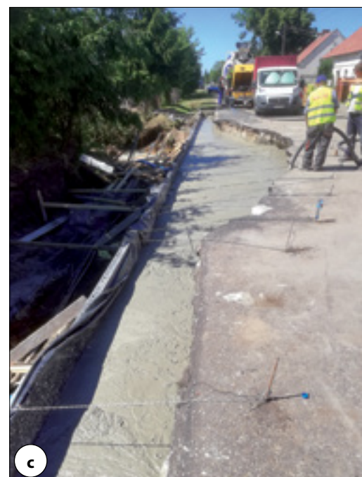
Fot. 2. Zastosowanie pianobetonu: a, b) przy przebudowie nawierzchni autostrady Central Road [24], c) przy naprawie drogi powiatowej w Kórniku [7]
