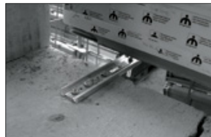
Fot. 12. Poprawny montaż konsoli
