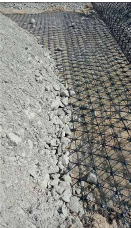
Fot. 10. Stabilizacja warstwy kruszywa georusztem
