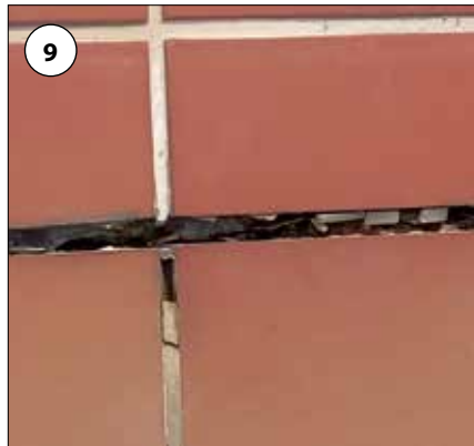
Fot. 6–9. Ogólny układ uszkodzeń w strefie podparcia biegu schodowego i uszkodzenia dylatacji konstrukcyjnej
