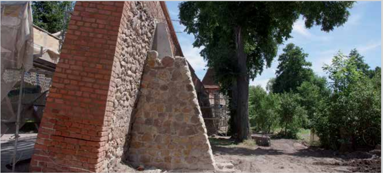
Widok muru z gotową przyporą żelbetową licowaną murem (fot. P. Puchalski)
