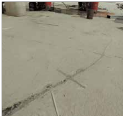
Fot. 8. „Zszycie” pęknięć podłoża betonowego
