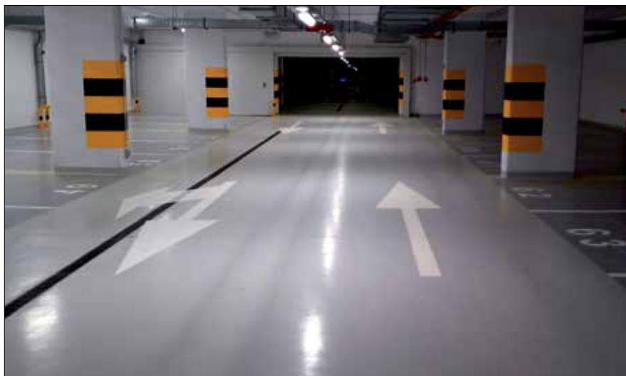
Fot. 2. Nawierzchnia epoksydowa w garażu podziemnym
