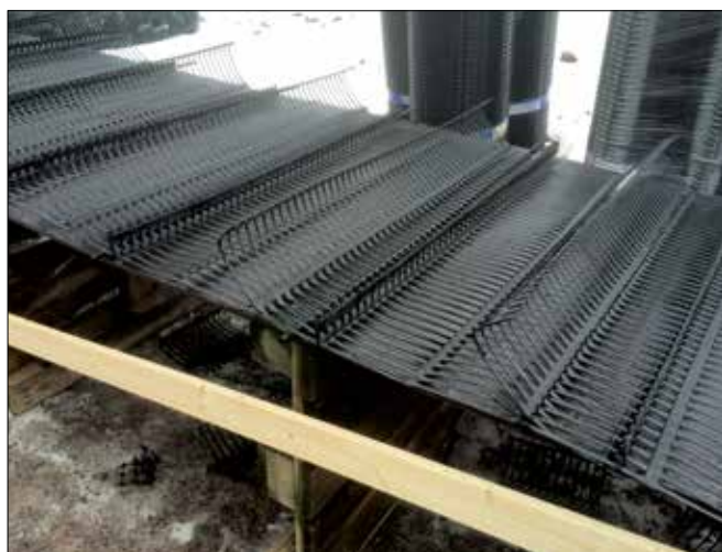
Fot. 3. Montaż geomateraca z elementów georusztu
