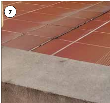
Fot. 6–9. Ogólny układ uszkodzeń w strefie podparcia biegu schodowego i uszkodzenia dylatacji konstrukcyjnej
