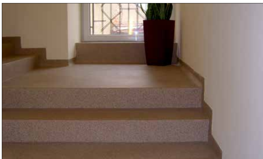
Fot. 6. Powłoka epoksydowa na klatce schodowej budynku wielorodzinnego
