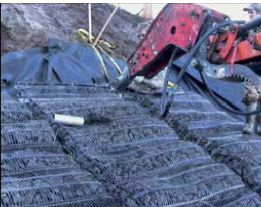
Fot. 9. Kotwienie geomateraca na skarpie
