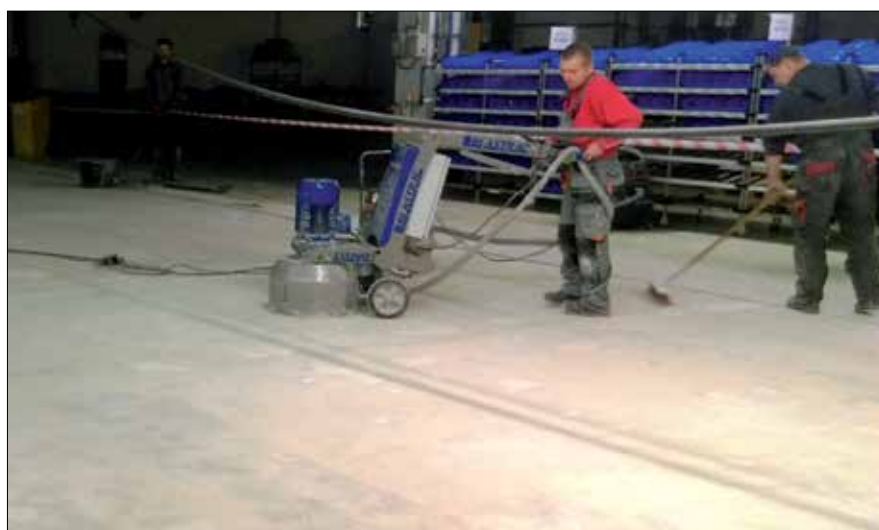
Fot. 7. Szlifowanie podkładu betonowego pod powłokę epoksydową
