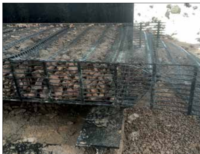
Fot. 4. Geomaterac w trakcie wypełniania kruszywem wewnętrznych sekcji
