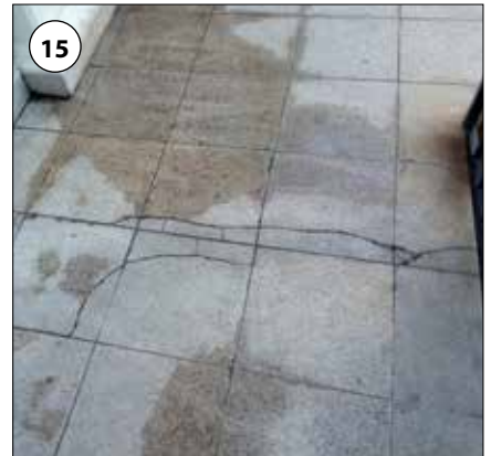
Fot. 6–9. Ogólny układ uszkodzeń w strefie podparcia biegu schodowego i uszkodzenia dylatacji konstrukcyjnej
