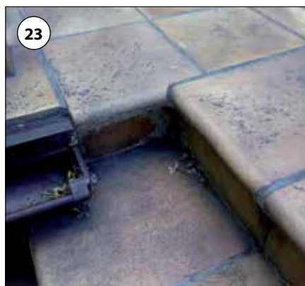
Fot. 22–26. Uszkodzenia tarasu i schodów prowadzących na poleć. Prace naprawcze muszą obejmować zarówno sam taras, jak i schody
