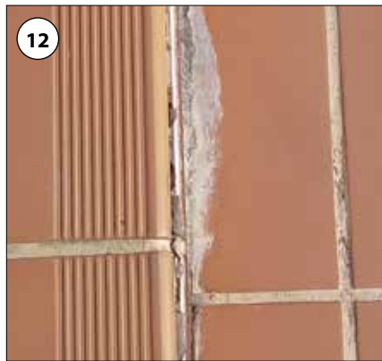
Fot. 6–9. Ogólny układ uszkodzeń w strefie podparcia biegu schodowego i uszkodzenia dylatacji konstrukcyjnej
