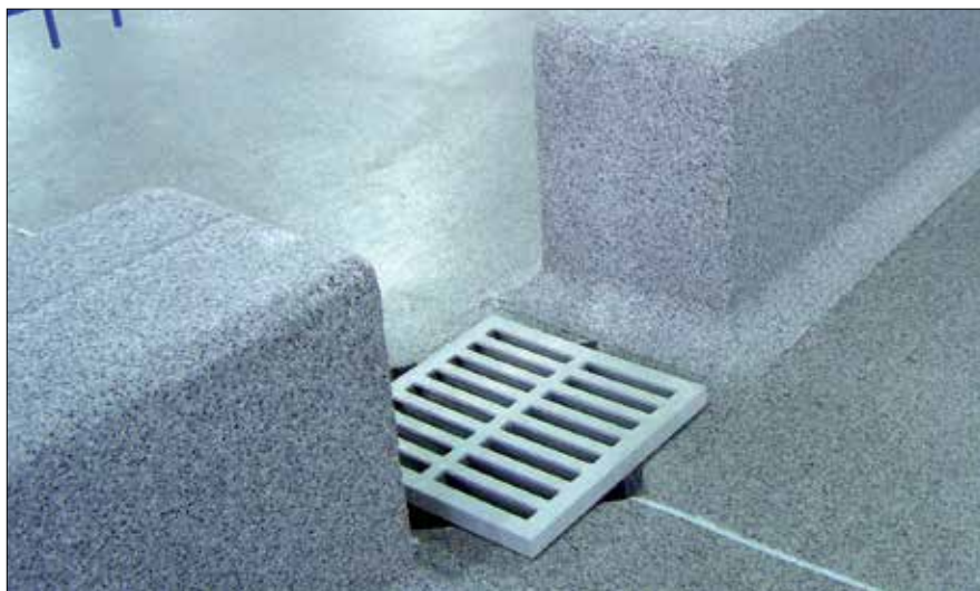
Fot. 4. Cokół betonowy wykończony powłoką epoksydową
