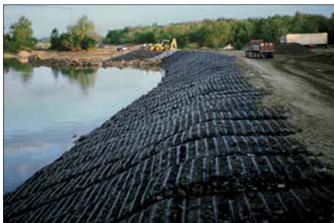
Fot. 7. Zabezpieczenie wału geomateracami przeciwoerozyjnymi
