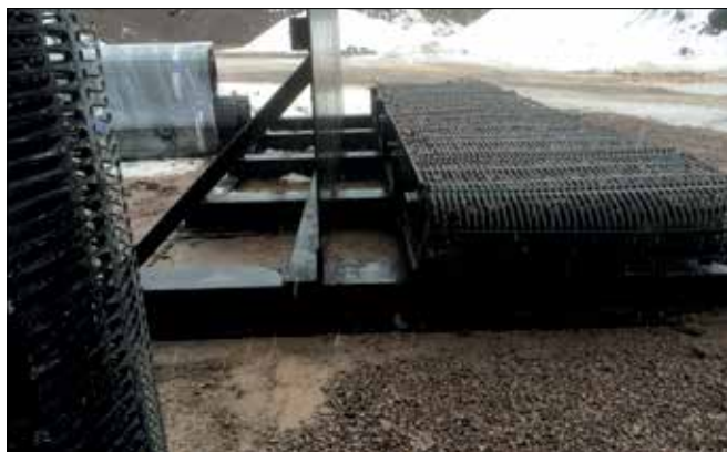
Fot. 5. Gotowy geomaterac przed transportem na miejsce instalacji
