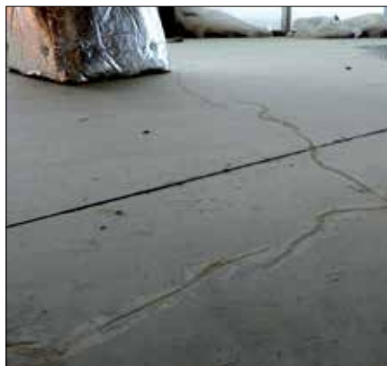
Fot. 9. Pęknięcia podłoża betonowego scalone żywicą epoksydową
