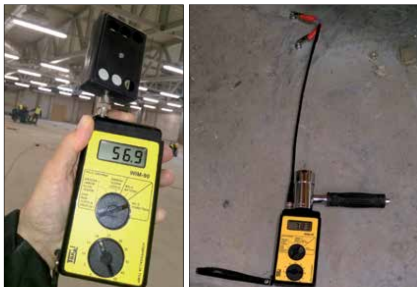
Fot. 10. Pomiar wilgotności powietrza i podkładu betonowego wilgotnościomierzem
