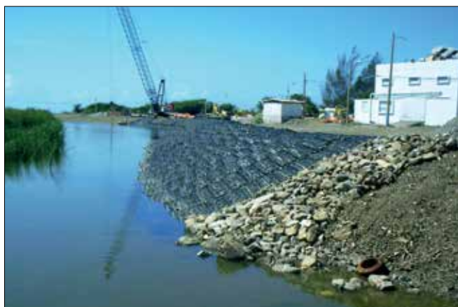
Fot. 8. Przykład montażu geomateracy przy wykorzystaniu dźwigu
