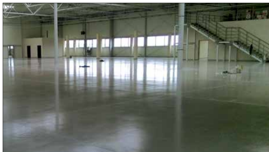
Fot. 1. Posadzka epoksydowa w hali przemysłowej
