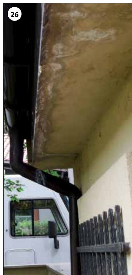
Fot. 22–26. Uszkodzenia tarasu i schodów prowadzących na poleć. Prace naprawcze muszą obejmować zarówno sam taras, jak i schody
