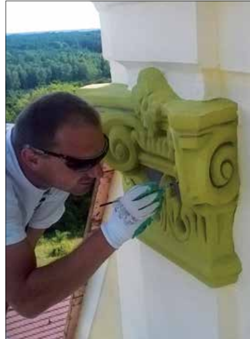
Fot. 3 | Do wykonywania elementów sztukatorskich stosowane są gotowe szybko wiążące zaprawy sztukatorskie
