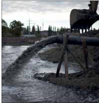
Fot. 6 | Pole refulacyjne w trakcie prowadzenia prac
