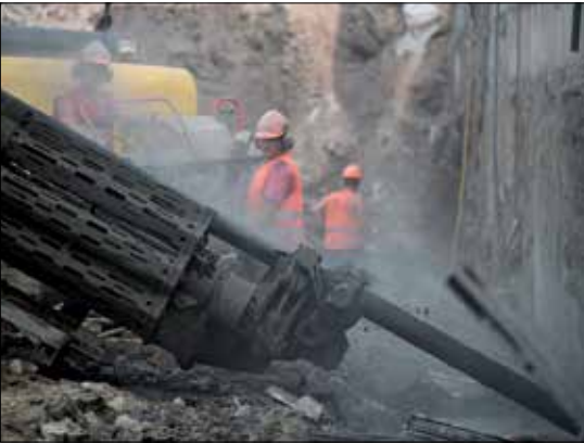
Fot. 4 | Wiercenie tymczasowych kotwi gruntowych
