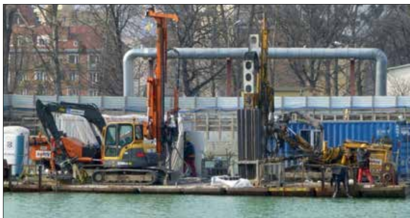
Fot. 9 | Wykonywanie mikropali kotwiących
