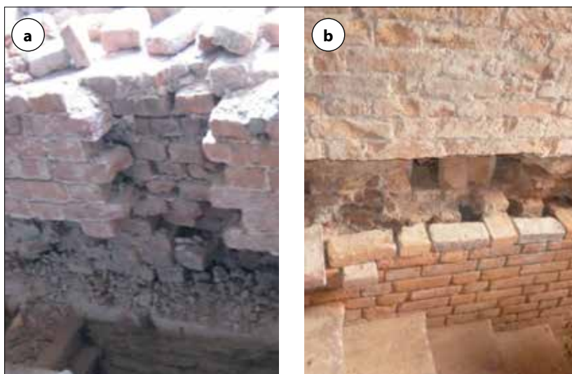
Fot. 3 | Przemurowanie zdegradowanego pasma międzyokiennego (a) i ściany klatki schodowej (b)
