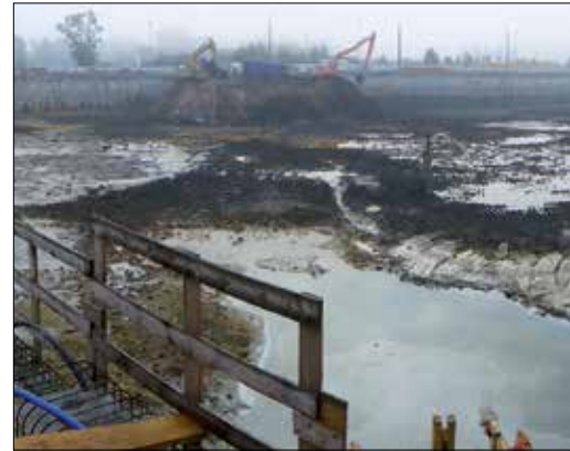
Fot. 7 | Widok budowy w trakcie pracy koparek
