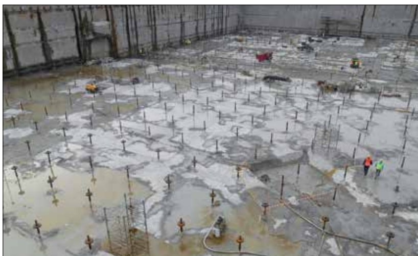
Fot. 11 | Korek po oczyszczeniu i uszczelnieniu, widoczne mikropale z płytami kotwiącymi
