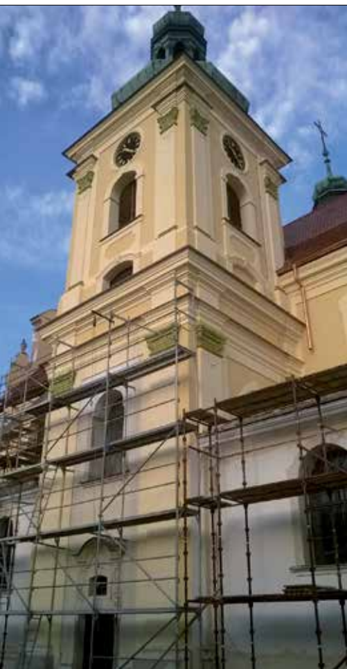
Fot. 1 | Kościół Ofiarowania Najświętszej Maryi Panny w Bieniszewie, do którego renowacji zastosowane zostały gotowe zaprawy renowacyjne
