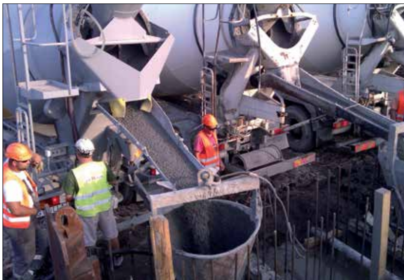
Fot. 3 | Betonowanie sekcji ściany szczelinowej
