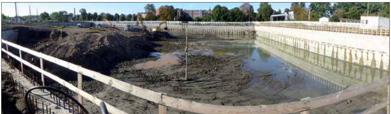
Fot. 5 | Widok budowy w trakcie wykopu klasycznego (archiwum Soletanche)
