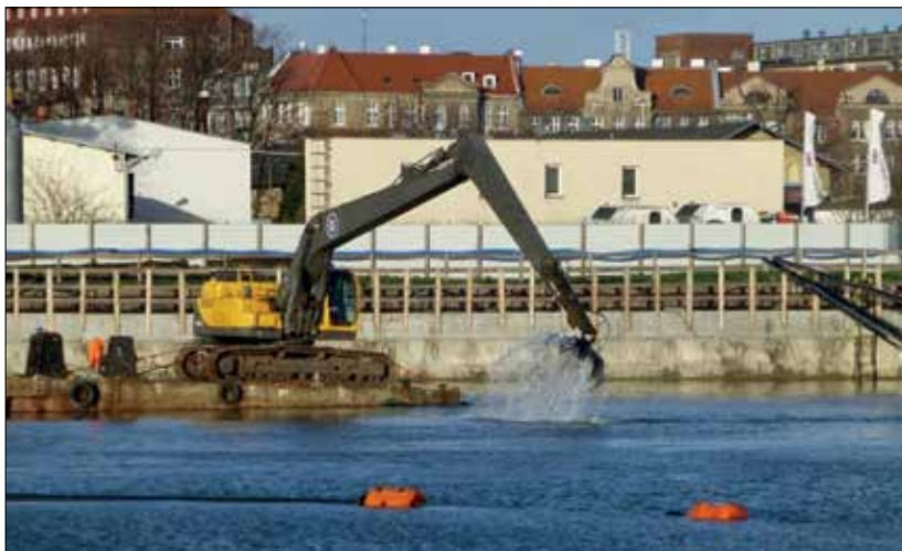
Fot. 8 | Usuwanie kamieni z dna wykopu
