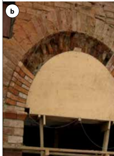
Fot. 5 | Przemurowanie nadproży: a – klinowe, b – półkuliste
