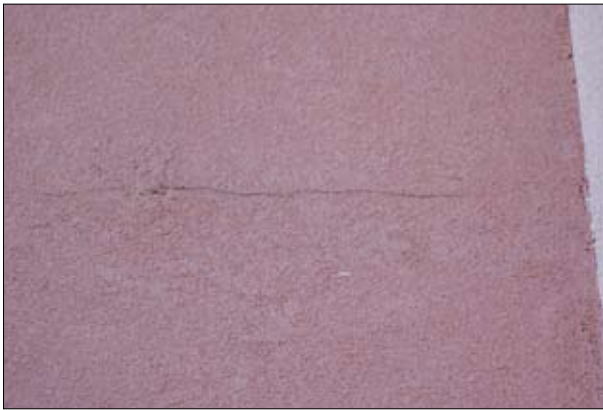
Fot. 1, 2 | Pęknięcia elewacji ocieplonego budynku
