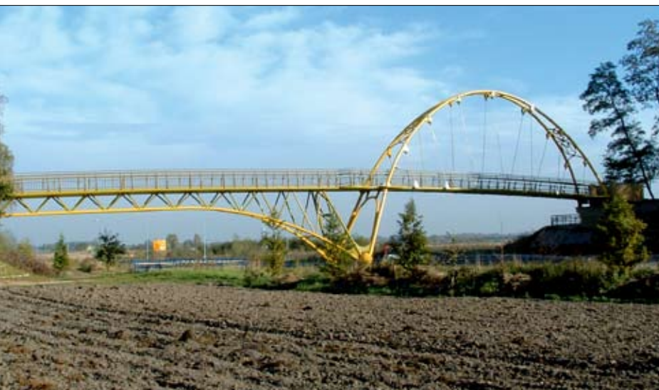
Fot. 1 Łukowo-kratownicowa kładka nad ul. Chemików w Bieruniu Starym (28,0 + 24,5 m)
