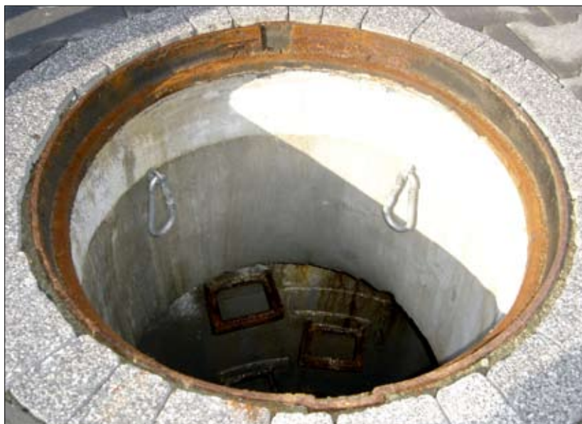
Fot. 3 | Górny fragment studni z dodatkowymi uchwytami ułatwiającymi wejście
