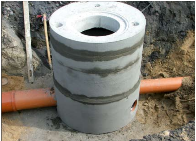
Fot. 2 | Łączenie prefabrykatów studni, zastosowana izolacja przeciwwodna
