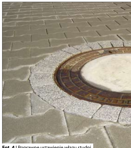
Fot. 4 | Poprawne ustawienie wjazdu studni
