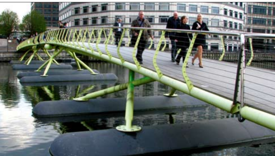
Fot. 4 | Pontonowa kładka West India Quay (3 x 21,0 + 2 x 15,0 m), Londyn, Wielka Brytania
