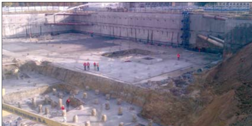
Fot. 1 | Widok placu budowy – prace związane z fundamentowaniem głębokim w suchym wykopie
