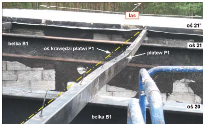
Fot. 3 | Przykład zdeformowanej giętno-skrętnie płatwi P1 w hali produkcyjnej w polu 20'–21'
