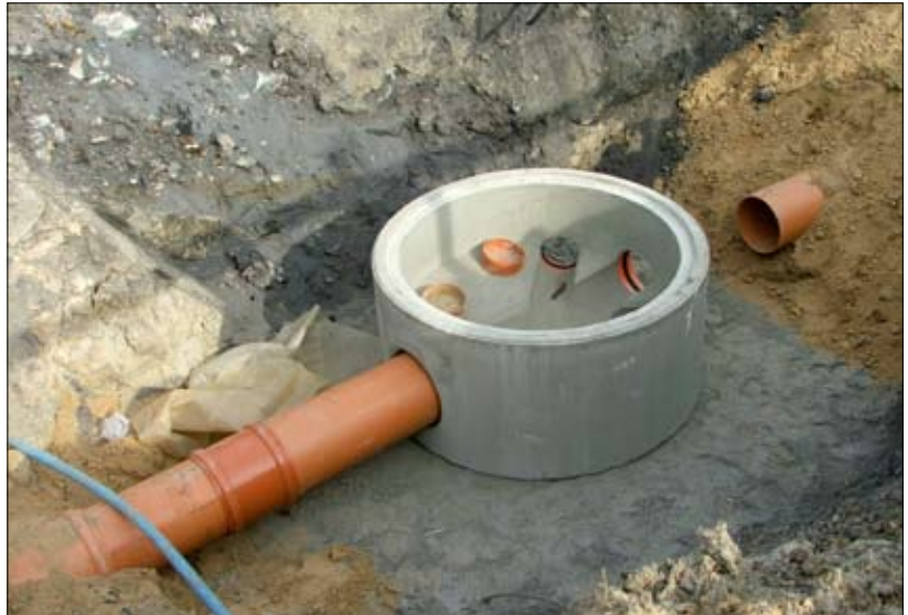
Fot. 1 | Posadowienie studni na podbudowie betonowej z widoczną kinetą
