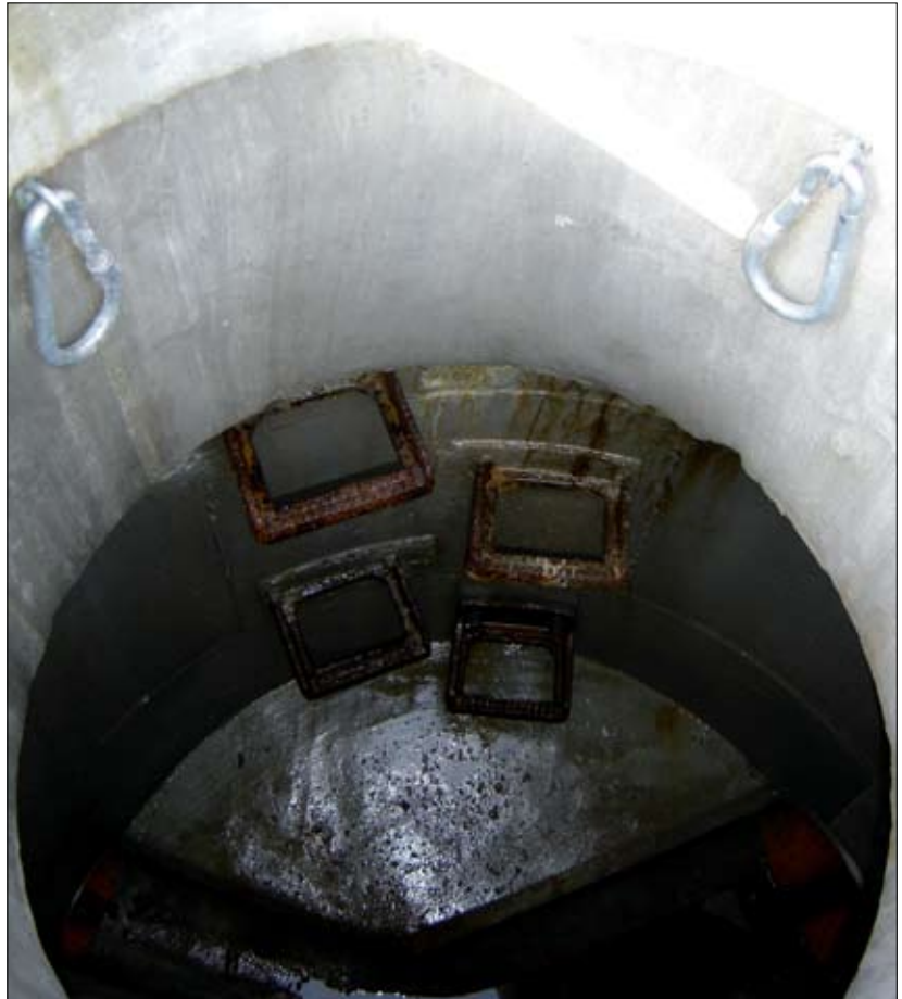
Fot. 5 | Widok stopni i kinety studni
