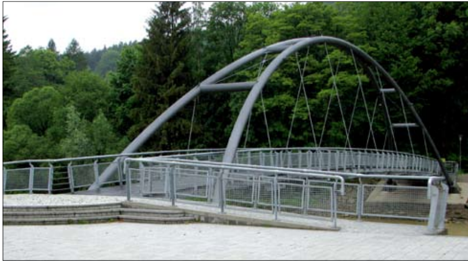
Fot. 2 | Łukowa kładka przez rzekę Sotę w Węgierskiej Górze (51,3 m)
