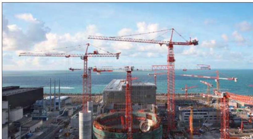
Fot. | Widok obiektu jądrowego w Finlandii podczas realizacji [8]
