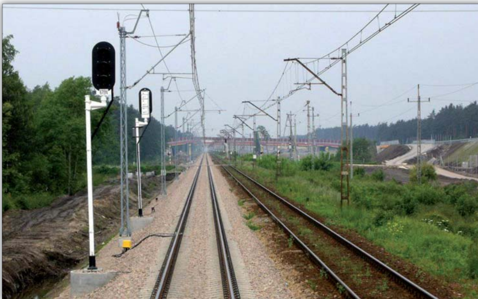
Fot. 10 | Przebudowany tor nr 1 na szlaku Biadolino-Bogumiłowice
