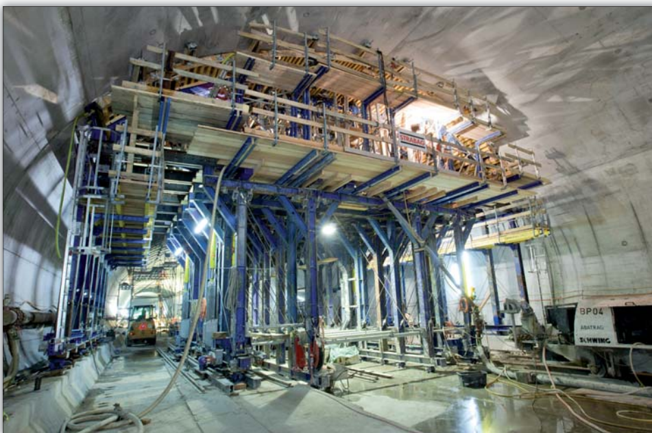
Fot. 1 | Tunel Gotthard Base, Szwajcaria
