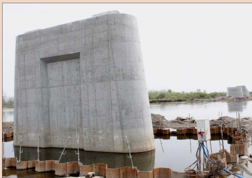
Budowa mostu w Połańcu
