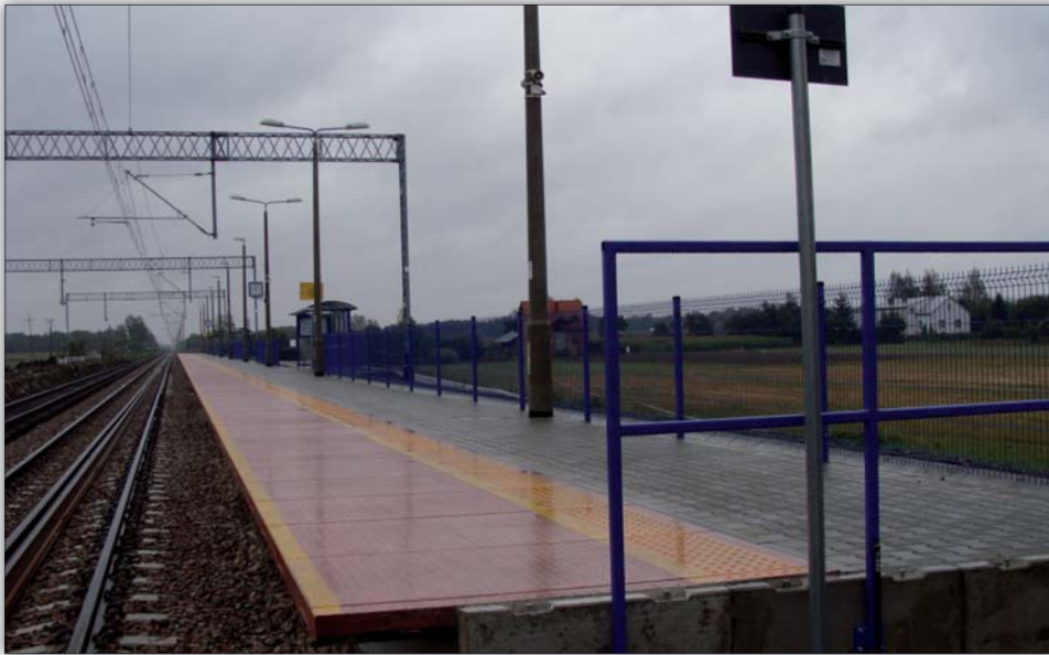
Fot. 4 | Oznakowanie pasów bezpieczeństwa na nowo wybudowanym peronie na przystanku w Lubzinie
