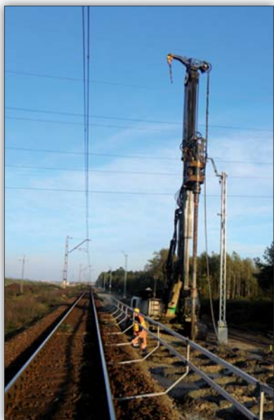
Fot. 1 | Wykonywanie wzmocnień podtorza w torze nr 1 na szlaku Biadolinny-Bogumiłowice
