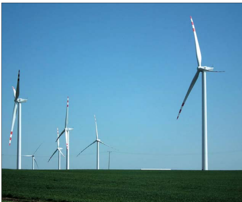
Fot. 1 | Pierwszy na Opolszczyźnie park wiatrowy „Lipniki” o mocy 30,75 MW z zainstalowanymi 15 turbinami firmy REpower
