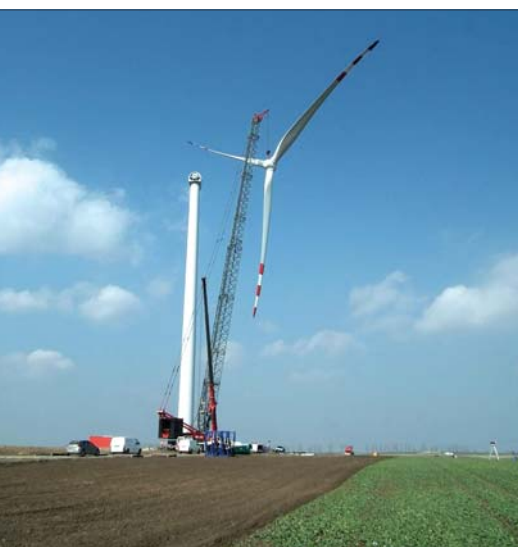
Fot. 4 | Sam montaż trwa krótko – czasami wystarczy kilkanaście godzin. Na zdjęciu – ostatni etap montażu, instalacja wirnika
