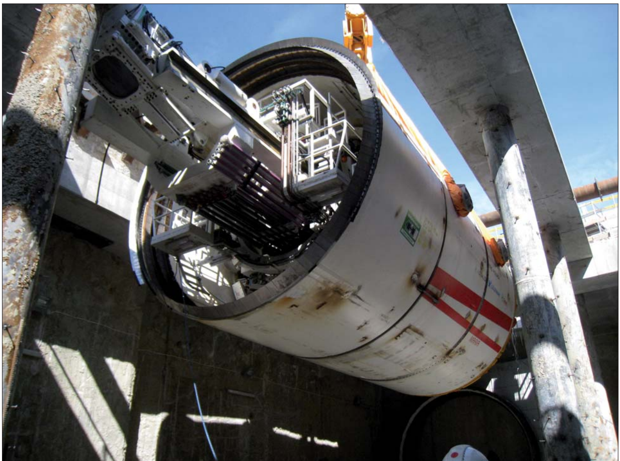
Fot. 3 Operacja opuszczania tarczy TBM Maria do szybu startowego na stacji C9 – przejście tarczy przez specjalnie zaprojektowany do tego celu otwór technologiczny w stropie pośrednim (fot. autor)
