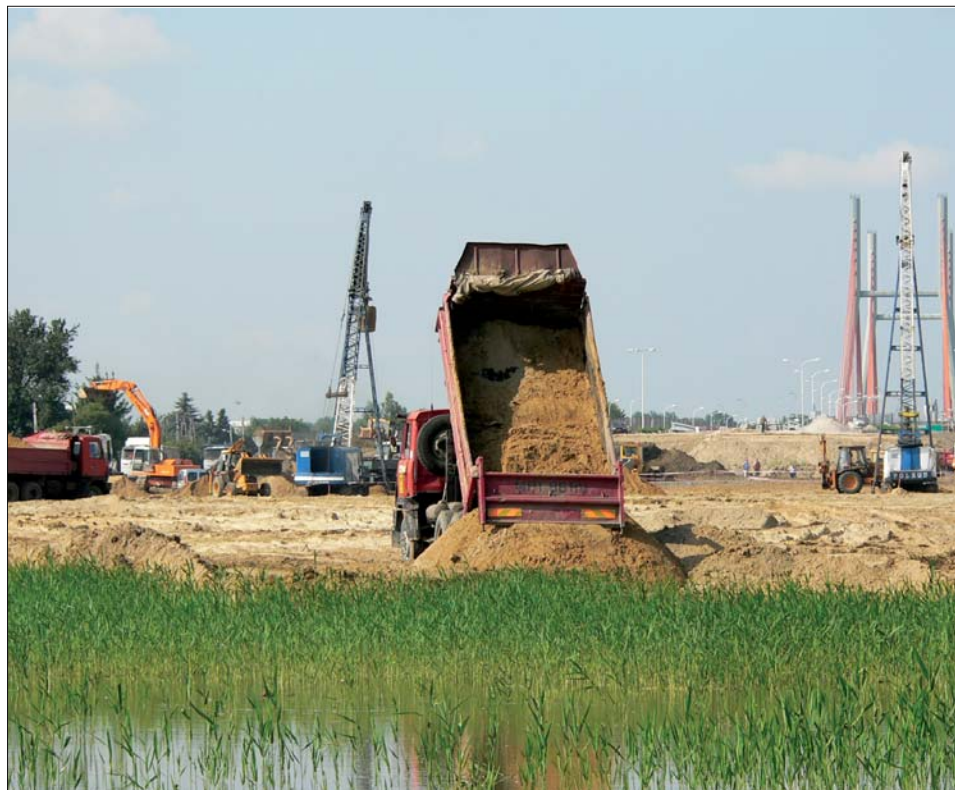
Fot. 1 | Wykonywanie nasypów Trasy Siekierkowskiej w Warszawie
