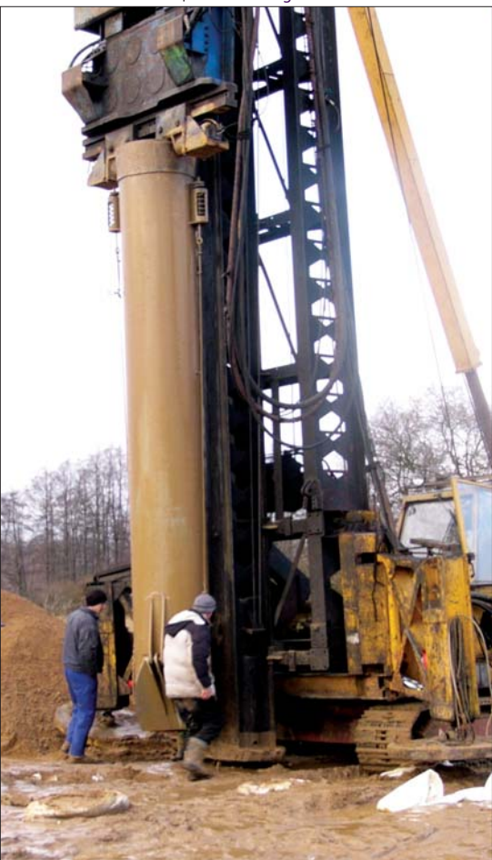
Fot. 3 Sprzęt do wykonywania kolumn w koszulce z geotkanin
