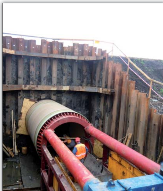
Fot. 2 | Wykonywanie przepustu o średnicy 3,0 m na stacji Bogumiłowice
