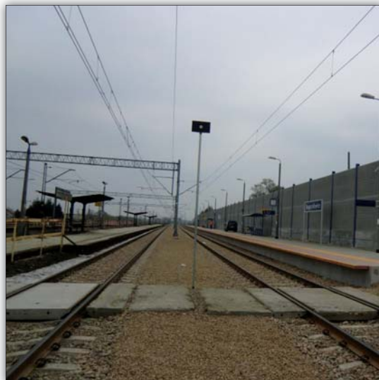
Fot. 3 | Nowo wybudowany peron przy torze nr 3 oraz peron tymczasowy na stacji Bogumiłowice
