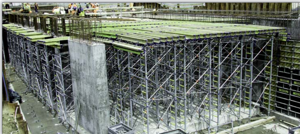
Fot. 3 | Tunel pod koleją w Ursusie
