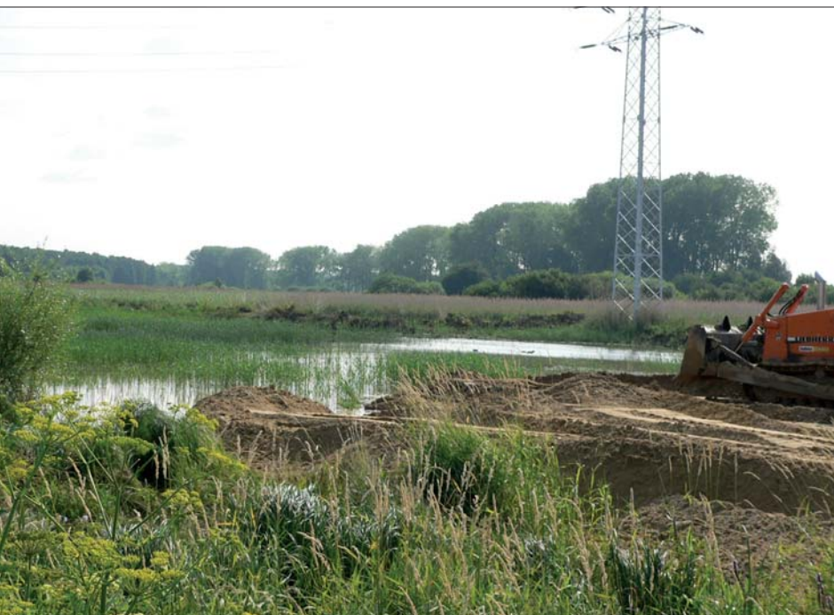
Fot. 2 | Wykonywanie nasypów Trasy Siekierkowskiej w Warszawie
