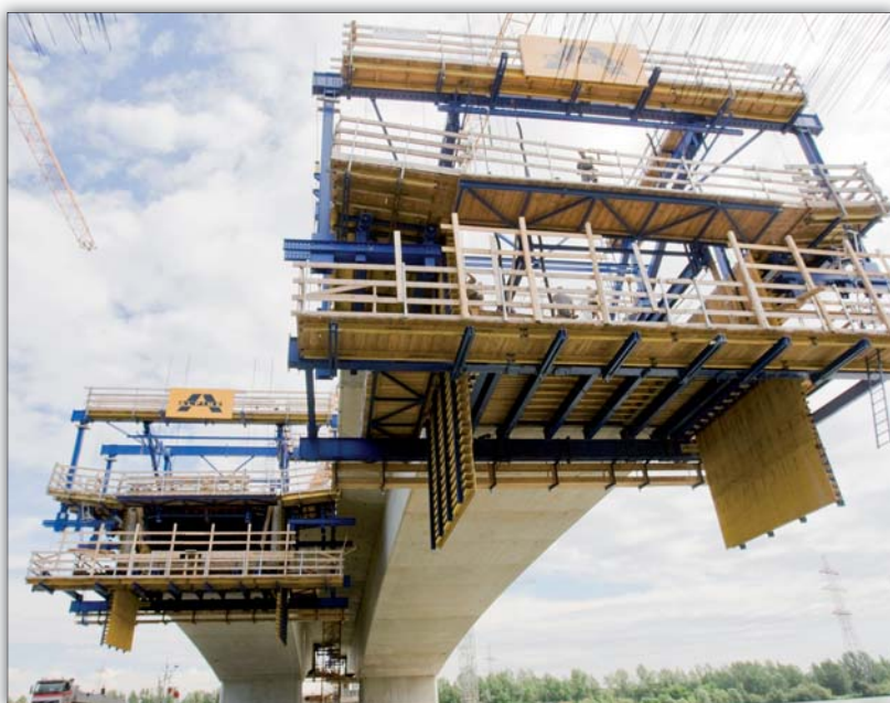
Fot. 2 | Most na Dunaju, Traismauer, Austria
