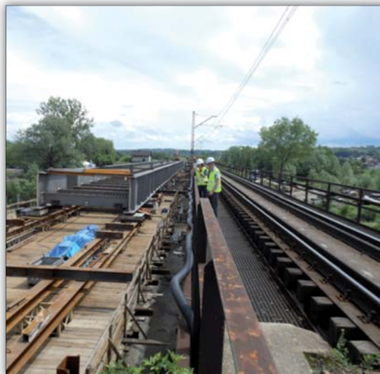
Fot. 5 i 6 Budowa mostu na rzece Raba – demontaż starych dźwigarów i nasuwanie nowych przęseł
