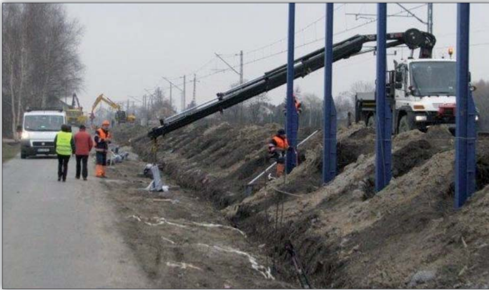
Fot. 9 | Budowa ekranów akustycznych przy torze nr 1 na stacji Biadolino
