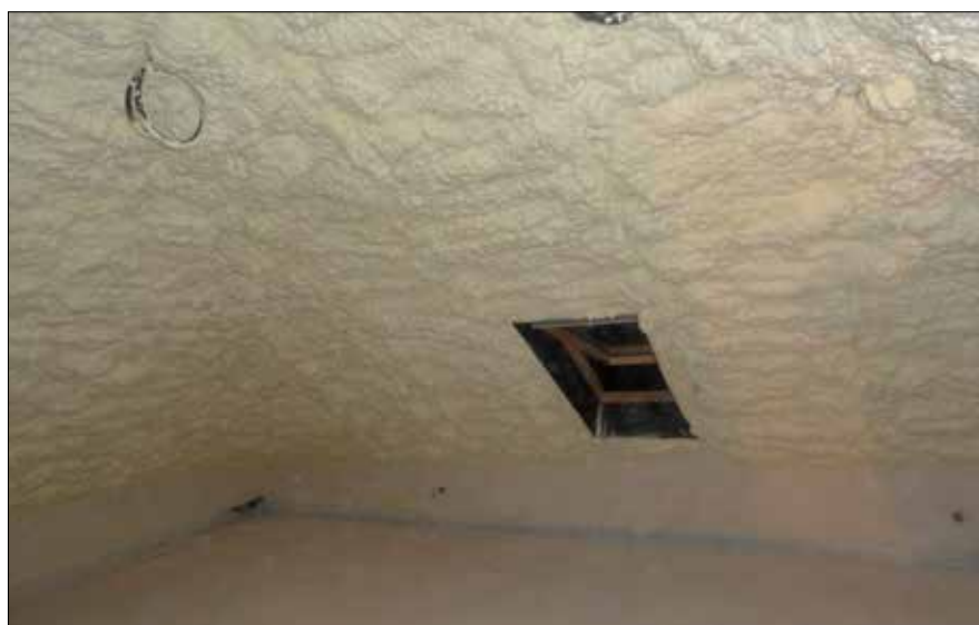
Fot. 2. Poddasze ocieplone pianą otwartokomórkową
