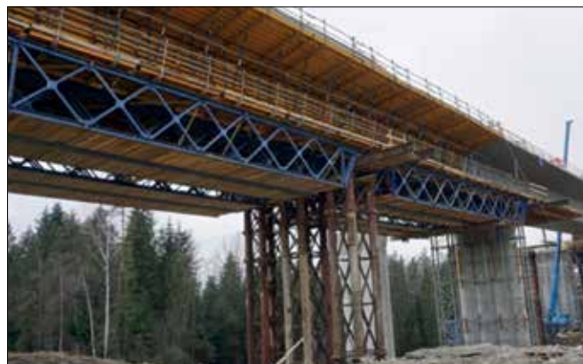
Fot. 7. Deskowanie kolejnego przęsła
