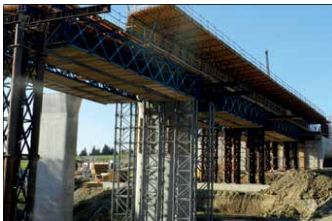
Fot. 6. Deskowania pierwszego przęsła estakady (obiektu 21 drogi S7)
