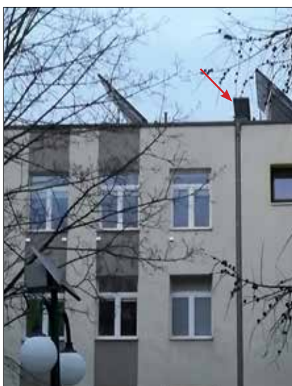
Fot. 2. Panele fotowoltaiczne stanowiące przeszkodę dla sąsiadującego kominą
