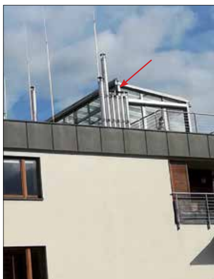
Fot. 1. Zbyt nisko wyprowadzone kominy względem przeszkód – ogrodu zimowego sąsiadującego kominą
