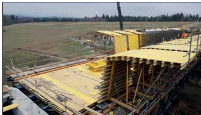
Fot. 8. Deskowania skrzydełka
