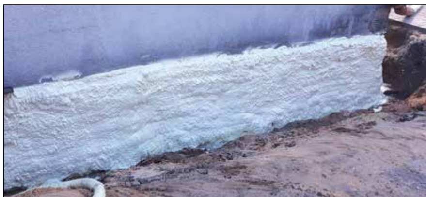
Fot. 3. Fundamenty ocieplone pianą zamkniętokomórkową
