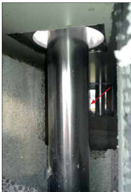
Fot. 5. Wkład kominowy ograniczający swobodny przepływ wiatru
