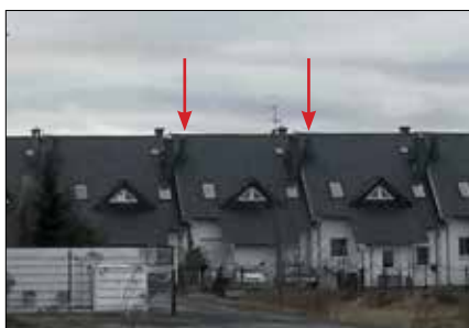
Fot. 4. Kominą stanowiące przeszkody względem siebie
