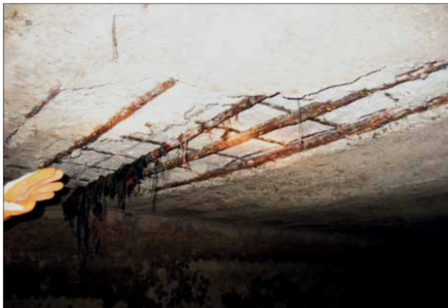
Fot. 1. Korozja żelbetowego stropu nad zbiornikiem w wyniku oddziaływania biogenego kwasu siarkowego (zdjęcie wykonane przez Alberta Berenguel Puigdomenech – BASF Business & Marketing Manager – Industrial and Concrete Refurbishment Europe)
