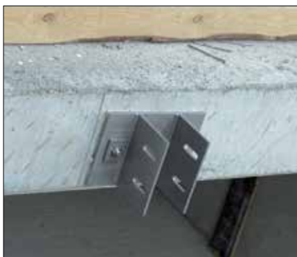
Fot. 3. Wspornik pod zamocowanie ściany osłonowej elewacyjnej
