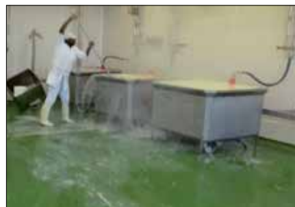
Fot. 3. Obciążenia termiczne i chemiczne posadzki w cyklu technologicznym w zakładach przetwórstwa spożywczego
