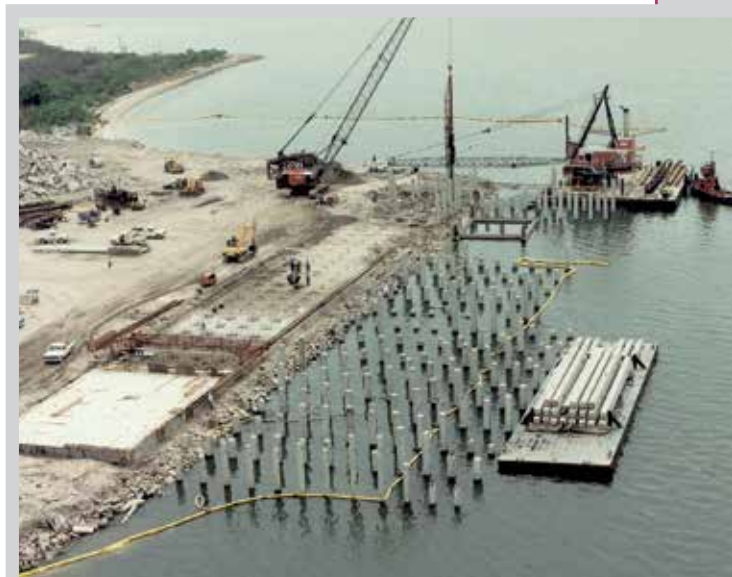
Montaż strunobetonowych pali (fot. Wikipedia)
