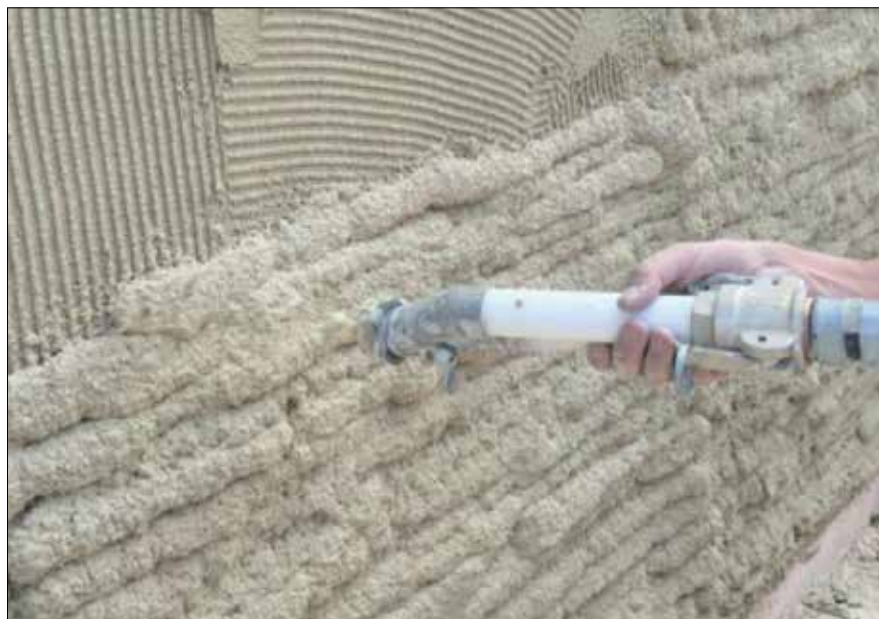
Fot. 5. Tynk na bazie aerożelu – aplikacja [13]
