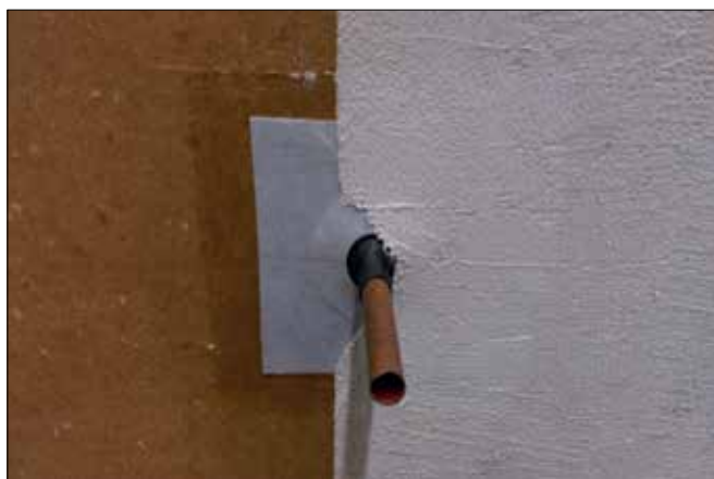
Fot. 9. Zastosowanie izolacji paroszczelnej w miejscu przebicia docieplenia
