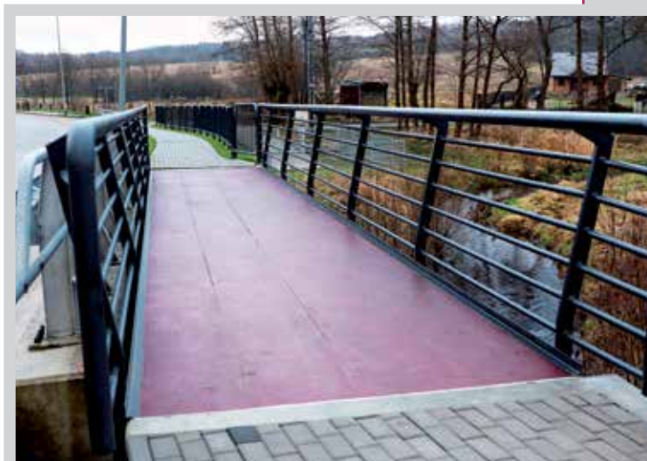
Kładka z samonośnym pomostem kompozytowym (fot. S. Lewandowski)
