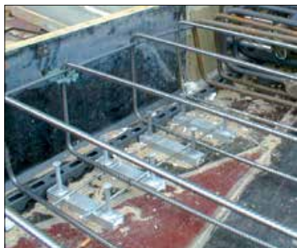
Fot. 1. Wbudowanie szyn kotwiących w deskowanie
