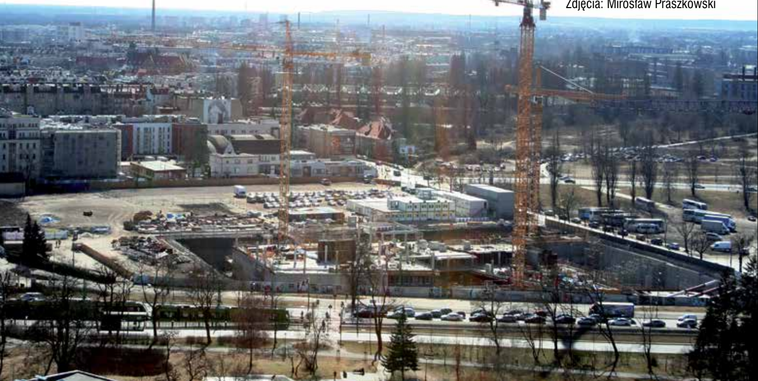
Plac budowy Nowego Rynku – widok z XVII piętra wieżowca UEP
