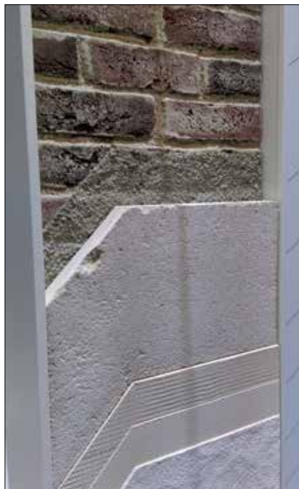
Fot. 4. Tynk na bazie aerożelu (układ poszczególnych warstw: podkład, tynk termoizolacyjny, warstwa gruntująca, zaprawa specjalna, warstwa wykończeniowa)
