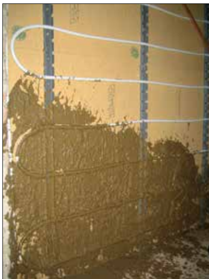
Fot. 2. Docieplenie od wewnątrz z wełny drzewnej z ogrzewaniem ściennym [11]
