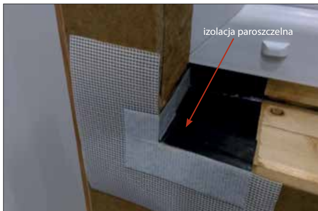
Fot. 11, 12. Zastosowanie izolacji paroszczelnej w obrębie połączenia docieplanej ściany i okna
