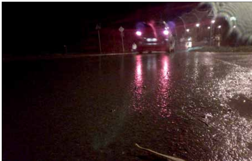
Fot. 1. Nawierzchnia z asfaltu porowatego
