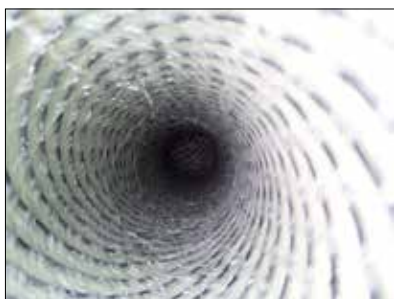
Fot. 2 | Rękaw IHC™ podczas procesu jego instalacji
