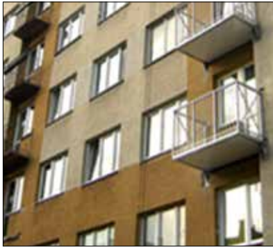
Fot. 10 | Efekt wymiany balkonów wspornikowych (po lewej stronie) na balkony dostawne (po prawej stronie) (fot. M. Mochnacki)
