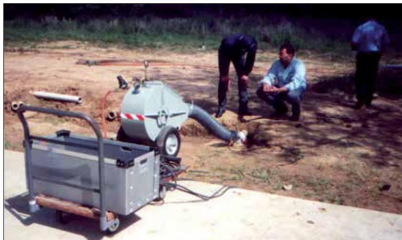
Fot. 3 | Plac budowy podczas procesu instalacji rękawa IHC™
