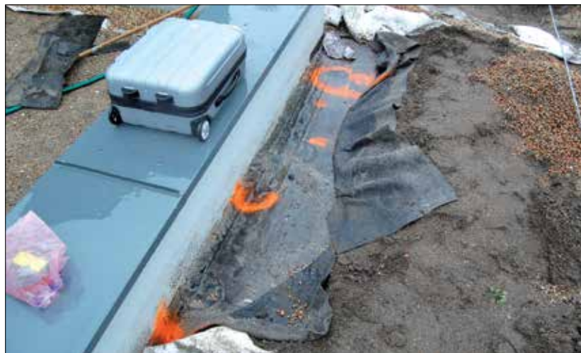
Fot. 3 | Poszukiwanie przecieku na dachu zielonym
