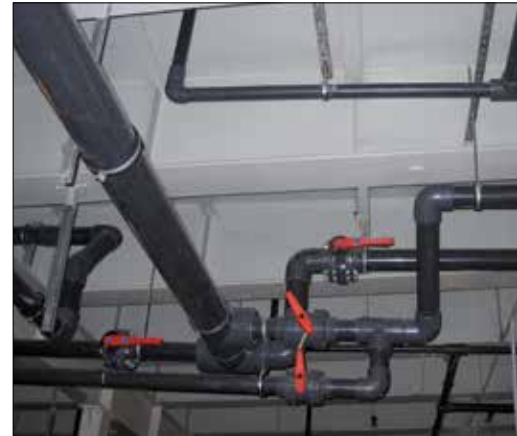
Fot. 9 | Cyrkulacja pionowa w basenie o konstrukcji stalowej po remoncie
