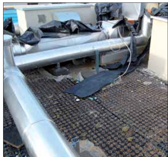
Fot. 4 | Wykonanie dachu zielonego oraz innych robót budowlanych i instalacyjnych
