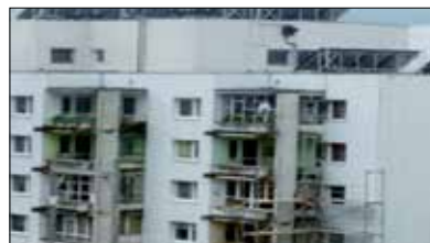
Fot. 8 | Budynek zrealizowany w systemie Wk-70. Widok dużych balkonów przed modernizacją (fot. autorka)
