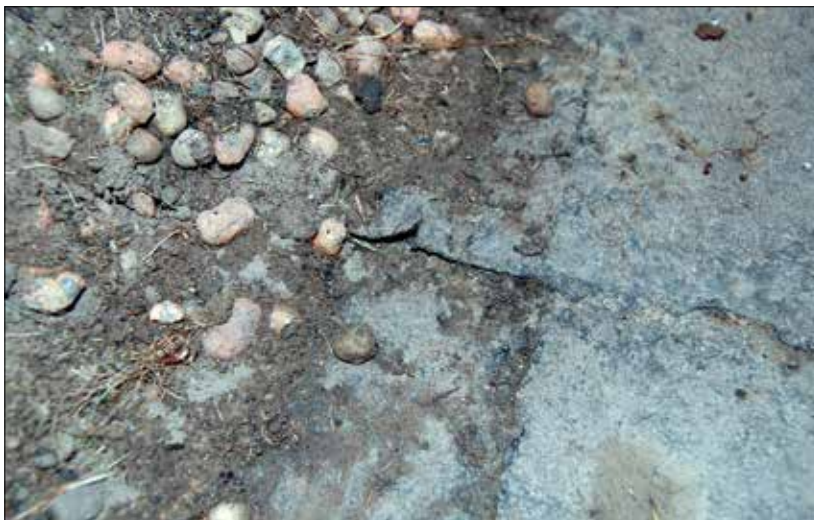
Fot. 1 | Papa zdegradowana przez kwasy humusowe
