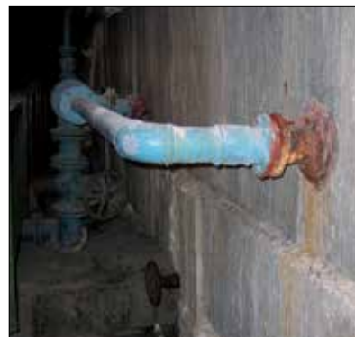
Fot. 6 | Przykład instalacji cyrkulacji wody basenowej przed remontem
