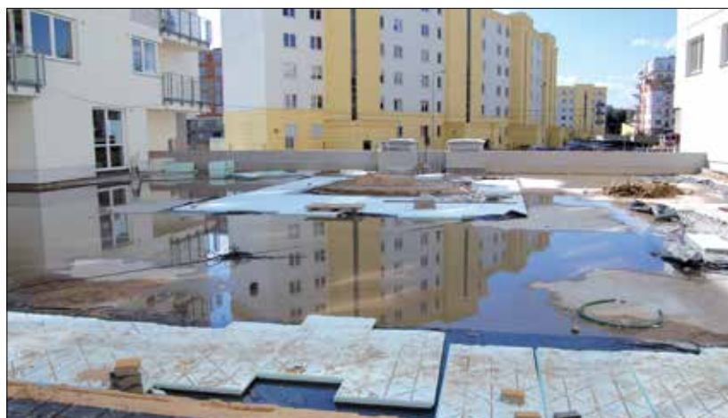
Fot. 5 | Przygotowanie do układania termoizolacji
