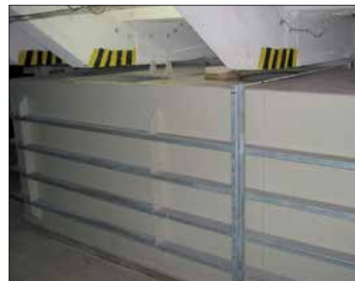
Fot. 10 | Zbiornik przelewowy z PP w podbaseniu po remoncie
