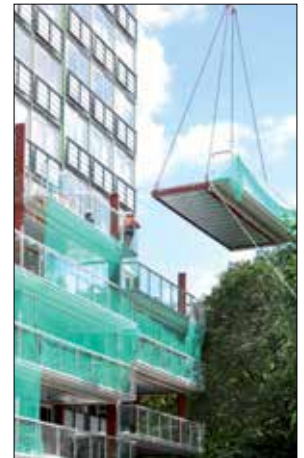
Sposób montażu dostawianego segmentu podczas realizacji metamorfozy [2]
