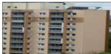
Fot. 9 | Budynek zrealizowany w systemie Wk-70. Widok dużych balkonów po modernizacji (fot. autorka)
