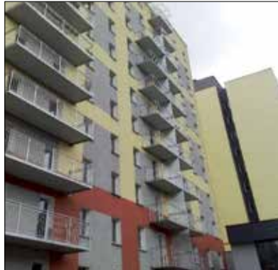
Fot. 11 | Ocieplony budynek wielorodzinny przygotowany do montażu balkonu dostawnego [4]
