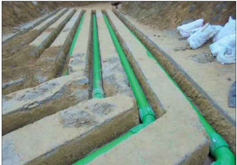
Fot. 2 | Ułożone przewody GPWC, grudzień 2016 r. (fot. Ecoplastol)
