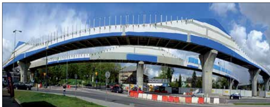
Fot. 3. Estakada ES-2 (Kraków-Zabłocie)
