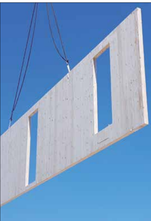
Fot. 2. Gotowa ściana z drewna klejonego krzyżowo (CLT)
