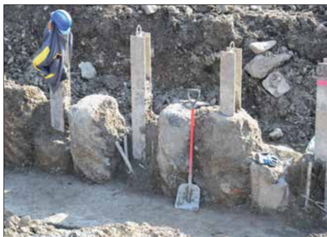
Fot. 2. Palisada z pali wciętych zabezpieczająca przed napływem wody
