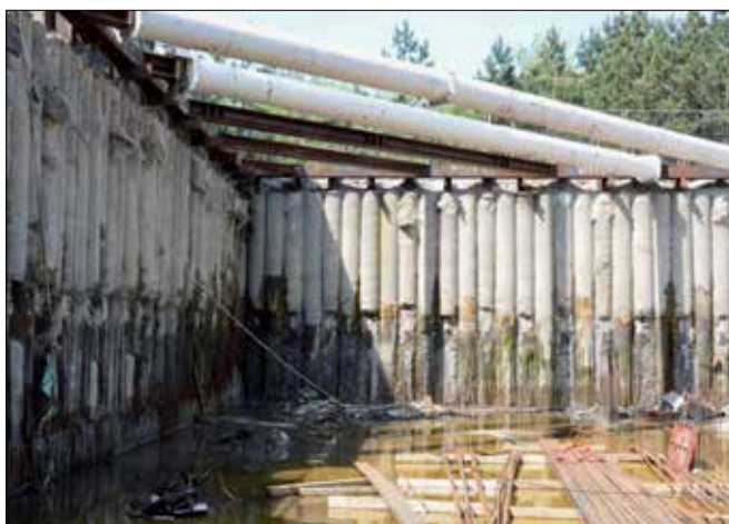
Fot. 1. Palisada zabezpieczająca wykop
