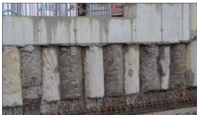
Fot. 6 Przykład palisady wykonanej z różnych elementów – pierwotne to kolumny DSM, a wtórne to pale CFA zbrojone
