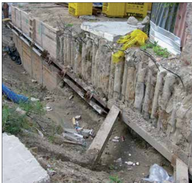
Fot. 11. Palisada z mikropali stanowiących zabezpieczenie wykonywanego wykopu
