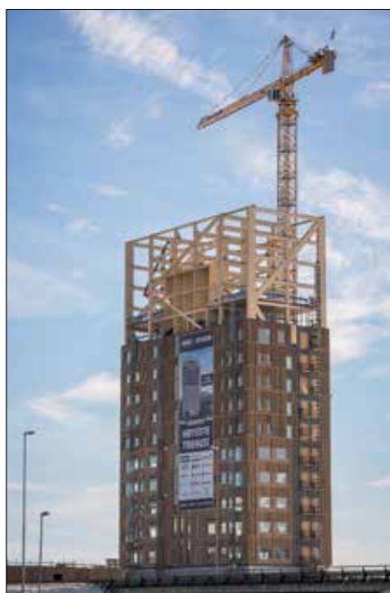
Fot. 6 i 7. Mjøstårnet w trakcie budowy
