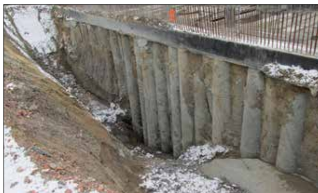
Fot. 5 Palisada wcięta z pali CFA (w centralnej części wykopu) – widoczne pale pierwotne wykonane pionowo i pale wtórne odchylone od pionu
