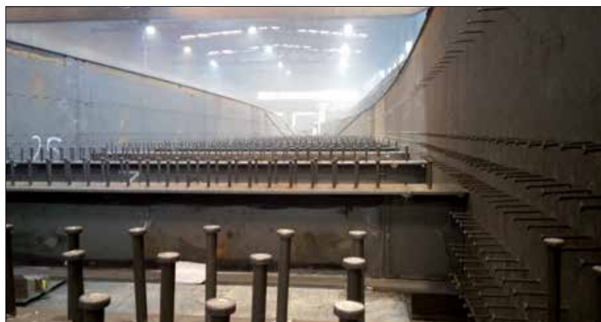
Fot. 4. Próbnny montaż estakady ES-2b – przeszło 8 i 9
