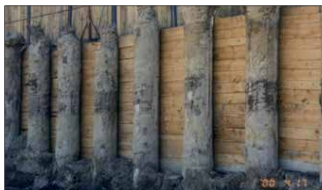
Fot. 7 Palisada z pali rozsuniętych, przestrzeń między palami wypełniona opinką drewnianą
