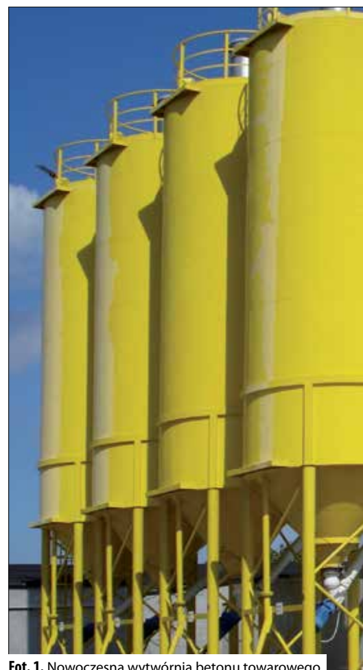
Fot. 1. Nowoczesna wytwórnia betonu towarowego
