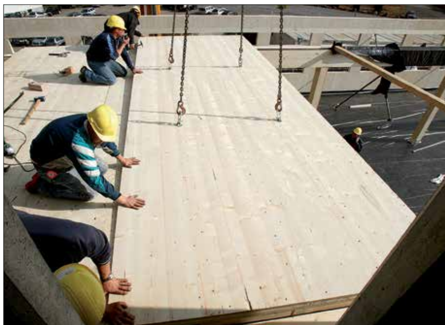
Fot. 3. Strop z drewna klejonego krzyżowo (CLT)
