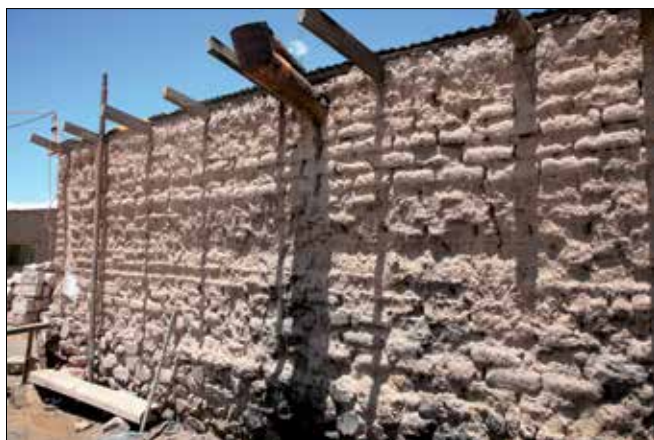
Fot. 2. Mur domu z bloków solnych
