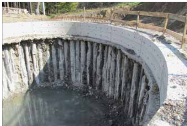
Fot. 9. Palisada stanowiąca zabezpieczenie wykopu fundamentu obiektu mostowego
