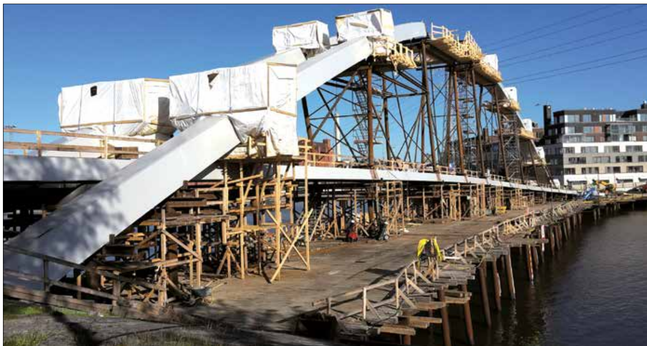
Fot. 2. Montaż konstrukcji stalowej wraz z konstrukcją tymczasową
