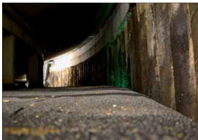
Fot. 10. Palisada o kształcie łukowym stanowiąca zabezpieczenie zbocza górskiego
