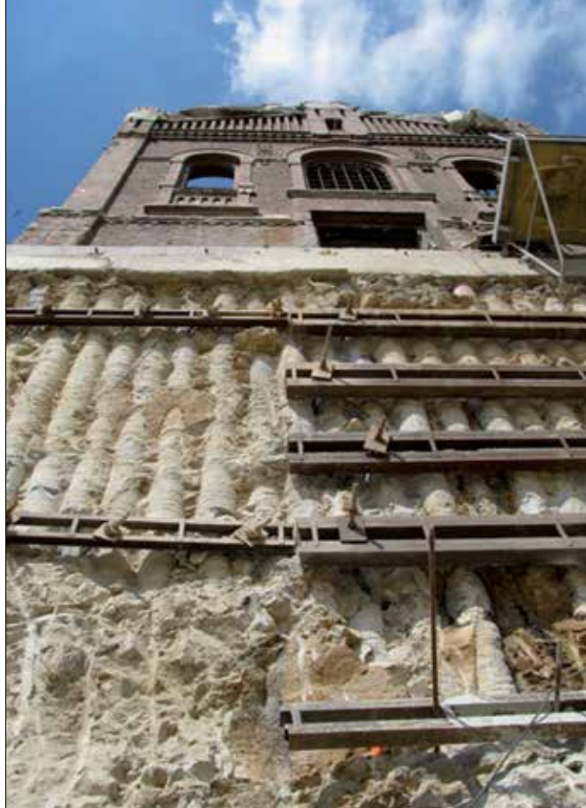
Fot. 12. Palisada zabezpieczająca głęboki wykop z istniejącym na naziemiu zabytkowym budynkiem
