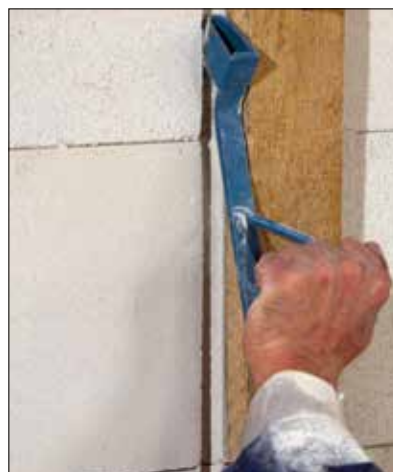
Fot. 2 | Wykonanie bruzdy rylcem (fot. T. Rybarczyk)
