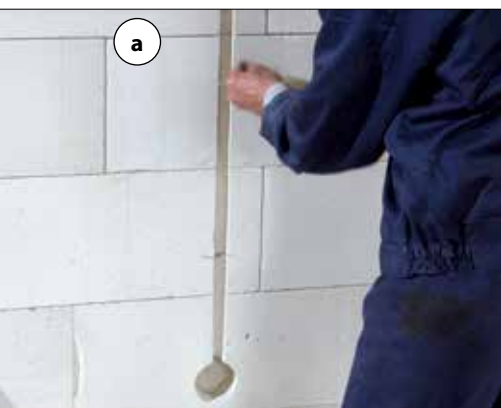
Fot. 1 | Przykład: a) bruzdy, b) wnęki (fot. T. Rybarczyk)
