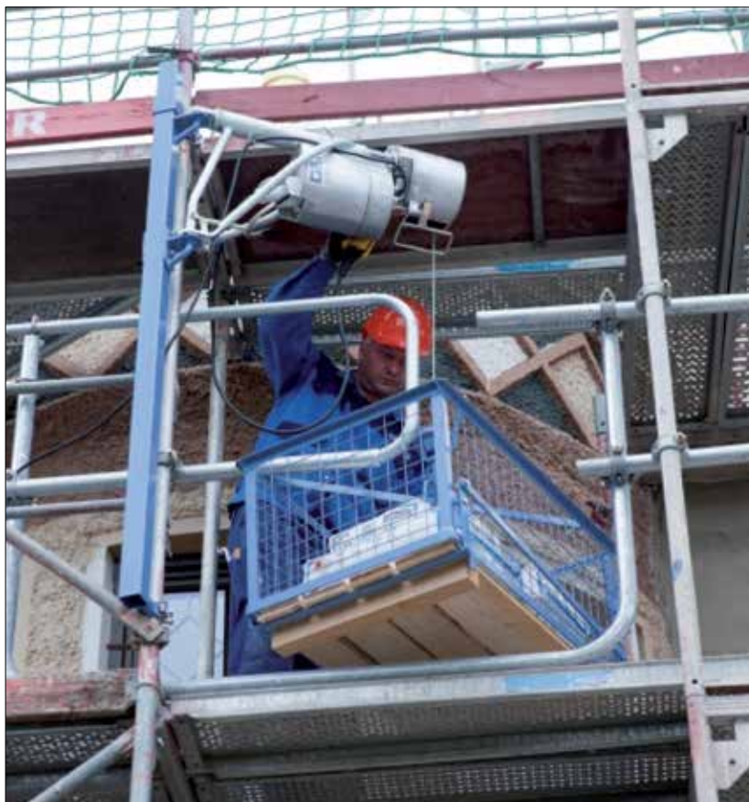
Fot. 2 | Zabezpieczenie przestrzeni roboczej za pomocą poręczy rozsuwanych
