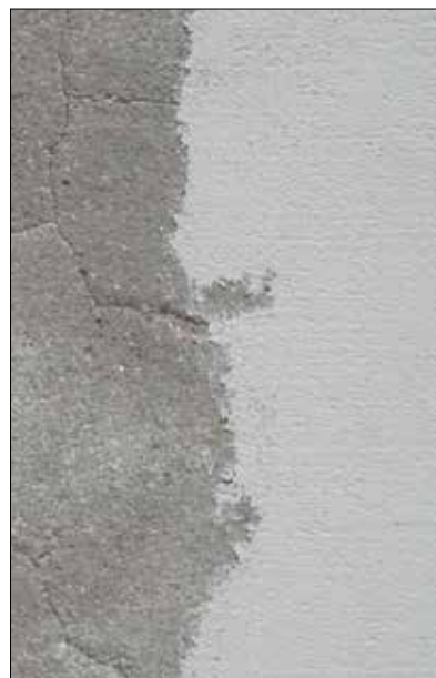
Fot. 4 | Przekrycie rys skurczowych, przykład zastosowania tynku cienkowarstwowego zbrojonego mikrowłóknami
