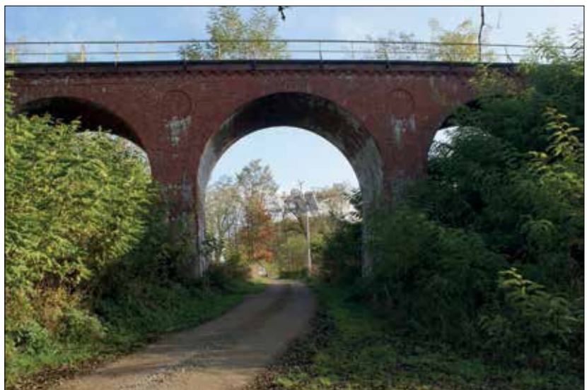
Fot. 1 | Widok ogólny wiaduktu w km 20,9 linii kolejowej nr 368
