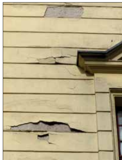
Fot. 3 | Niewłaściwie dobrana warstwa tynku końcowego; zbyt duży skurcz, niska dyfuzyjność i za duża grubość wywołały całkowite odparzenie
