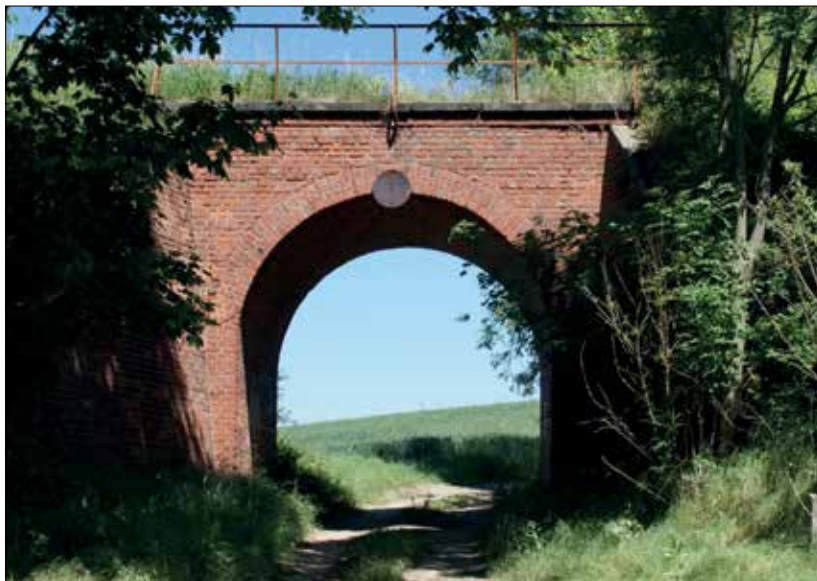
Fot. 5 | Widok ogólny wiaduktu sklepionego w km 28,9
