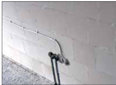
Fot. 4 | Nieuwzględniona w obliczeniach bruzda w ścianie wypełniającej o grubości 80 mm (fot. Ł. Drobiec)
