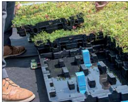
Fot. 2 | Moduły HydroVentiv® gromadzące wodę (źródło: www.vegetalid.com)
