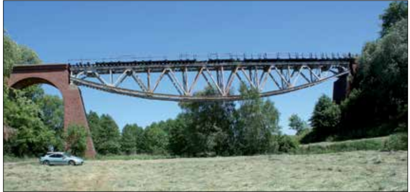
Fot. 3 | Środkowe przęsło mostu na linii 368 w okolicy miejscowości Chrzypsko Wielkie
