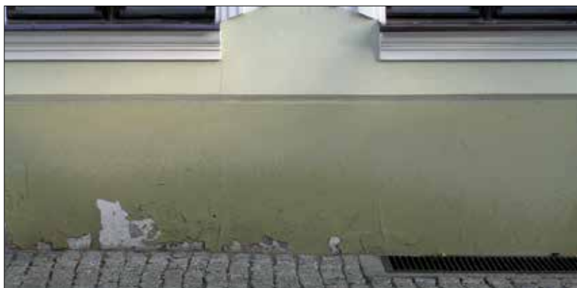
Fot. 6 | Farba mineralna zastosowana na cokole – niewystarczająca odporność na wody opadowe spowodowała jej złuszczenia
