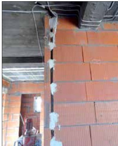
Fot. 5 | Nieuwzględniona w obliczeniach pionowa bruzda przy otworze (fot. Ł. Drobiec)
