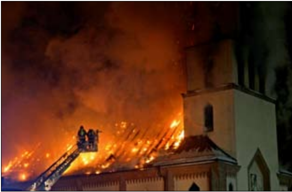
Fot. 3 | Pożar poddasza i dachu kościoła (fot. Bartłomiej Karczewski)
