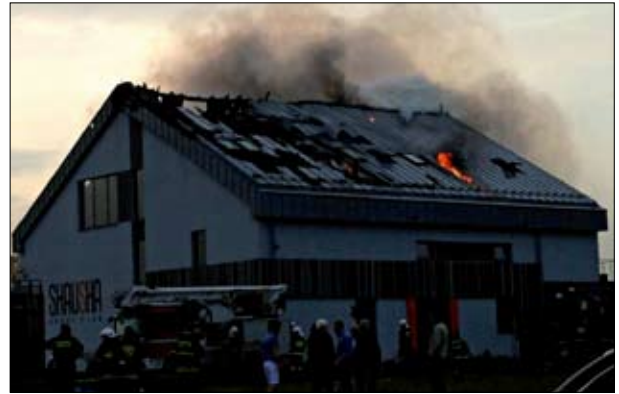
Fot. 4 | Pożar poddasza i dachu budynku klubu fitness (fot. OSP Łubie)
