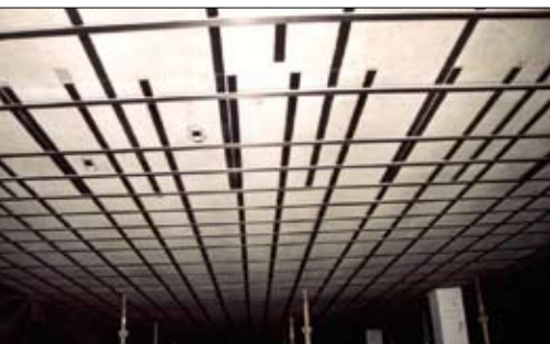
Fot. 1 | Bierne wzmocnienie płyty żelbetowej taśmami CFRP
