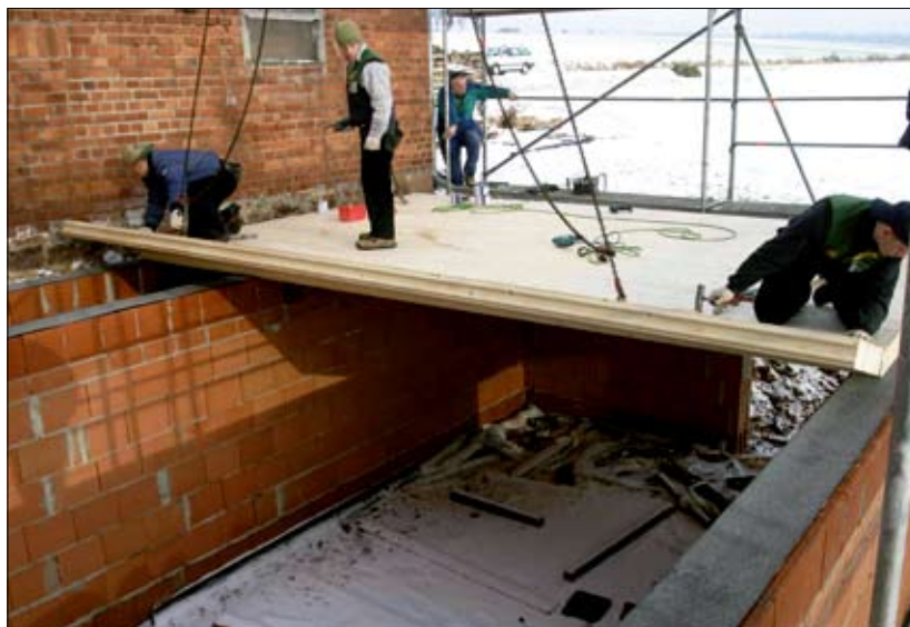
Fot. 1 | Montaż stropu
