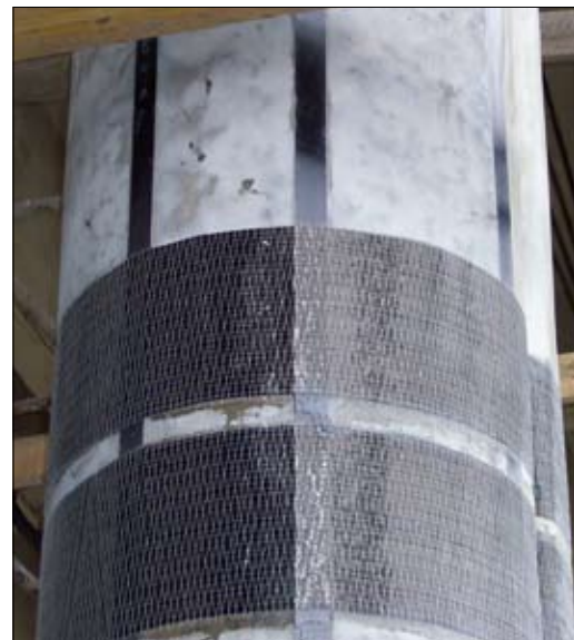
Fot. 4 | Wzmocnienie słupa żelbetowego taśmą CFRP (układ pionowy) i matą CFRP
