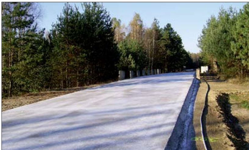
Trzebinia, ul. Leśna, fragment dojazdu do kopalni piasku; długość 400 m, realizacja 2014 r.
