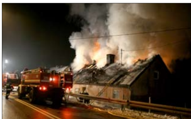
Fot. 1 | Pożar poddasza i dachu budynku jednorodzinnego (fot. Zbigniew Woźniak)
