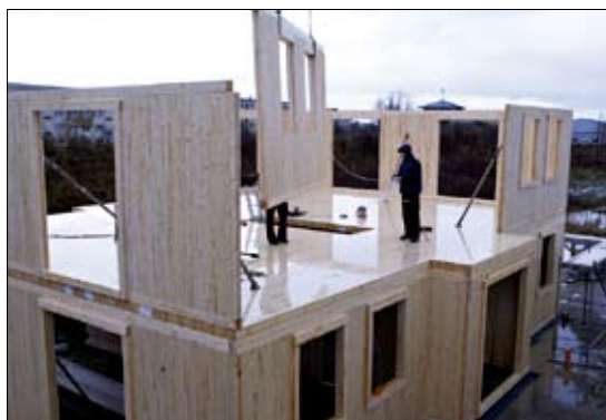
Fot. 4 | Budowa domu z elementów z drewna klejonego
