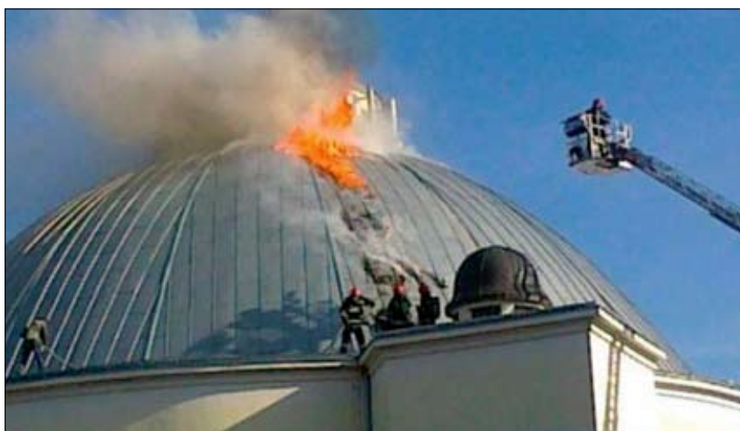
Fot. 8 | Pożar konstrukcji dachu kościoła z niepalnym pokryciem (fot. Lech Kamiński)
