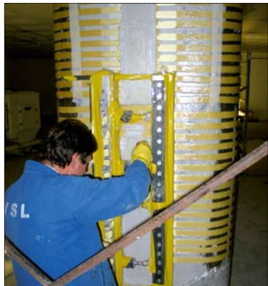
Fot. 6 | Sprężenie słupa żelbetowego wstęgami aramidowymi (AFRP)
