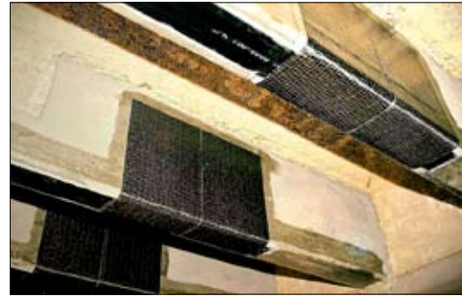
Fot. 3 | Bierne wzmocnienie belek żelbetowych przy użyciu taśm CFRP zakotwionych matą CFRP
