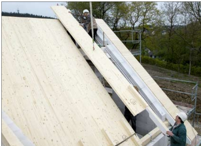
Fot. 2 | Montaż dachu
