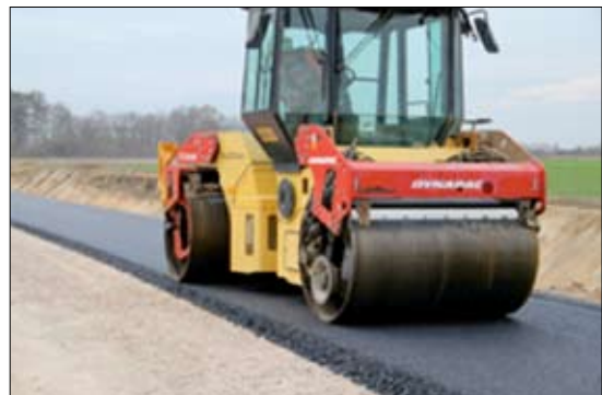
Fot. 1 Odcinek testowy (fot. Budimex S.A.)
