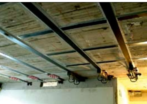
Fot. 5 | Czynne wzmocnienie żelbetowego stropu (widok biernych i czynnych zakotwień)
