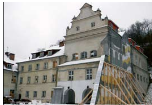
Fot. 4 | Skrzydło wschodnie zostało rozebrane przez gminę Kazimierz Dolny, wykonano również zabezpieczenie przypory ściany korpusu głównego
