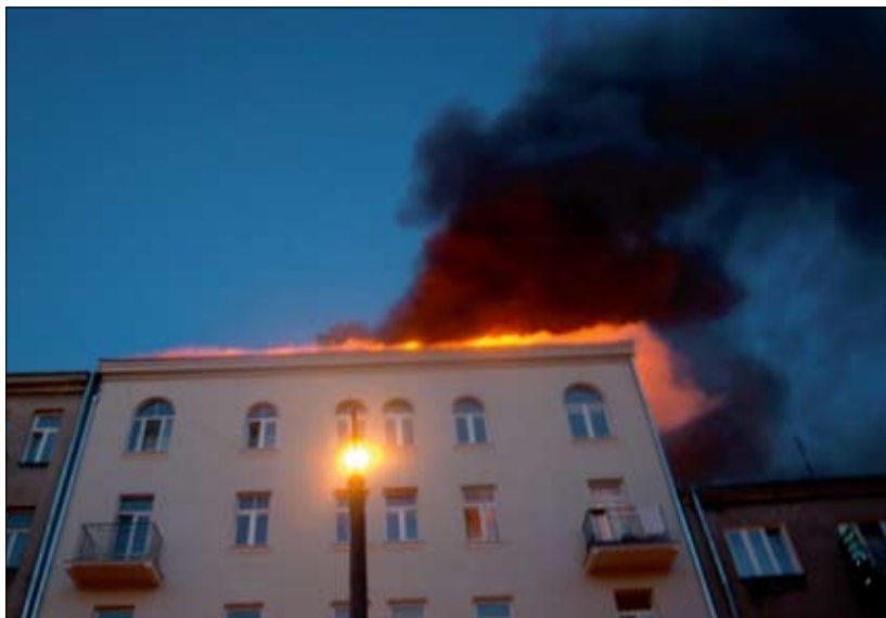
Fot. 7 | Pożar palnego pokrycia dachu kamienicy (fot. TVN Warszawa)
