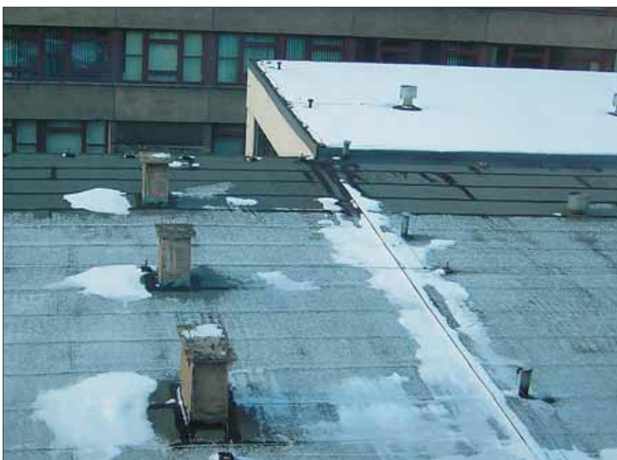
Fot. 2. Zróżnicowane grubości warstwy zalegającego śniegu, w wyniku różnej izolacyjności dachów i ich innej ekspozycji na promieniowanie słoneczne
