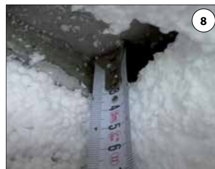
Fot. 5–8. Nieciągłość termoizolacji będąca główną przyczyną zawilgocenia, fot. 5 i 6 w ociepleniu na płycie, fot. 7 i 8 w ociepleniu od spodu; opis w tekście
