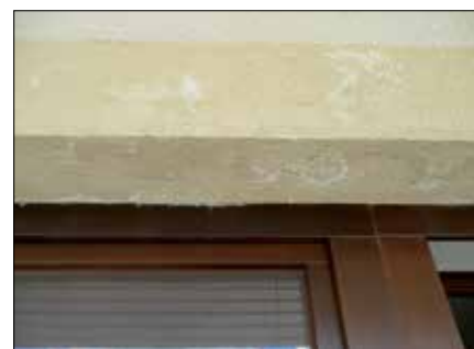
Fot. 1–3. Ościeża okien i drzwi balkonowych w bloku mieszkalnym (pod balkonami) z widocznymi zawilgoceniami i skroplinami
