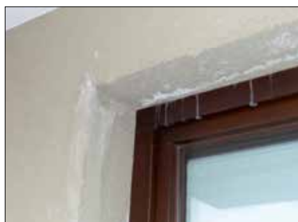
Fot. 1–3. Ościeża okien i drzwi balkonowych w bloku mieszkalnym (pod balkonami) z widocznymi zawilgoceniami i skroplinami
