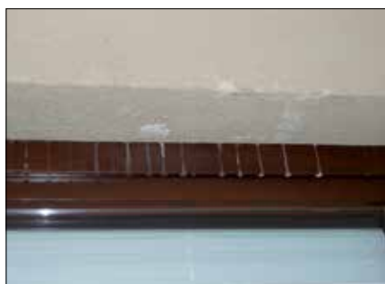
Fot. 1–3. Ościeża okien i drzwi balkonowych w bloku mieszkalnym (pod balkonami) z widocznymi zawilgoceniami i skroplinami
