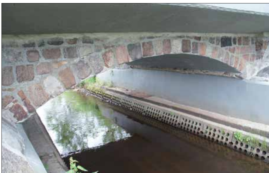
Fot. 1. Przykład wzmocnienia i renowacji przepustu drogowego z wykorzystaniem chemii budowlanej w postaci zapraw i wypraw niskoskurczowych (fot. autora)
