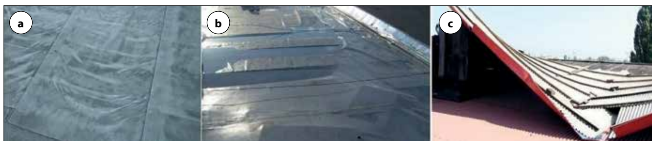
Fot. 1. Przykłady uszkodzeń pokryć dachowych, związane z niewłaściwym mocowaniem ich do podłoża: a) pokrycie papowe, b) membrana PVC, c) pokrycie z blachy (falistej, powlekanej) [1]
