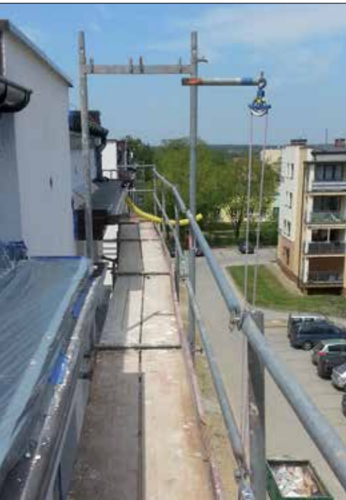
Fot. 9. Wysięgnik transportowy mocowany jednopunktowo do ramy niezakotwionej w ścianie [9]
