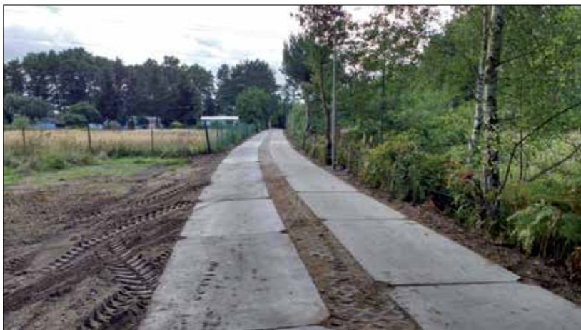
Fot. 2 | Widok wykonanej nawierzchni
