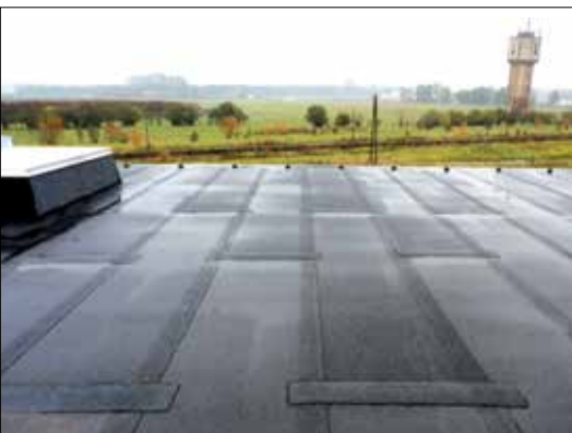
Nakładki zgrzane w miejscach potencjalnej nieszczelności
