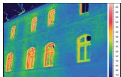
Rys. 2 | Pomiar termowizyjny ściany zewnętrznej budynku zabytkowego z ociepleniem od strony wewnętrznej
