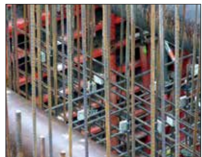
Fot. 2 | Protektory zamontowane w konstrukcji metodą bezpośrednią
