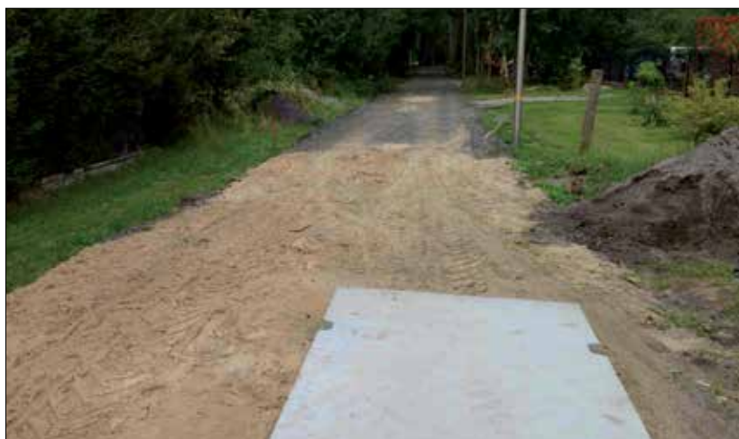
Fot. 5 | Droga przygotowana do ułożenia płyt, z przodu widoczna podsypka piaskowa, dalej podbudowa
