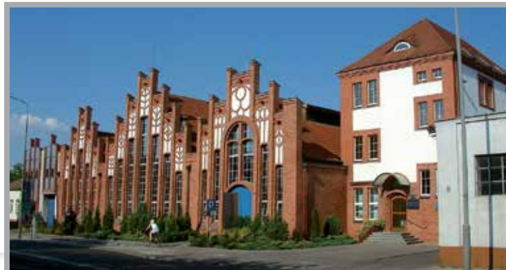
Stacja pomp przy ul. Garbary (fot. Radomil/Wikipedia)
