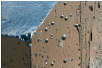
Fot. 13, 14 | Pęcherze osmotyczne będące rezultatem ułożenia masy KMB na zbyt wilgotnym lub mokrym podłożu (fot. Izohan)
