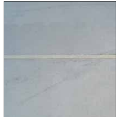
Fot. 9 | Widok bezfazowej dylatacji posadzki przemysłowej (zabezpieczonej materiałem elastycznym)
