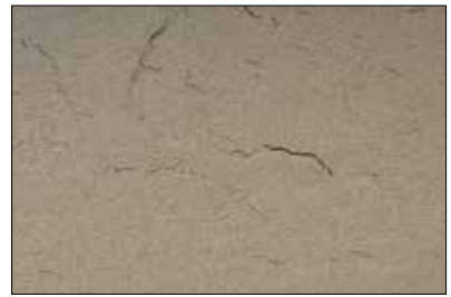
Fot. 17 | Rysy na powierzchni szlamu mogą mieć dwie przyczyny; opis w tekście (fot. autor)
