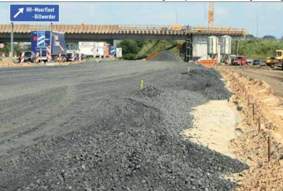
Fot. 3 | Podbudowa drogi z kruszywa żelazowo-krzemowego (Hamburg)
