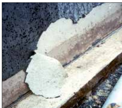
Fot. 7, 8 | Skutki położenia masy KMB na źle przygotowanym podłożu; opis w tekście (fot. Weber-Deitermann)
