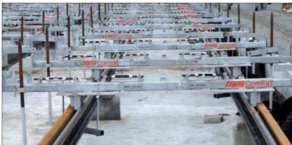
Fot. 1 | Szyny w profilach elastomerowych systemu RCS podwieszane na bramkach montażowych
