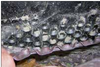
Fot. 15 | Skutek zbyt wczesnego przyłożenia ochronnej folii kubelkowej do masy KMB. Tego typu efekt powstanie także przy ułożeniu folii kubelkowej bez specjalnej warstwy poślizgowej na związanej masie KMB (fot. autor)
