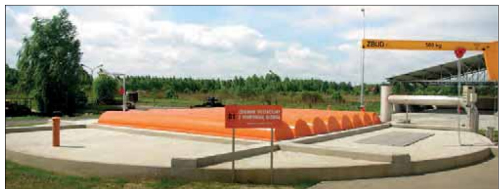
Fot. 1 | Zbiornik retencyjny z pompownią główną (dzięki uprzejmości mgr. inż. T. Pośpiecha)
