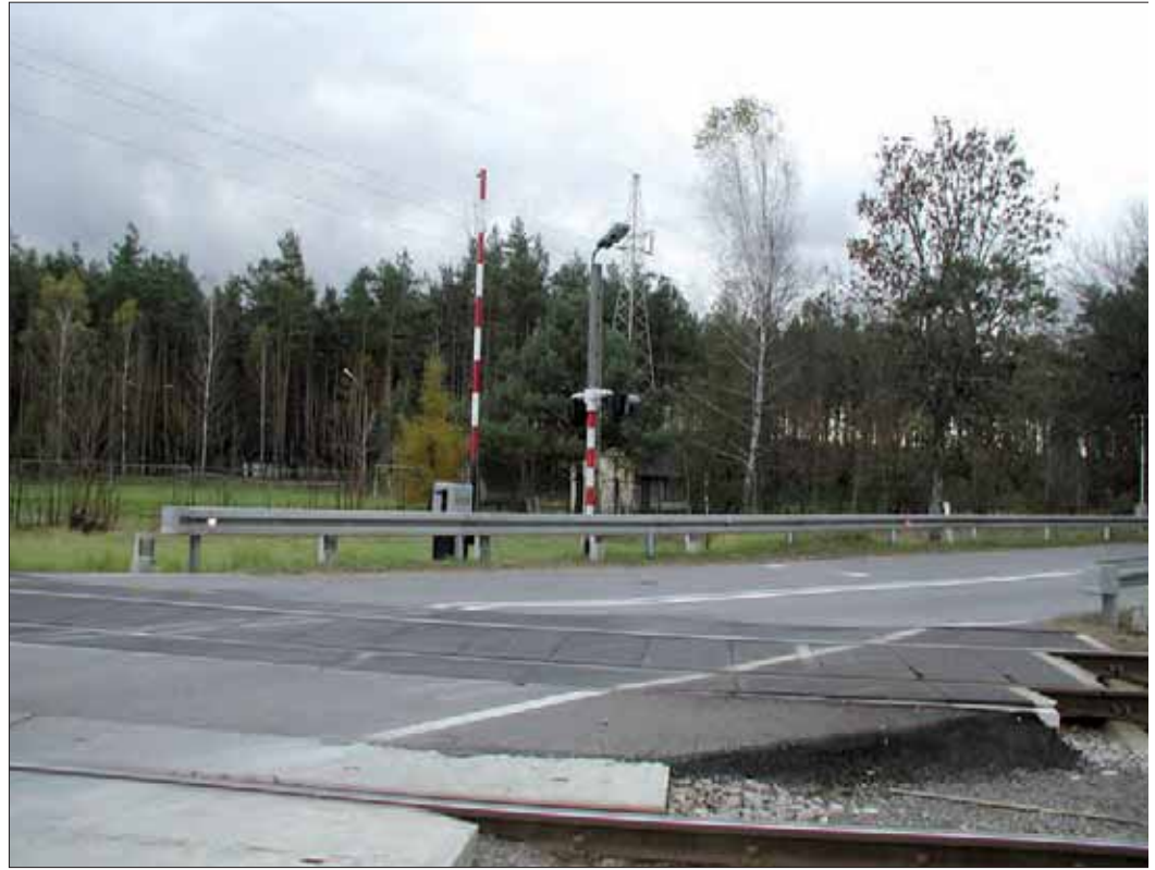
Fot. 4 | Przejazd kategorii B z półrogatką i sygnalizacją świetlną, w jednym torze nawierzchnia elastomero-wa, w drugim – nawierzchnia z betonowych płyt wielkogabarytowych typu CBP (fot. autorki)
