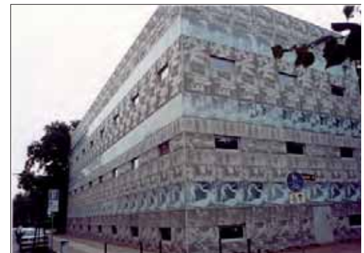
Fot. 1 | Fotobeton na elewacji biblioteki Wyższej Szkoły Technicznej w Eberswalde (fot. autor)
