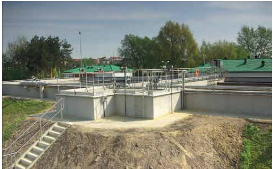
Fot. 2 | Reaktory Nereda (dzięki uprzejmości mgr. inż. T. Pośpiecha)
