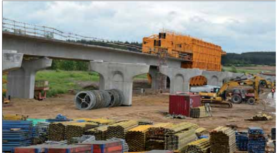
Fot. 3 | Widok „eleganckiego” placu budowy, który w czasie wykonywania fundamentów podobny był do bagna
