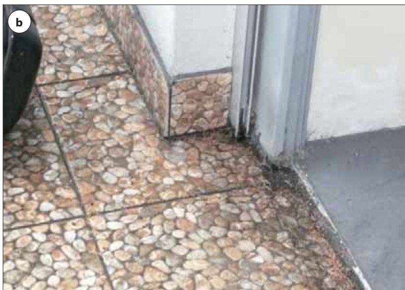
Fot. 1 | a) Balkon z obustronnie ocieplaną płytą oraz balustradą pełną również ocieplaną obustronnie. Zakamarki te może wyglądać ciekawie, natomiast dla takiego układu są praktycznie nie do uszczelnienia; b) pokazane umiejscowienie prowadnicy rolety i sposób jej mocowania może wręcz uniemożliwić poprawną hydroizolację połączi. Dodatkowo widoczne bezmyślne wykonanie przejścia bezbarierowego (fot. autor)
