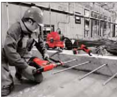
Fot. 2 | Wiercenie otworów metodą HDB
