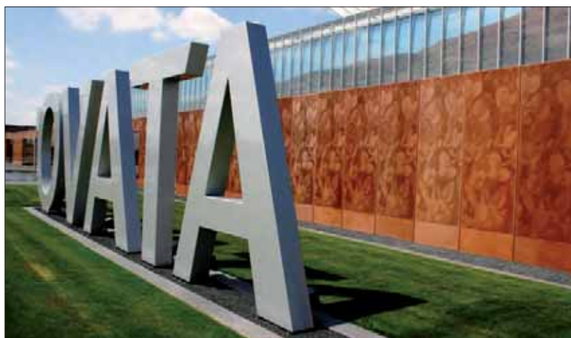
Fot. 7 | Prefabrykowane, barwione w masie płyty betonowe na murze hodowli kaktusów, Bleiswijk, Holandia [3]
