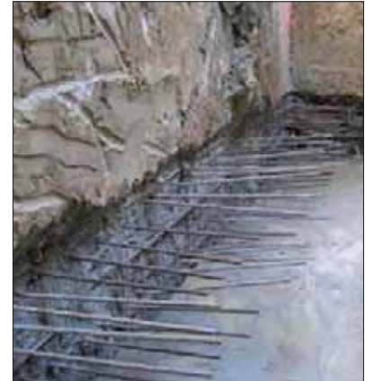
Fot. 5 | Wklejenie prętów pod ściankę szczelinową
