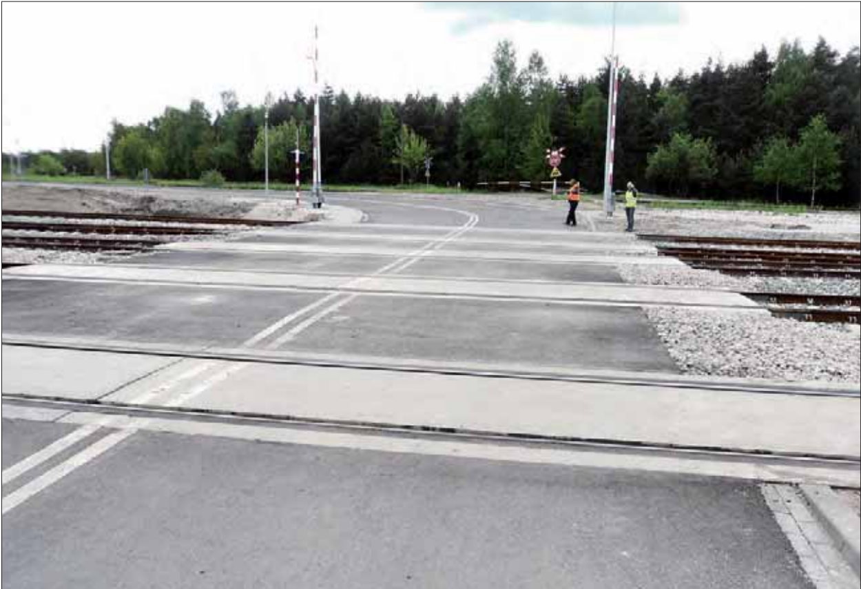
Fot. 5 | Euroterminal Sławków – terminal usytuowany na styku najdalej na zachód wysuniętego odcinka linii kolejowych o szerokim rozstawie toru (1520 mm) i linii funkcjonujących wg standardów europejskich (1435). (fot. archiwum TINES)
