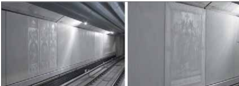
Fot. 5 | Stacja metra z panelami z fotobetonu, Nürnberg, Niemcy [3]
