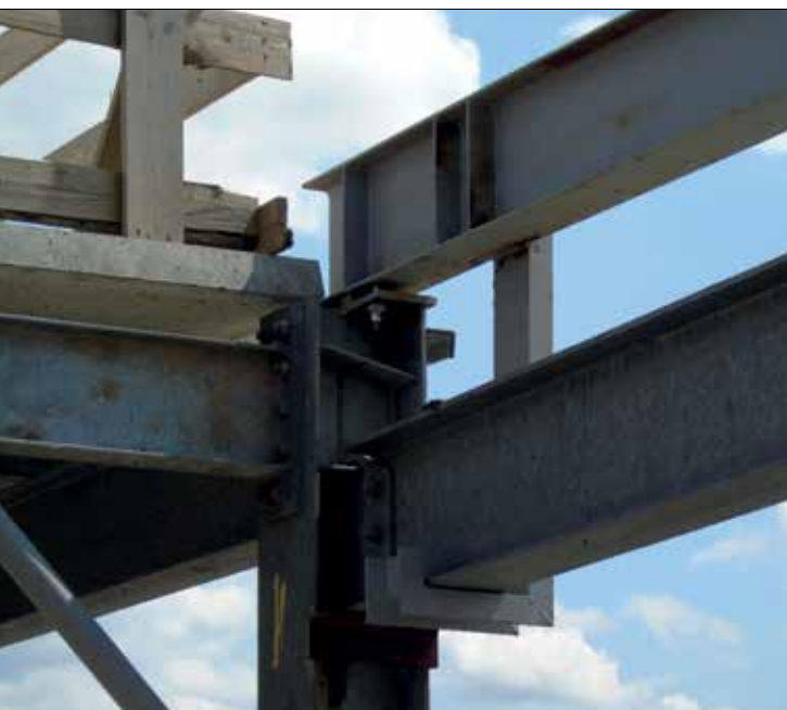
Fot. 8. Oberwana belka stropu (prowizorycznie podwieszona)
