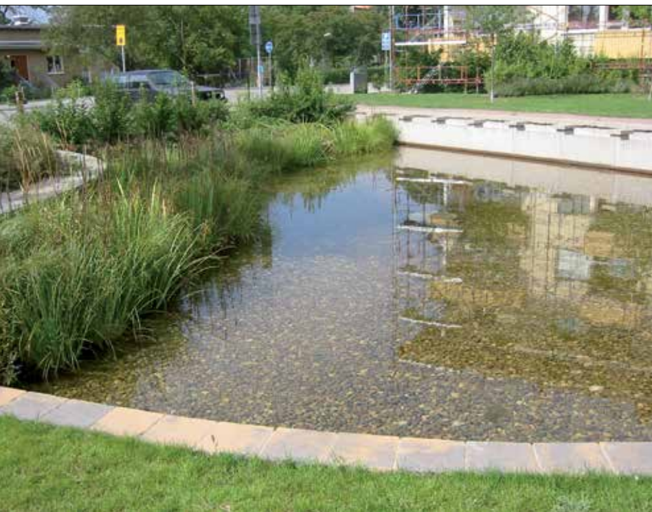
Fot. 1. Zbiornik wód opadowych ze stałym zwierciadłem wody (Malmoe)
