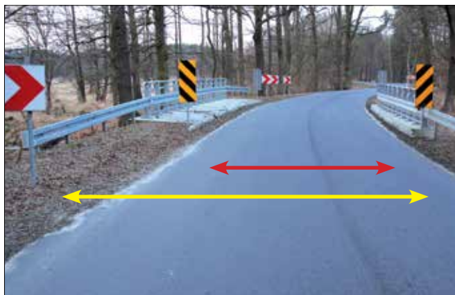
Fot. 5. Przykład poszerzenia obiektu z wykorzystaniem dodatkowych konstrukcji nośnych w technologii reliningu w celu umożliwienia wykonania ścieżki rowerowej (fot. A. Wysokowski)
