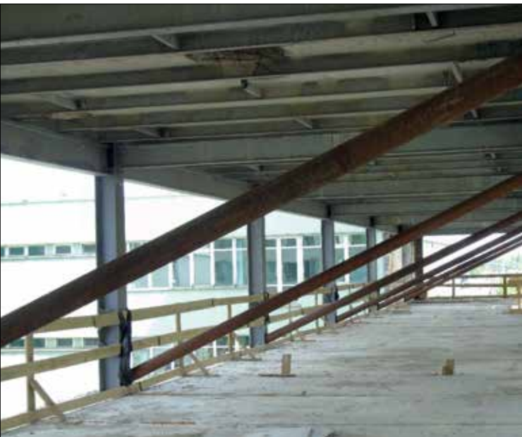
Fot. 10. Tymczasowe stężenia poprzeczne budynku
