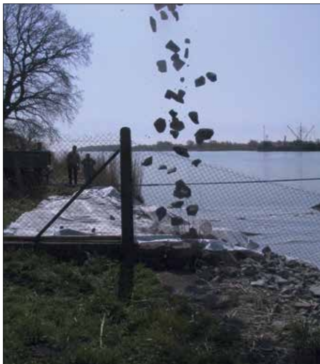
Fot. 12–13. Przykład nieprzestrzegania podstawowych zasad układania kamieni jako narzutu na skarpach odwodnych pokrytych geosyntetykami
