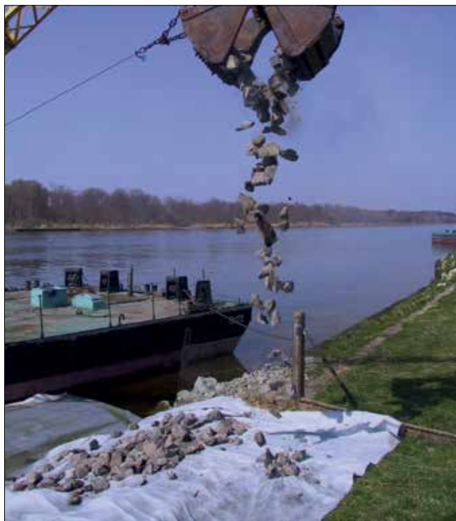
Fot. 12–13. Przykład nieprzestrzegania podstawowych zasad układania kamieni jako narzutu na skarpach odwodnych pokrytych geosyntetykami
