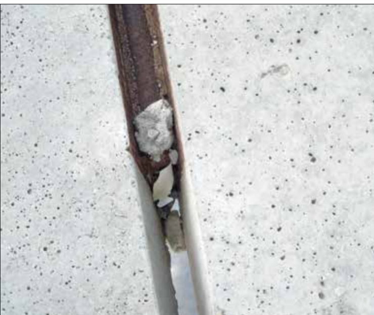
Fot. 4. Sposób „uciąglenia” płyt stropowych
