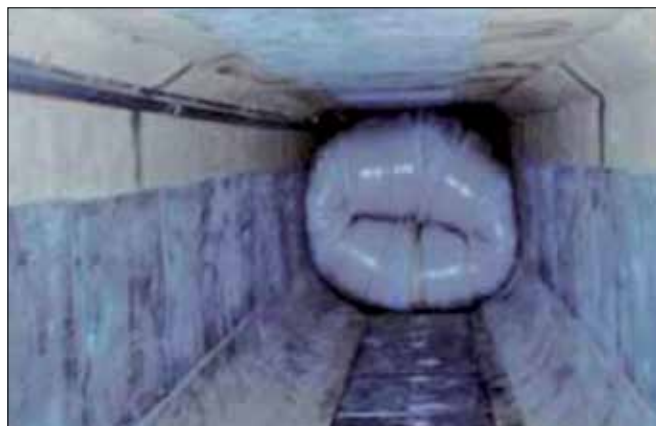
Fot. 6. Przykład renowacji przepustu metodą utwardzonego rękawa nasączonego żywicami poliestrowymi. Widok konstrukcji wzmacnianej na etapie wprowadzenia – wywinięcia – rękawa wzmacniającego [2]
