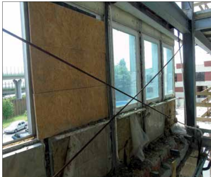
Fot. 11. Tymczasowe stężenia podłużne ścian zewnętrznych budynku
