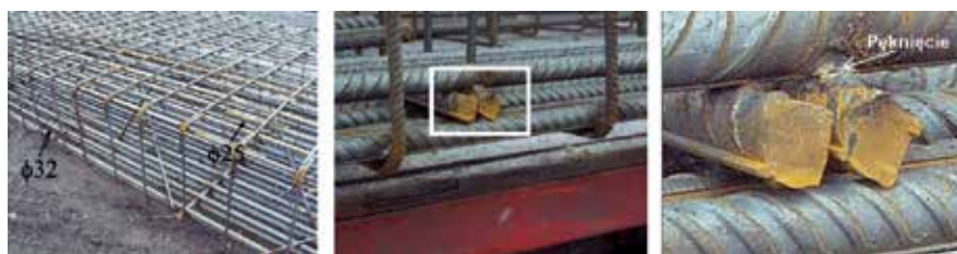
Fot. 3. Pęknięcia w zbrojeniu po przywiezieniu na plac budowy
