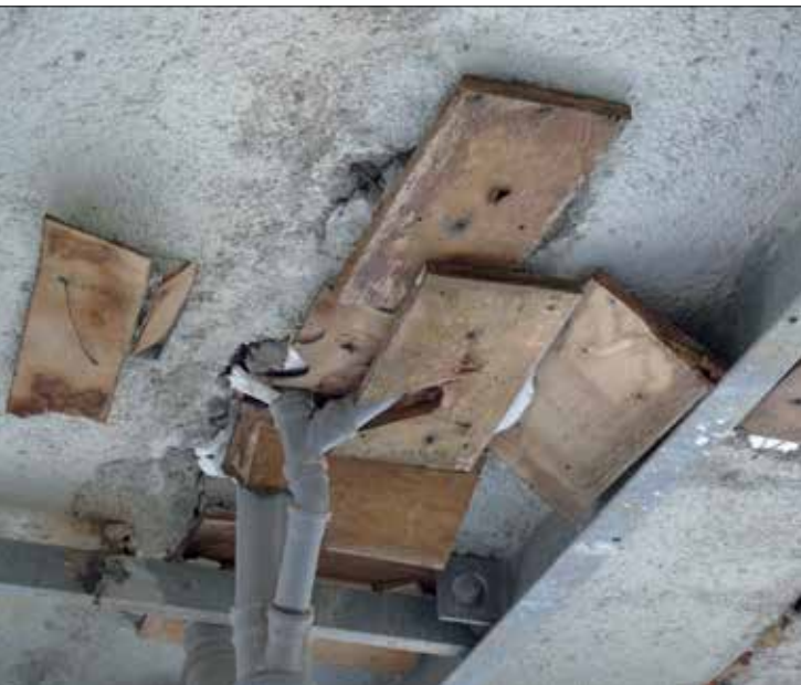
Fot. 6. Sposób wykonania szalunku traconego przy otworach w stropach
