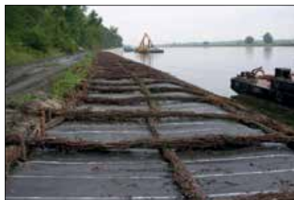
Fot. 4–7. Kolejne etapy zabudowy brzegów rzeki z filtrem geosyntetycznym, rusztem faszynowym i narzutem kamiennym
