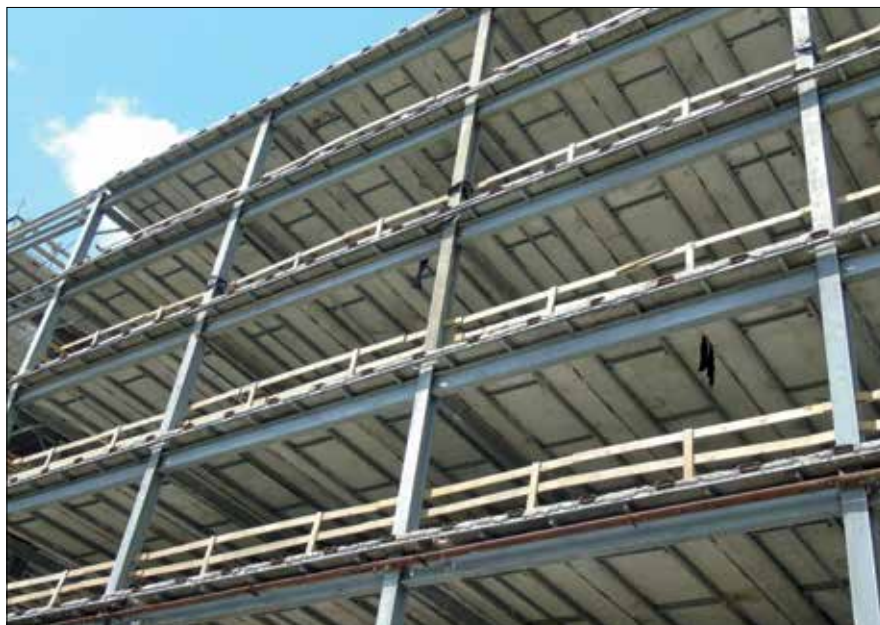
Fot. 1. Zalecany sposób przygotowania obiektu do rzetelnej oceny konstrukcji
