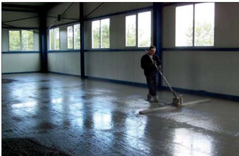
Fot. 3 | Ściąganie nadmiaru wody i mlecza cementowego przed aplikacją posypki
