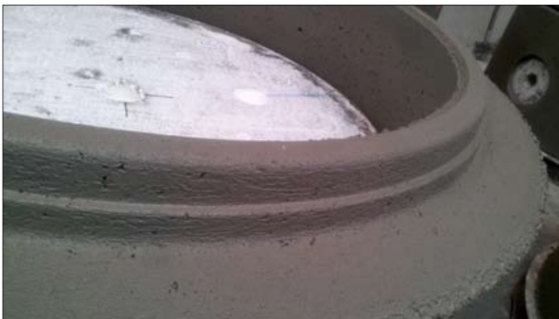
Fot. 6 | Powierzchnia betonu po bezpośrednim rozszalowaniu
