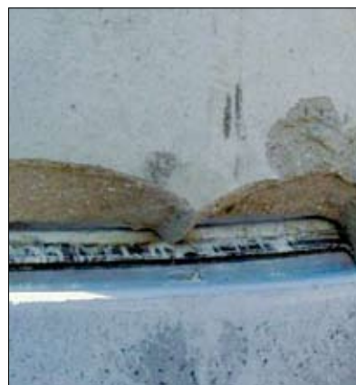
Fot. 2 | Zniszczenie dolnego zamka kręgu
