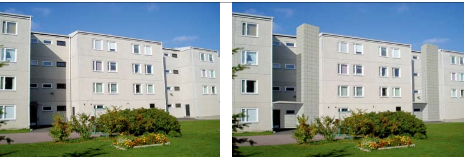
Fot. 1 | Budynek przed i po dobudowie dźwigu (zewnętrznego) w Finlandii
