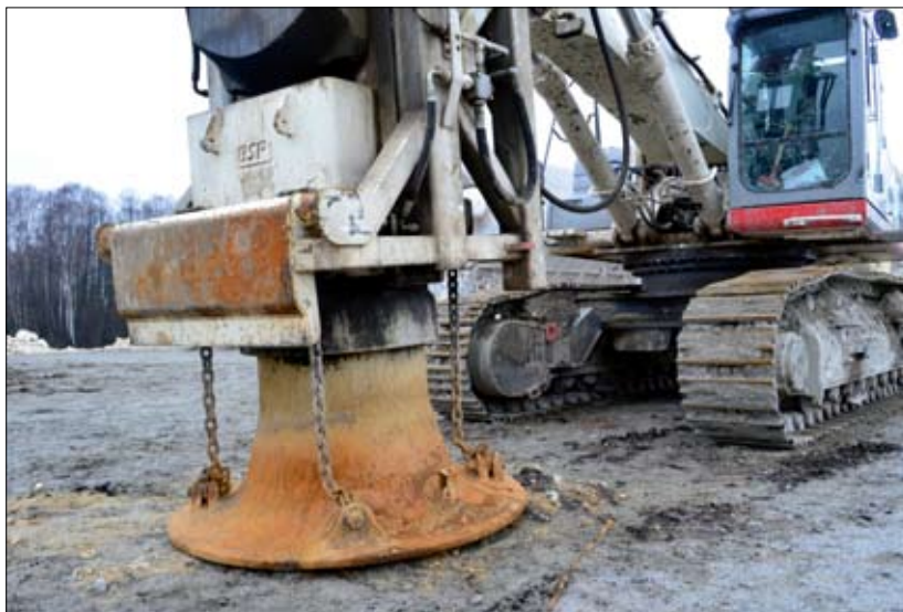
Fot. 4 | Maszyna do zagęszczania impulsowego
