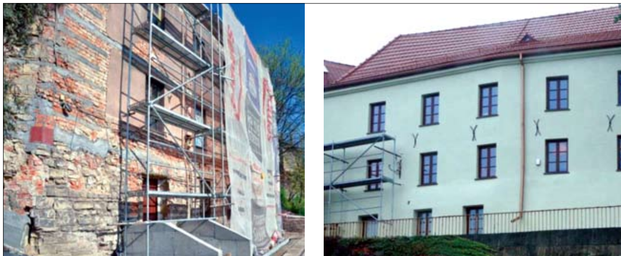
Fot. 8 | Zabytkowa kamienica poddana renowacji z zastosowaniem kompleksowego osuszania ścian
