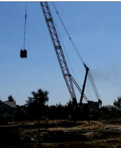
Fot. 3 | Ciężki bijak zrzucany z kilkunastu metrów w czasie wymiany dynamicznej w pobliżu budynków mieszkalnych
