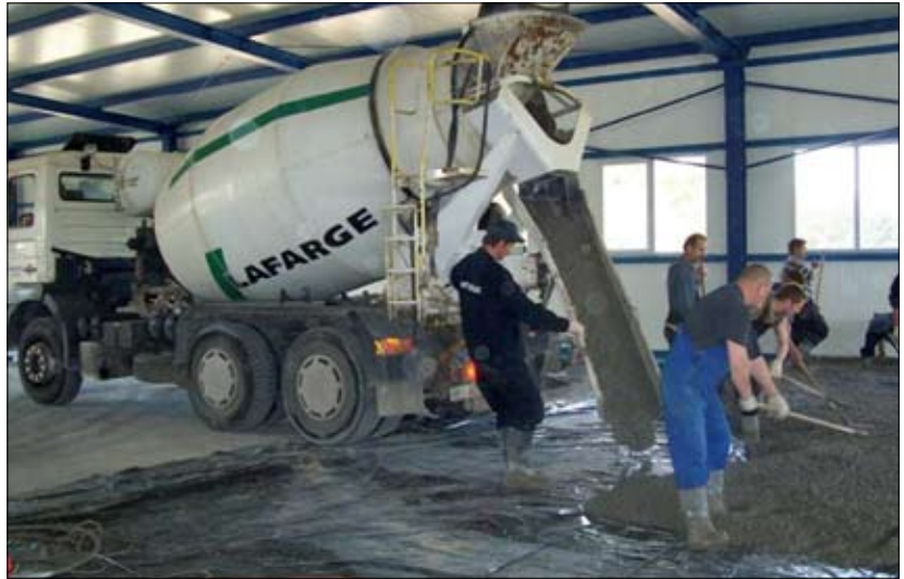
Fot. 2 | Rozściełanie mieszanki betonowej
