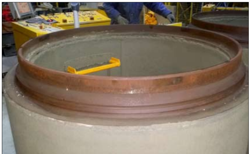
Fot. 4 | Górny pierścień stalowy na świeżo zaformowanym kręgu
