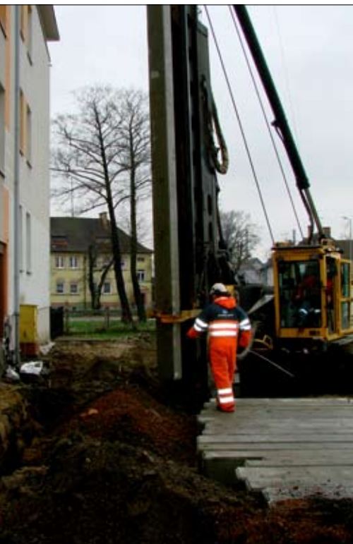
Fot. 2 | Kafar do wbijania pali prefabrykowanych w pobliżu ściany budynku szkoły (fot. archiwum firmy Aarsleff)
