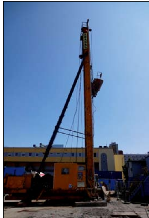
Fot. 1 | Maszyna do wykonywania pali Franki NG w pobliżu budynków (fot. archiwum firmy Franki SK)
