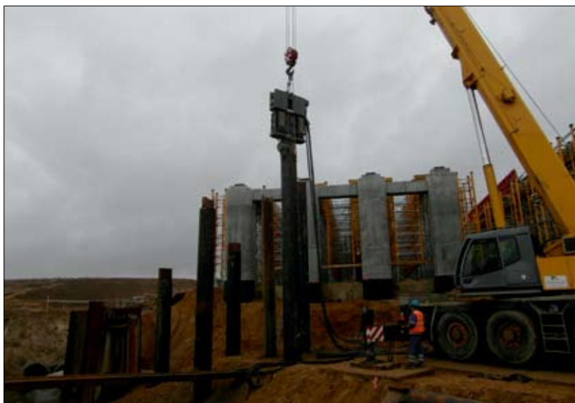
Fot. 5 | Wwibrowywanie rur stalowych w czasie budowy mostu
