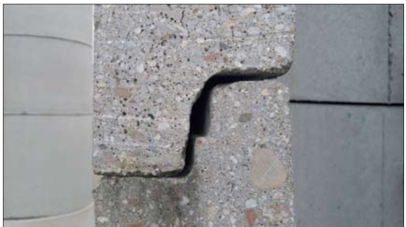
Fot. 1 | Połączenie dwóch betonowych kręgów w studni uszczelnkowej
