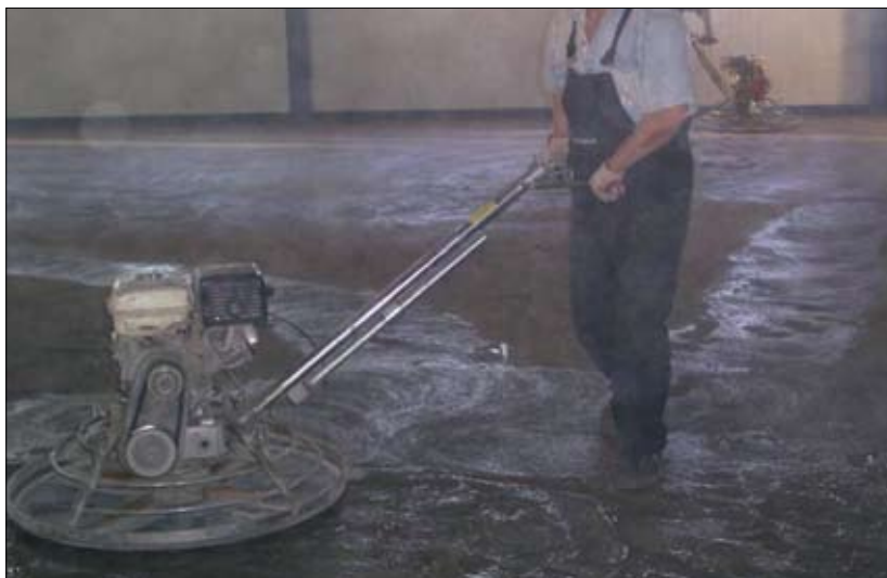
Fot. 4 | Ręczna maszyna do zacierania z łopatkami zacierającymi i widoczny szklisty połysk po zatarciu posypki utwardzającej
