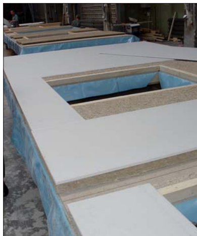
Fot. 4 | Montaż poszycia zewnętrznego
