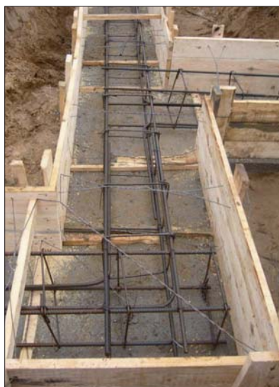
Fot. 1 Deskowanie oraz zbrojenie ław fundamentowych przygotowane do betonowania
