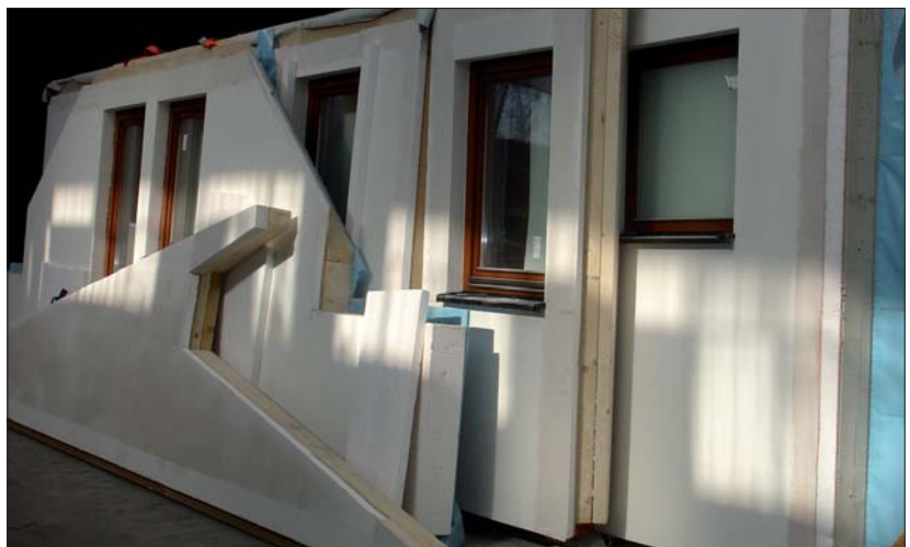
Fot. 6 | Ściany gotowe do montażu
