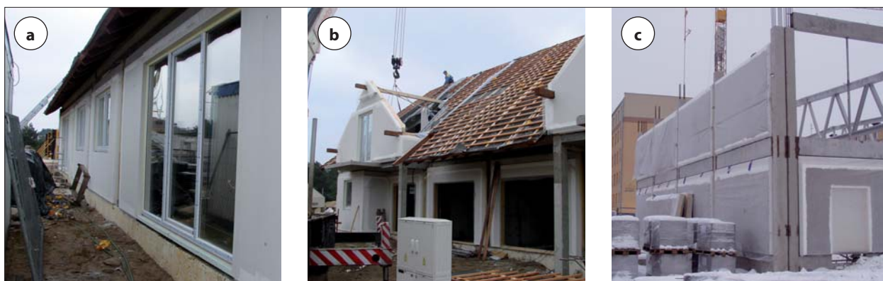
Fot. 7 | Przykłady zastosowań systemu: a) i b) w budownictwie jednorodzinym (fot. Wojciech Nitka), c) przy budowie pawilonu handlowego (fot. Tomasz Szatkowski)
