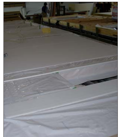
Fot. 5 | Montaż poszycia wewnętrznego
