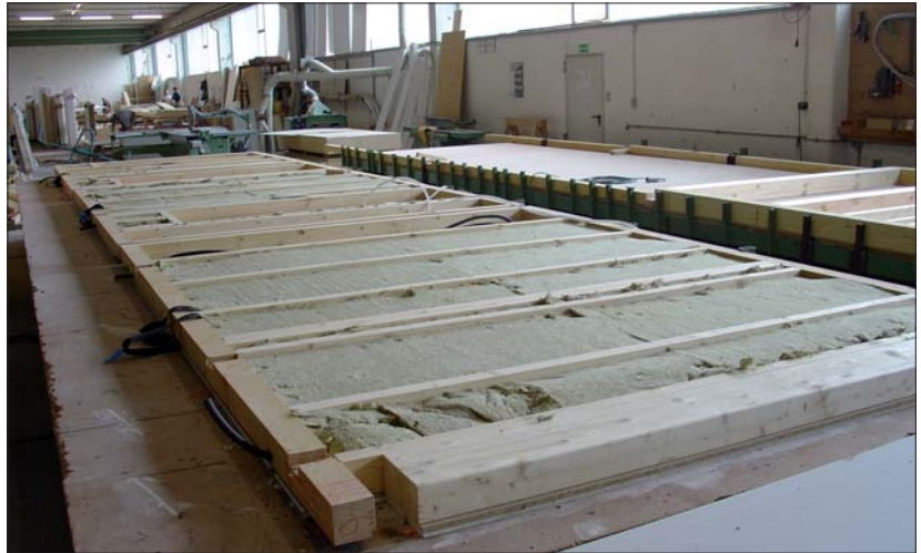
Fot. 3 | Montaż izolacji cieplnej
