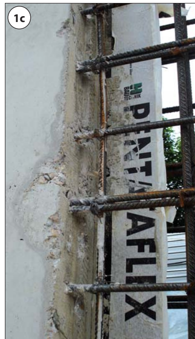
Fot. 1 | W trakcie realizacji „białej wanny”
