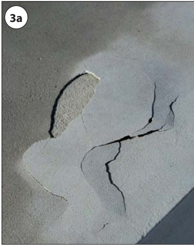
Fot. 3 | Szpachlowanie betonu na zewnątrz
