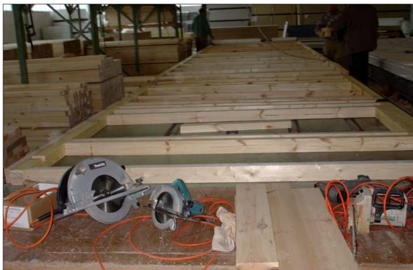
Fot. 2 | Prefabrykacja konstrukcji ścian
