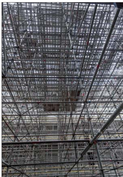
Fot. 2 | Konstrukcja podporowa z rusztowania – widok z dołu
