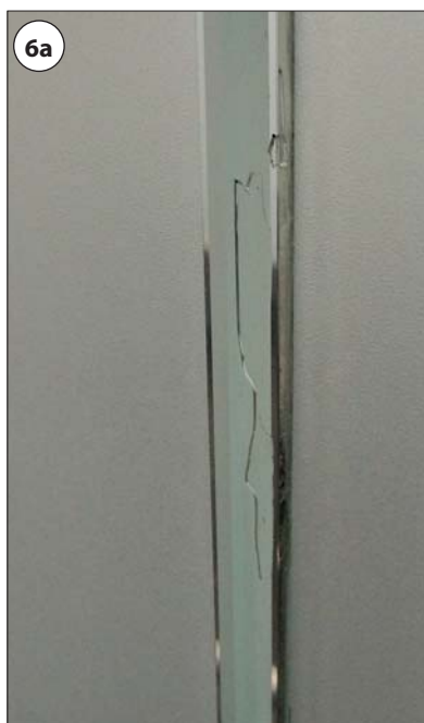
Fot. 6 | Klejenie styków szkła hartowanego
