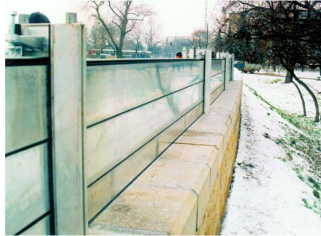
Próbny montaż rozbiieralnej ścianki przeciwpowodziowej DPS 2000 na lewym brzegu Wisły, w zakolu pod Wawelem, luty 2001 r.
