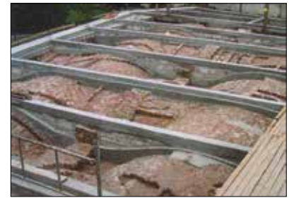
Fot. 2 | Wzmocnienie sklepień ceglanych żebkami żelbetowymi [2]
