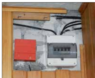
Fot. 2 | Gniazda bezpiecznikowe zastąpione tablicą mieszkaniową z wyłącznikami instalacyjnymi (fot. autora)
