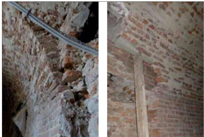
Fot. 1 | Szczegóły oparcia walcowego sklepienia ceglanego na ściany
