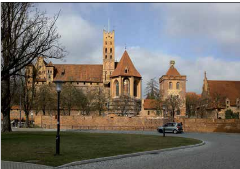
Fot. 2 | Kościół zamkowy po zakończeniu prac budowlano-konserwatorskich w kwietniu 2016 r.
