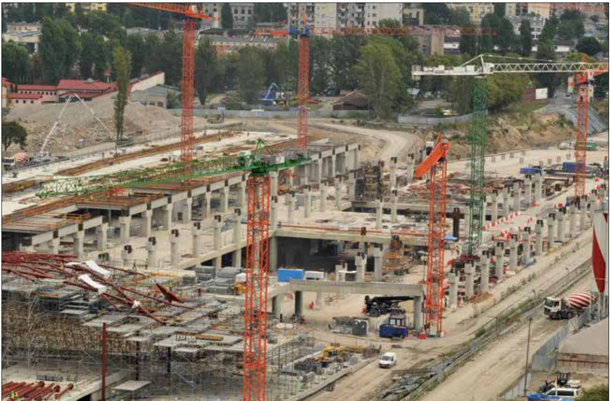
Plac budowy – realizacja metodą „up and down”
