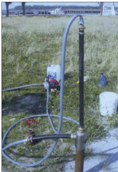
Fot. 6 | Próba ciśnienia i szczelności
