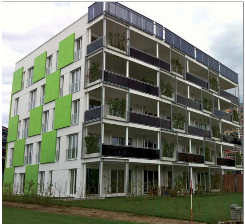
Fot. 4 | Zielone elementy fasady budynku z PCM, panele fotowoltaiczne w formie balustrad balkonowych i dachowej (projekt: biuro Zillerplus)
