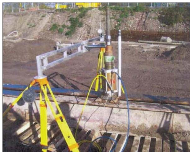
Fot. 5 | Próbné obciążenia mikropala energetycznego
