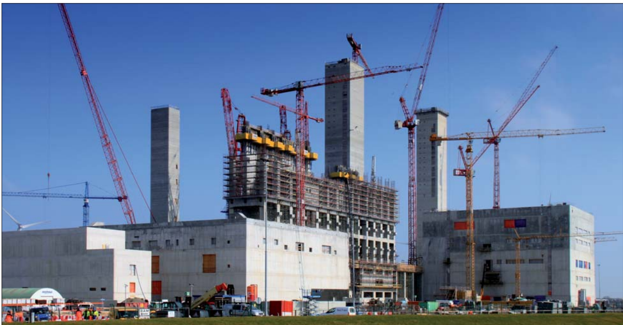
Fot. 1 | Elektrownia w Eemshaven
