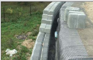
Fot. 6 | Ściana oporowa z semipasywnym licem z blozków betonowych, S7 obwodnica Kielc, 2012 (fot. Inora)
