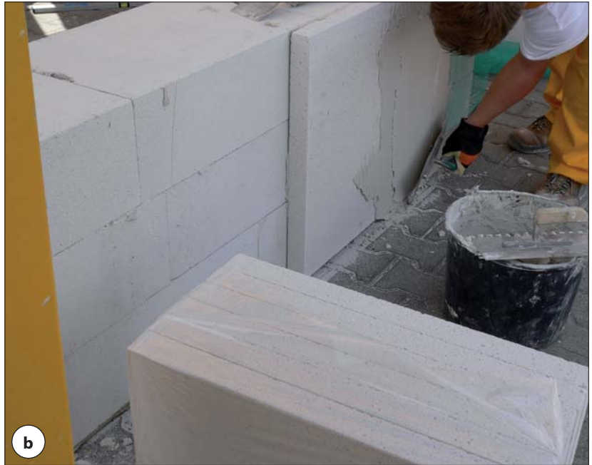
Fot. 1 a) Produkcja płyt do ociepleń (Ytong Multipor), b) przyklejanie płyt
