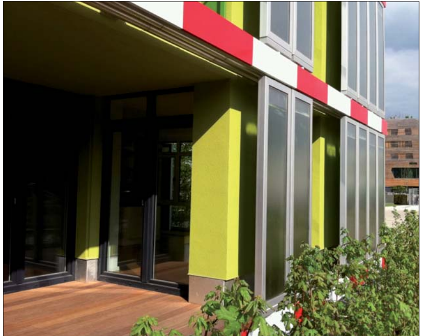
Fot. 3 | Budynek z fasadą biologiczną (SPLITTERWERK, Label für bildende Kunst)
