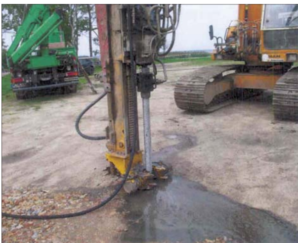
Fot. 4 | Wiercenie mikropala energetycznego
