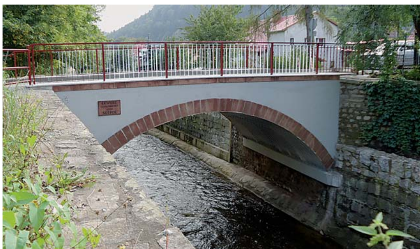
Wzmocnienie mostu przy ulicy Dworskiej w Nowej Rudzie
