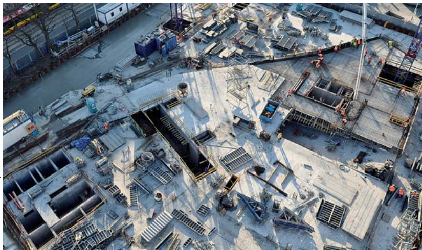
Silver Tower Center w czasie budowy
