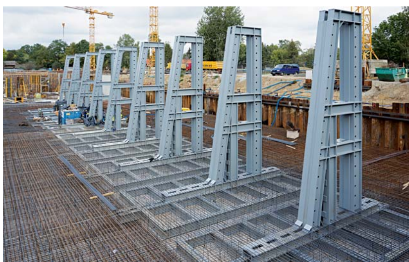
Dolna część słupów podtrzymujących podcień wejściowy, widok zbrojenia sztywnego
