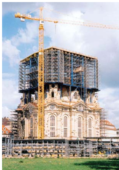
Drezno 2002, Frauenkirche w trakcie odbudowy
