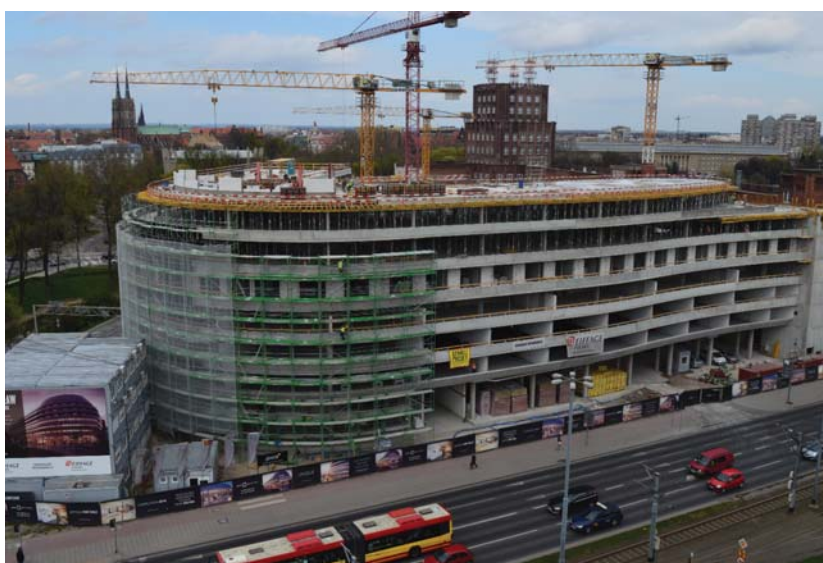
Budowa wielofunkcyjnego budynku OVO od strony ulicy Traugutta
