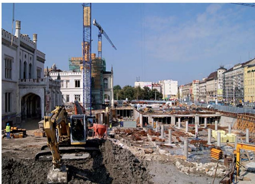
Budowa garażu podziemnego
